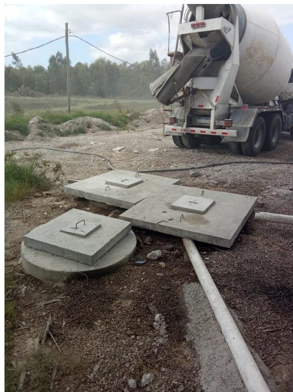
Foto 12.3-4. P03, Obrador. Se construyeron puntos de inspección en la cámara de retención de arenas oleosas.
