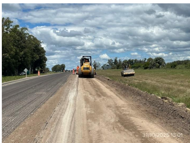
Foto 12.2-3, P07. Perfilado y cementado de base granular en ejecución
