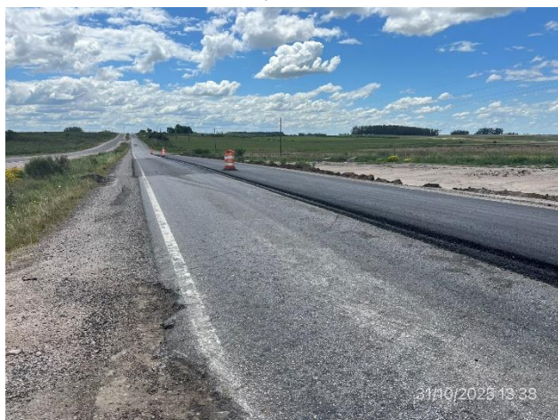
Foto 12.2-5, P07. Tramo de senda a (-) con recapado ejecutado en media calzada
