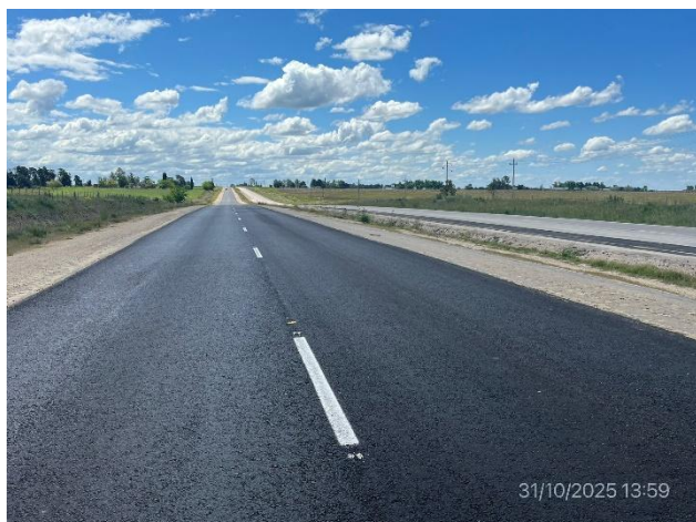
Foto 12.2-7, Ruta 5. Tramo con senda a (-) recapado y con señalización horizontal parcialmente ejecutada.
