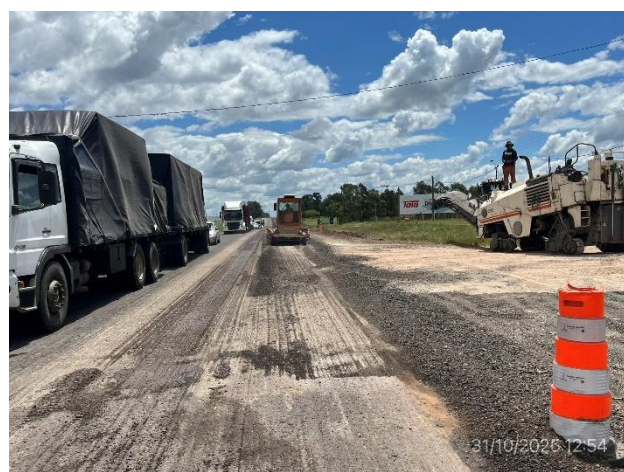
Foto 12.2-4, P07. Escarificado de pavimento existente en ejecución
