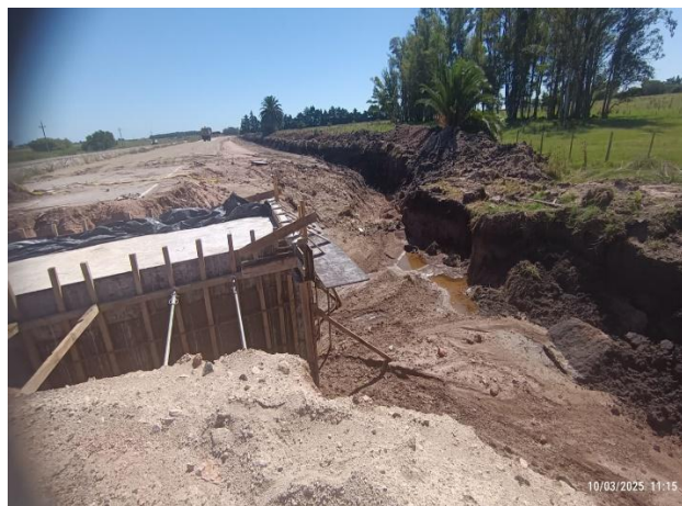
Foto 12.3-2. Alargue de alcantarilla en Ruta 5 progresiva 145K100 a (+). Zona inundable libre de ROCs y otros elementos de construcción.
