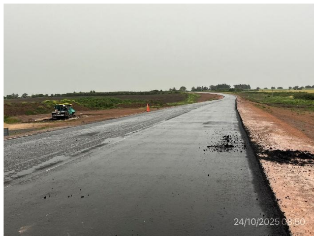
Foto 12.2-8, Accesos a nuevo puente sobre río San Salvador, carpeta de rodadura en ejecución.
