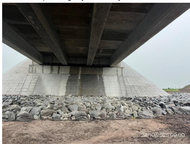
Foto 12.2-4, P01. Protección con rocas de cuartos de cono ejecutada. .
