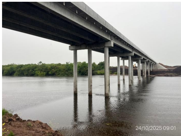
Foto 12.2-2, P01. Estructura del nuevo puente terminada, pilas, vigas y dinteles ejecutados.
