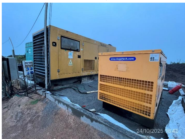
Foto 12.1-5, P04. Generadores eléctricos en recinto envallado impermeable.
