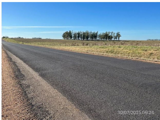
Foto 12.1-3, Ruta 31. Obras terminadas, nueva carpeta en Slurry Seal ejecutada.
