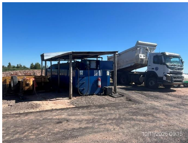
Foto 12.1-2, P03. Obrador, tanque de combustible con envallado perimetral correcto, garantiza estanqueidad.
