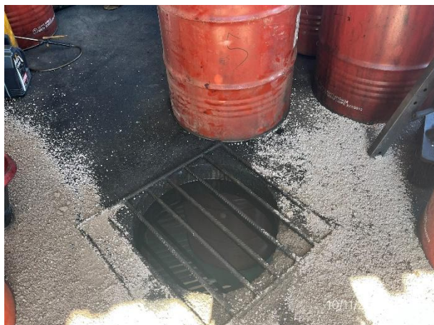
Foto 12.1-7, P03. Obrador, el recinto de lubricantes cuenta con cámara de retención de aguas oleosas.
