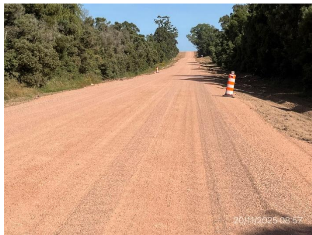
Foto 12.1-4. Tramo parcial de Ruta 16 con plataforma ensanchada y base granular previo a cementado
