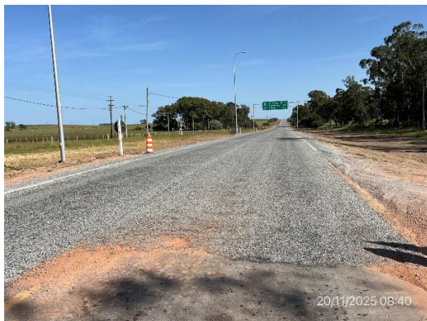
Foto 12.1-3. Tramo parcial de Ruta 16 con carpeta de rodadura en tratamiento bituminoso.
