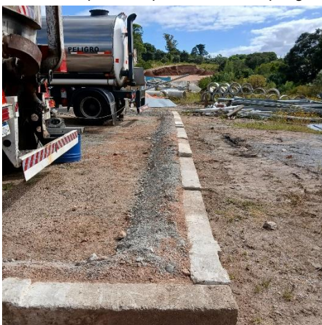
Foto 12.3-3, P04. Se construyó perímetro estanco en estacionamiento de cisternas de asfalto para retener eventuales derrames.
