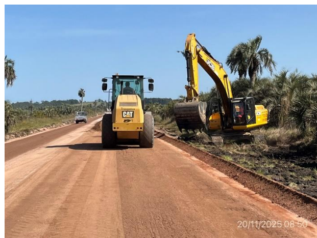
Foto 12.1-6, P06. Frente de obras, Ruta 16 progresiva 4K100. Ensanche de plataforma en ejecución
