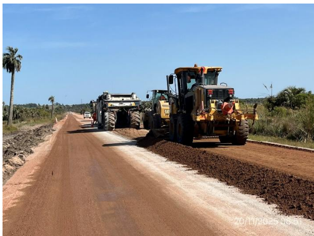
Foto 12.1-7, P06. Frente de obras, cementado de base granular en ejecución.
