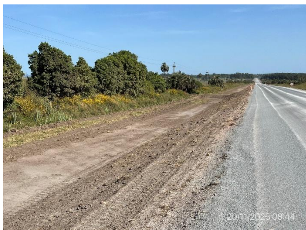
Foto 12.1-5. Tramo parcial de Ruta 16 con plataforma ensanchada y cuneta conformada
