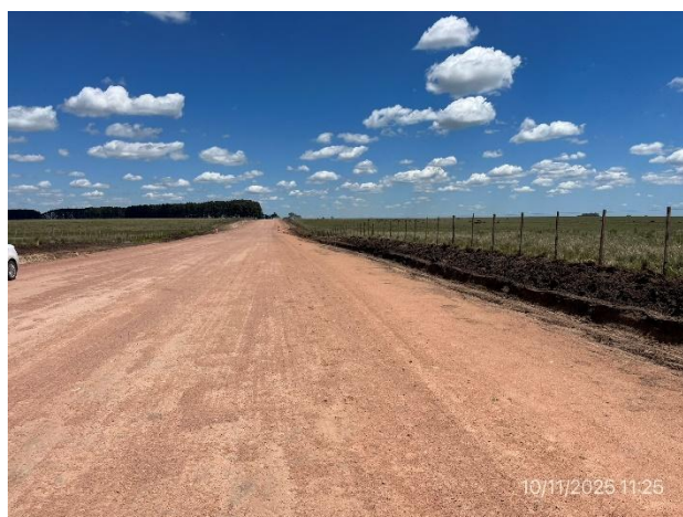
Foto 12.2-10, Ruta 19. Hay un desnivel entre la traza y los predios linderos, se genera un talud con fuerte pendiente.
