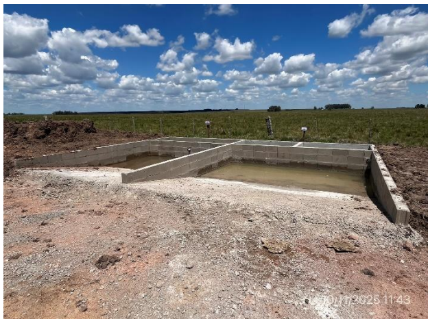
Foto 12.1-9, P03. Planta de hormigón. Pileta de lavado de camiones mixer con decantación y retención de sólidos.
