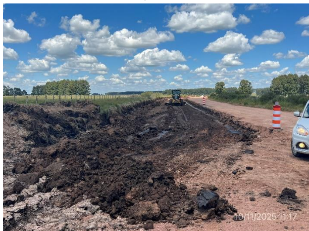
Foto 12.2-5, P05. Frente de obra, Ruta 19 progresiva 13K200. Rectificación de curva en ejecución.
