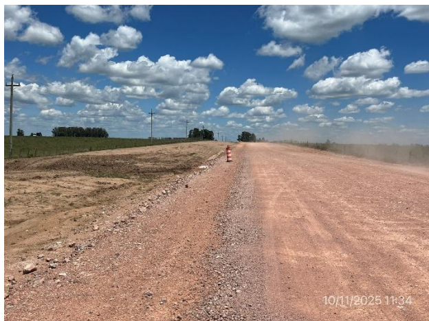
Foto 12.2-11, Ruta 19. Tramo de Ruta 19 con base granular ensanchada.
