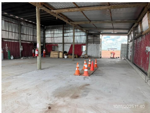
Foto 12.1-5, P03. Sector techado y con pavimento impermeable para taller mecánico en buenas condiciones.
