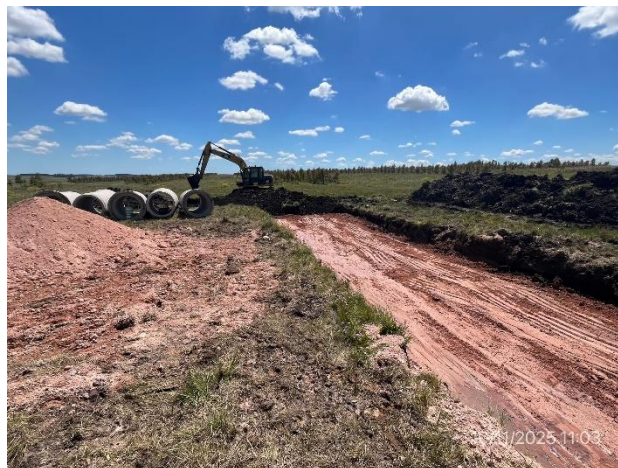
Foto 12.2-2, P04. Frente de obra. Variante de tramo, Ruta 19 progresiva 5K700. Alcantarilla en ejecución.
