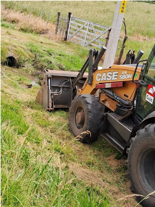
Imagen N°10 Y 11: Mantenimiento de alcantarillas y cunetas ruta 2.
