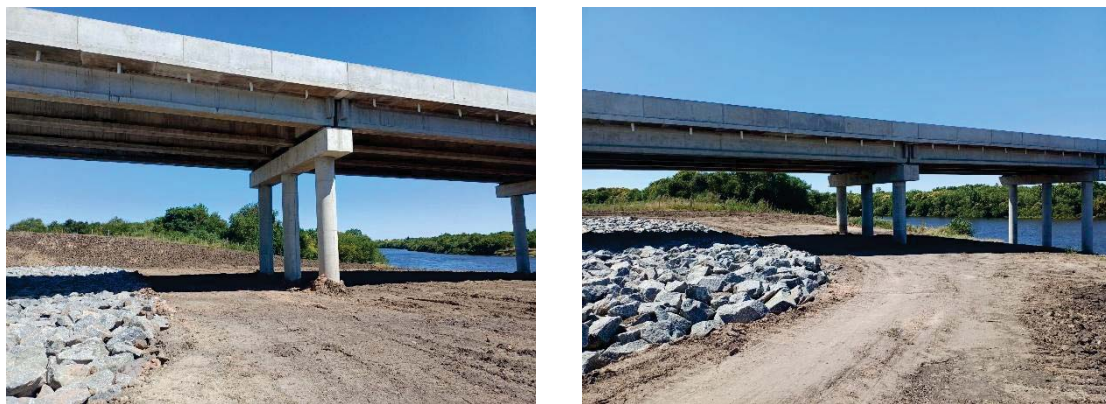
Figura 8-9: Pasafauna seco bajo el puente, ribera Sur (izquierda - 390824.59 m E; 6289240.03 m S) y ribera Norte (derecha - 390902.69 m E; 6289377.93 m S).
