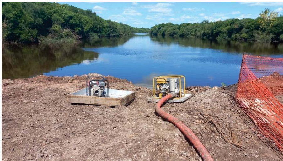
Figura 6-2: Generadores sobre bandejas de contención en frente de obra.
