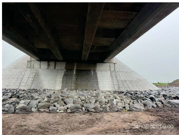
Foto 12.2-4, P01. Protección con rocas de cuartos de cono ejecutada.
