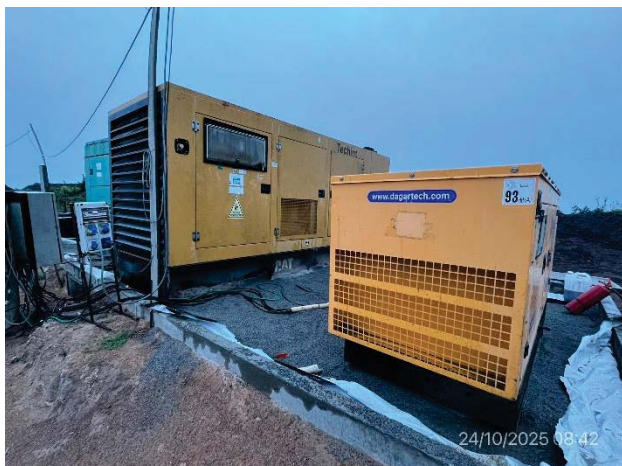
Foto 12.1-5, P04. Generadores eléctricos en recinto envallado impermeable.
