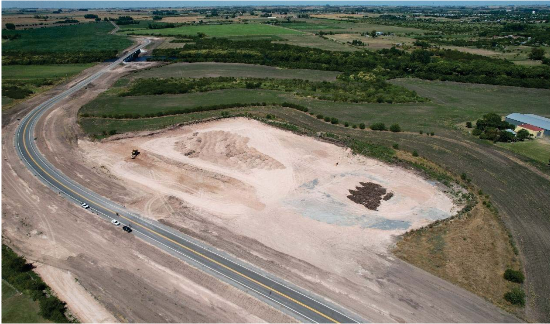
Figura 8-4: Cantera explotada por Suelo Firme en etapa de restauración, de acuerdo con lo indicado en la sección 7.1.2. Se retiró la planta asfáltica y se redistribuyeron los acopios.
