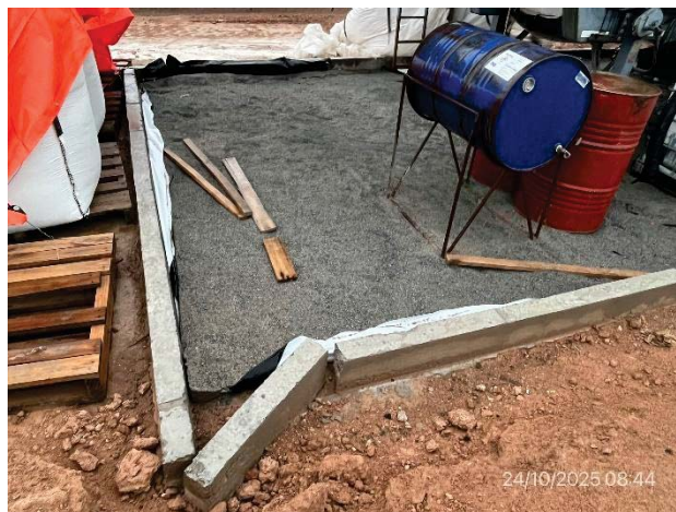
Foto 12.1-8, P04. Planta asfáltica, el envallado perimetral está dañado y perdió la estanqueidad original.
