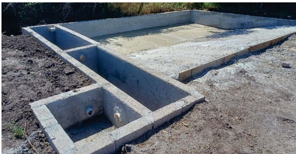
Figura 2-7: Sistema de lavado de hormigón.
