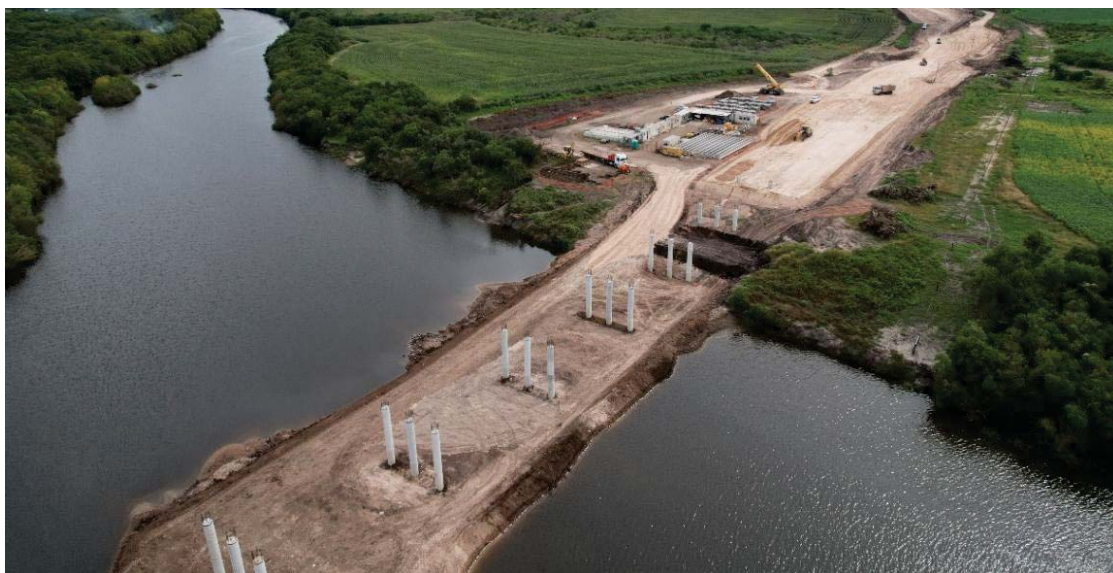
Figura 2-12: Vista general de la atagüa y el obrador, en la ribera Norte del río San Salvador (marzo de 2025).
