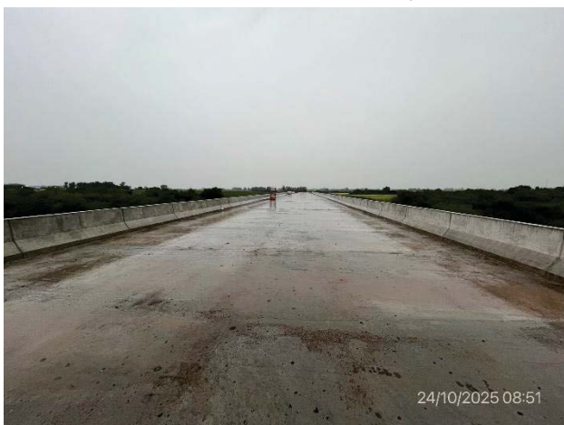
Foto 12.2-5, P01. Puente sobre río San Salvador, tablero y vigas New Jersey terminadas.
