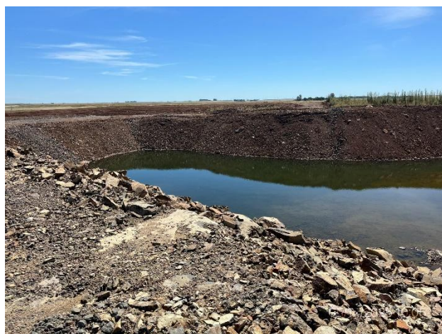
Foto 12.1-11, P03. Cantera, se suavizaron los taludes en el frente de explotación.
