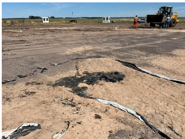
Foto 12.1-5, P03. Hay suelos contaminados con derrames pendientes de ser retirados.
