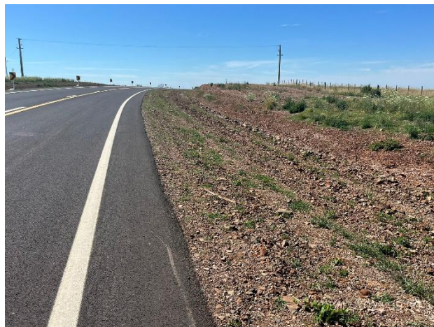
Foto 12.2-4. Ruta 20, faja pública con taludes y contrataludes con pendiente suave y empastado vegetal en crecimiento.
