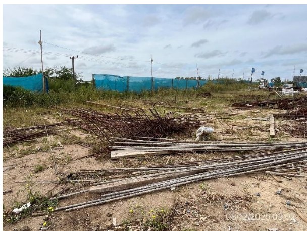
Foto 12.2-11, P04. Estación de acopio de barras metálicas , zona desordenada y con malezas circundantes.
