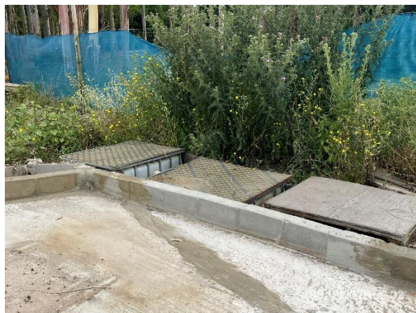
Foto 12.2-10, P04. Trampa de decantación de aguas de lavado de hormigón
