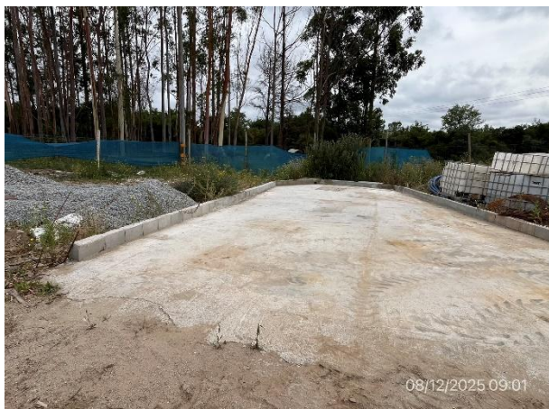
Foto 12.2-9, P04. Platea impermeable para lavado de camiones.
