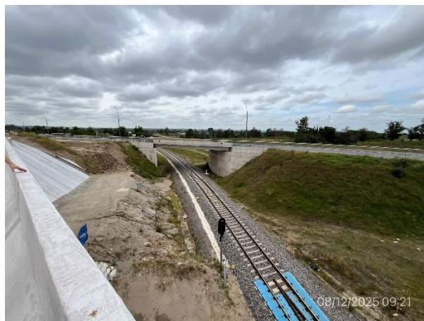
Foto 12.1-10, P04. Pasaje provisorio sobre vía férrea pendiente de ser demolido al momento de habilitar el tránsito por el pasaje superior definitivo.
