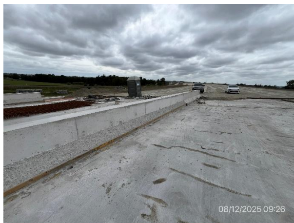
Foto 12.1-14, P03. Estructura de Tablero superior en doble vía terminada
