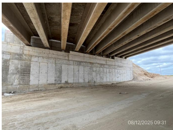
Foto 12.1-15, P03. Estructuras de vigas y estribos terminadas
