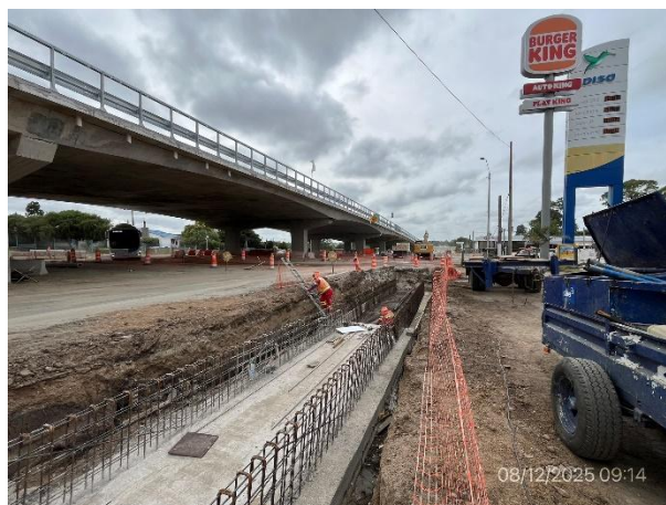
Foto 12.1-6, P01. Frente de obras, ejecución de armaduras en proceso.
