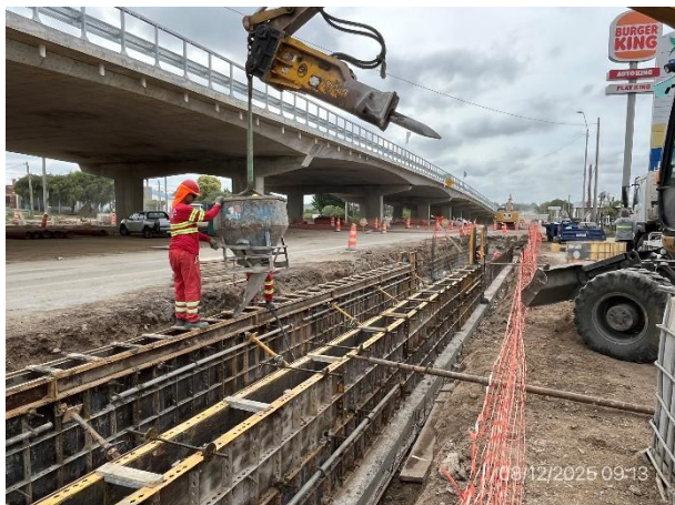
Foto 12.1-7, P01. Frente de obras, hormigonado en proceso.
