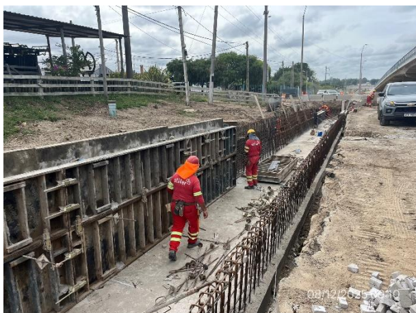
Foto 12.1-5, P01. Frente de obras, ejecución de encofrados en proceso.
