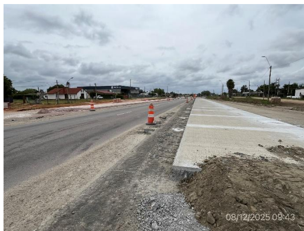
Foto 12.2-2. Duplicación de Ruta 5 en ejecución. Tramo ejecutado de calzada en hormigón en senda a (+).
