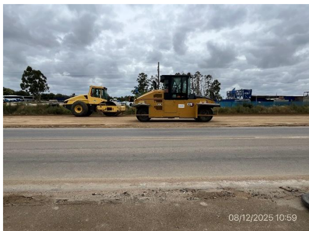
Foto 12.2-5, P08. Frente de obras, compactación de base granular en ejecución.
