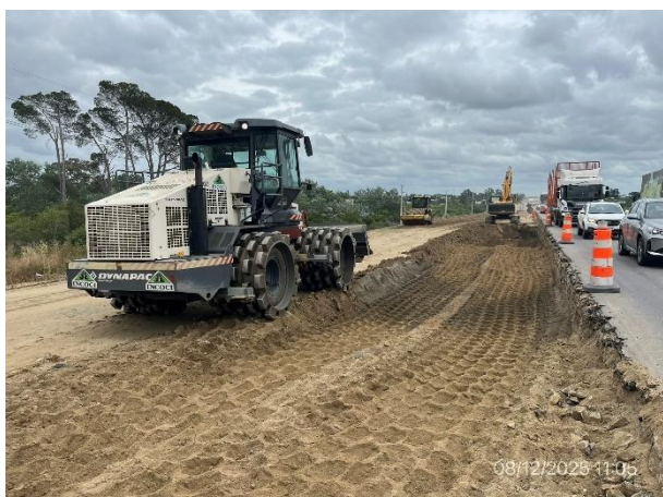
Foto 12.2-9, P09. Frente de obras, sustitución y recargo granular en ejecución.
