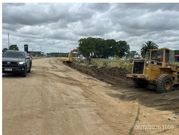
Foto 12.2-10, P09. Frente de obras, excavaciones y apertura de caja en ejecución.
