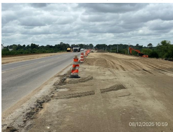
Foto 12.2-4, P08. Frente de obras de recargo granular. Ruta 5 progresiva 97K300.
