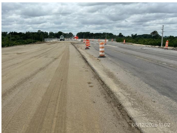
Foto 12.2-7, P08. Base granular perfilada en acceso a puente sobre río Santa Lucía chico.
