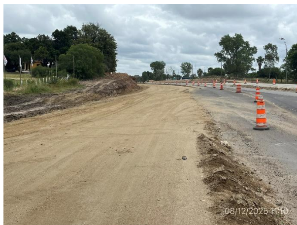
Foto 12.2-8, P09. Frente de obras, perfilado de base granular en ejecución. Ruta 5 progresiva 95K600
