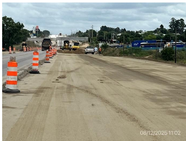
Foto 12.2-6, P08. Frente de obras, perfilado de base granular en ejecución.
