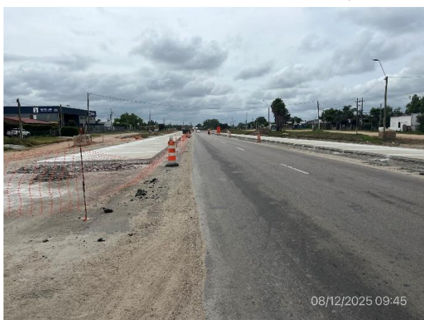
Foto 12.2-3. Duplicación de Ruta 5 en ejecución. Tramo ejecutado de calzada en hormigón en ambas sendas.
