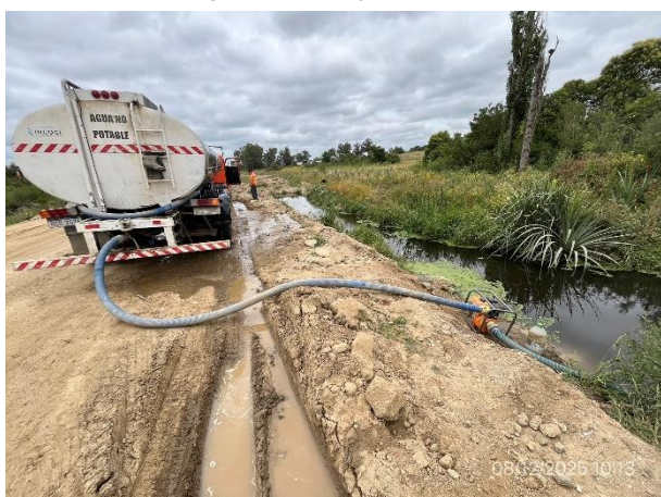
Foto 12.2-11. Camino lateral de Ruta 5. Se extrae agua con motobomba apoyada directamente sobre suelo desnudo, sin bandeja estanca u otro elemento de contención.
