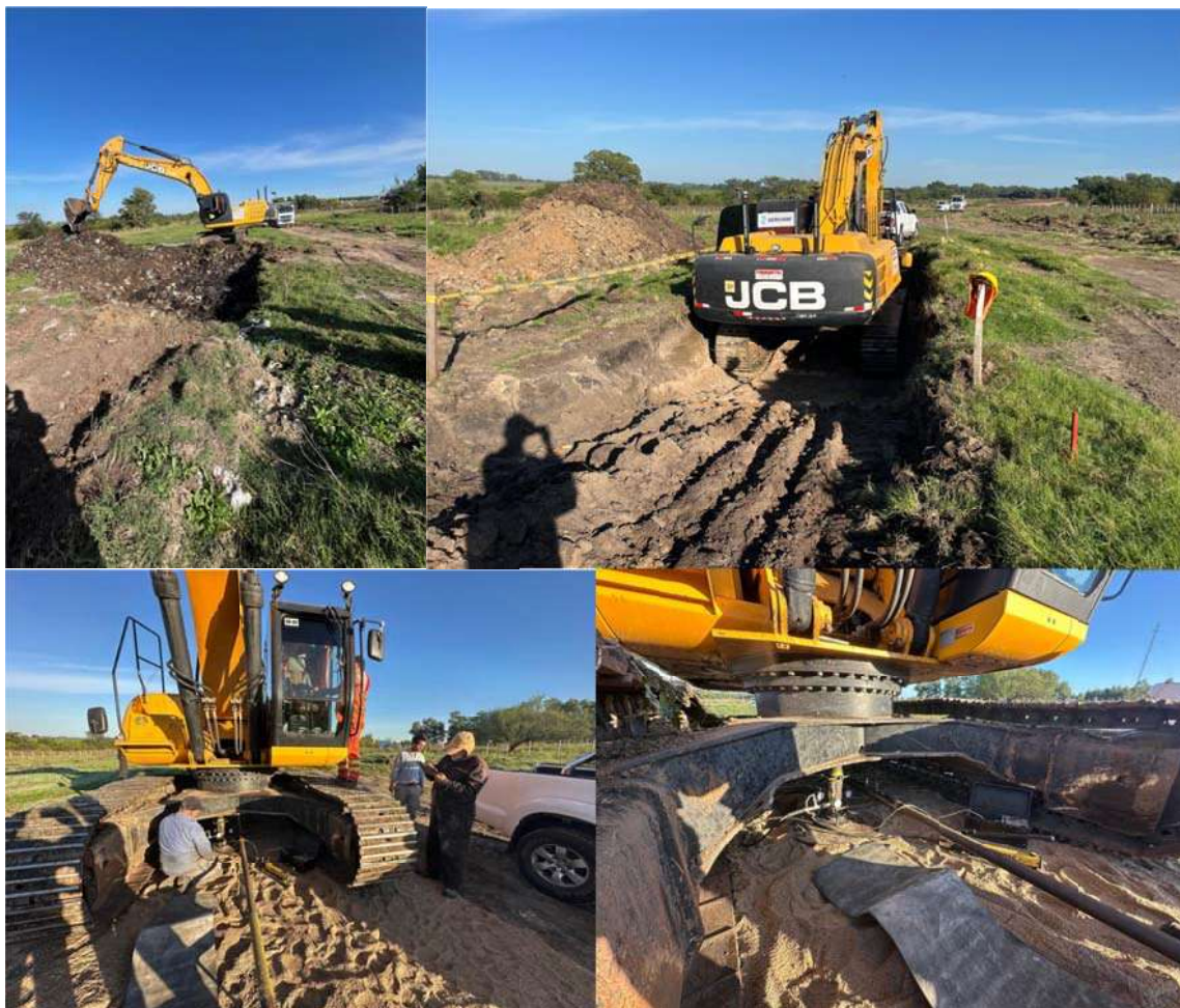
Figura 2. Imágenes de la Preparación y ejecución de un ensayo de Placa de Carga
