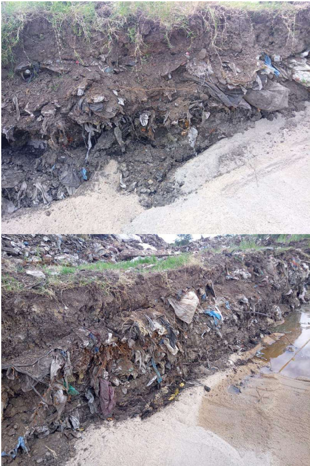
Figura 5. Imágenes de una excavación donde se puede apreciar el relleno presente
