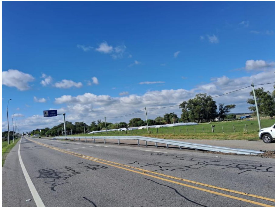
Imagen N°8, 9 Y 10: Instalación de defensas metálicas ruta 23 Ismael Cortinas
