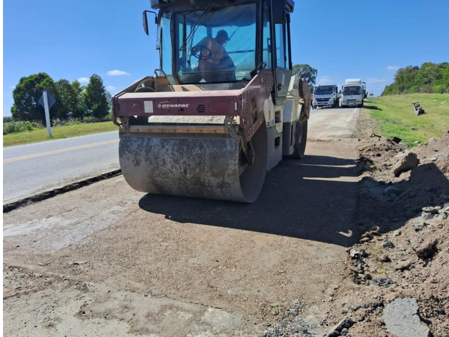
Imagen N°11: compactación tosca-cemento en bache ensanche 1 ruta 23
