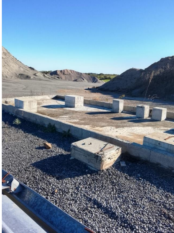
Imagen N°4: Bandeja donde estaba la Planta Asfáltica.
