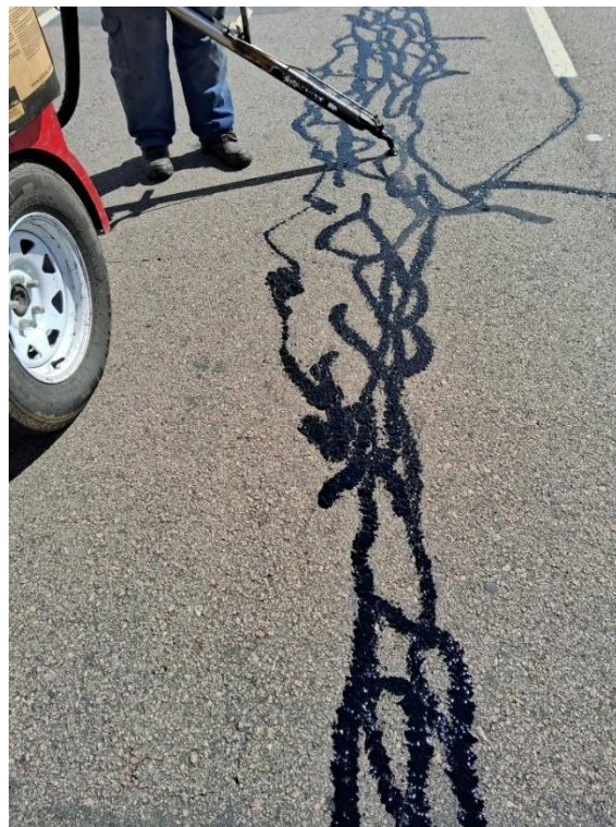
Imagen N°12: Sellado por puenteo en calzada.
