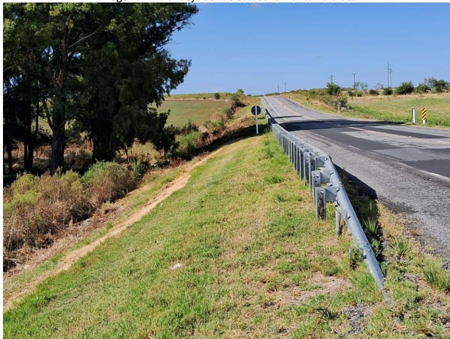
Imagen N°5: Corte de pasto detrás de las defensas metálicas ruta.
