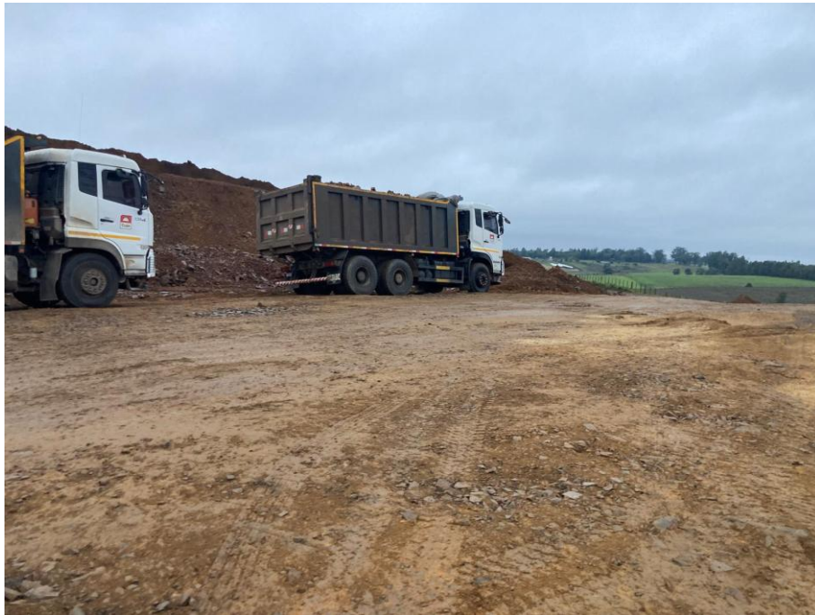
Imagen N° 9. Ingreso de la cantera. Coordendas 34° 7'17.66"S 56°58'21.65"O.
