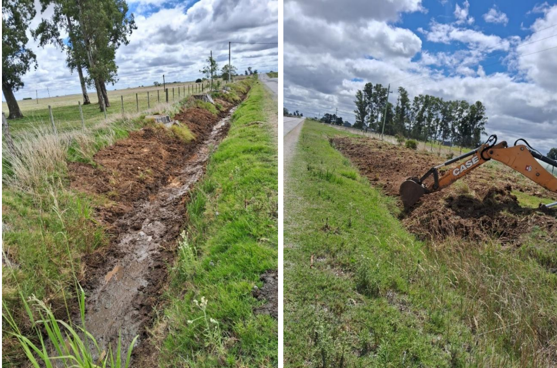
Imagen N°6 Y 7: limpieza de cunetas y alcantarillas ruta 2.
