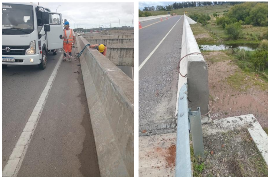
Ilustración 4 Reparación puntual de barreras New Jersey de hormigón en sector de puente y borde de calzada.
