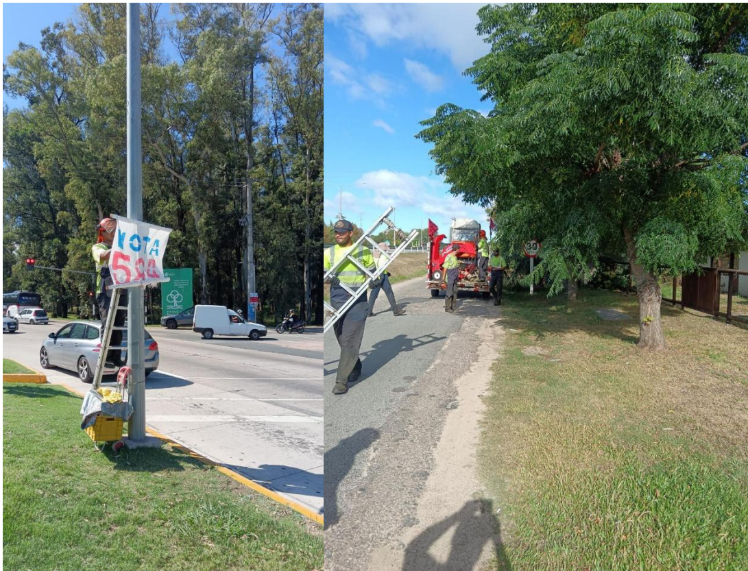
Tareas de limpieza, retiro de restos vegetales y mantenimiento de áreas verdes en faja vial y cantero central – febrero/abril 2026.
