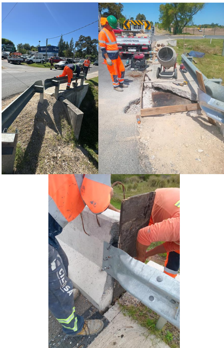
Ilustración 3 Mantenimiento y acondicionamiento de defensas metálicas y elementos de seguridad vial en sector de borde de calzada.
