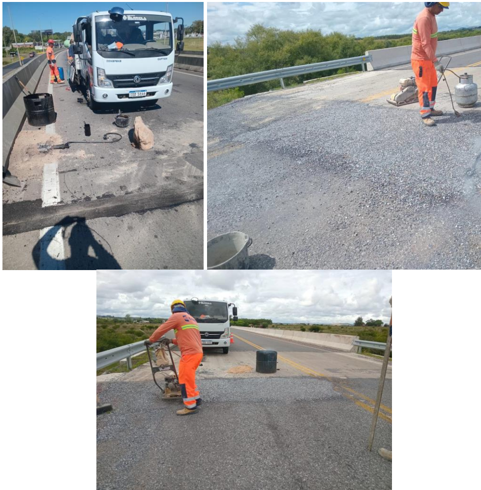
Ilustración 1 Reparación puntual de calzada sobre puente, con preparación del área, colocación de mezcla asfáltica y compactación del sector intervenido.
