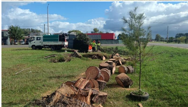
Extracción de dos Pinos– El Pinar – febrero/abril 2026
