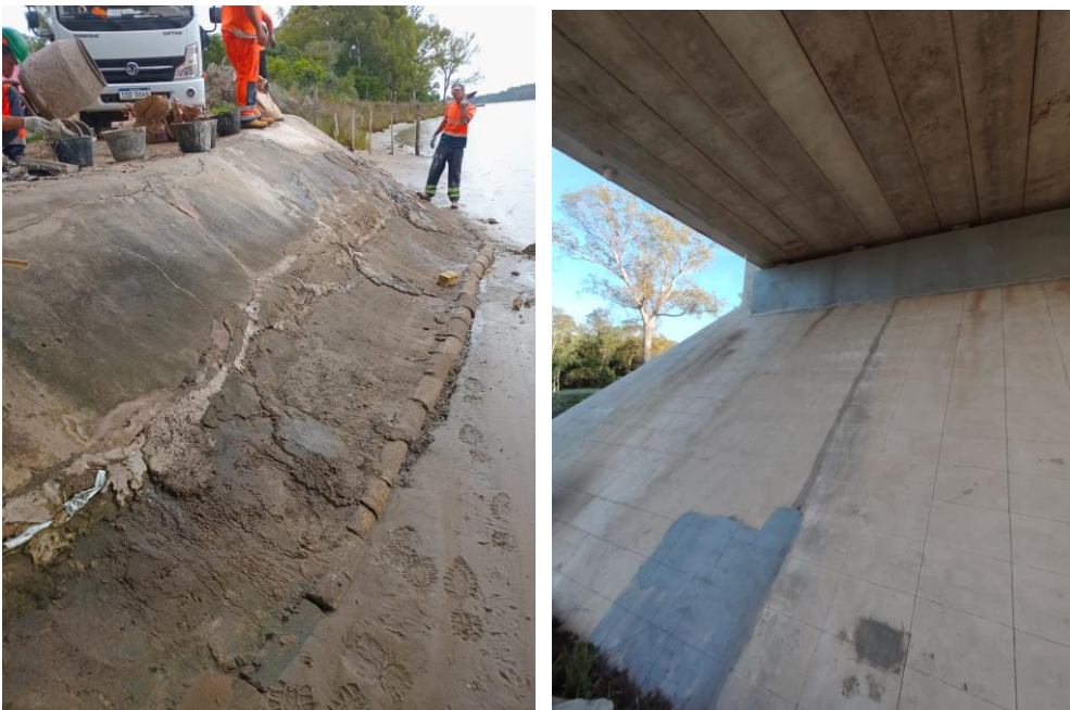
Ilustración 2 Reparación y acondicionamiento de estructura de hormigón en cuarto de cono y elementos de protección asociados.
