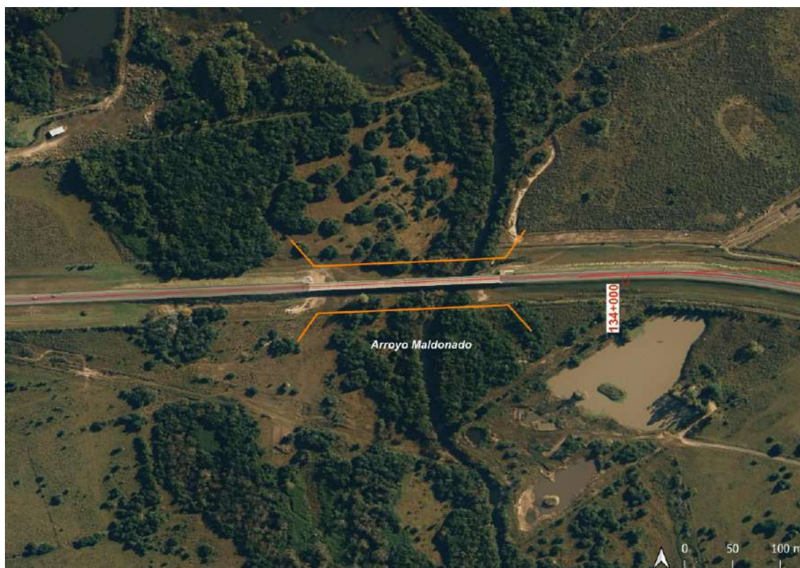
Figura 3-6: Puente arroyo Maldonado
