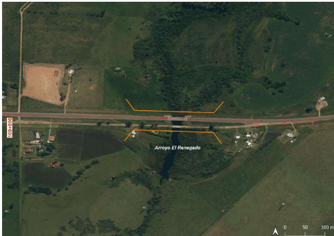
Figura 3-2: Puente arroyo El Renegado.
