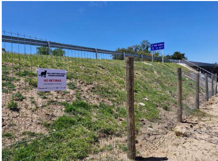
Ilustración 4: Vallado puente sobre A° José Ignacio.
