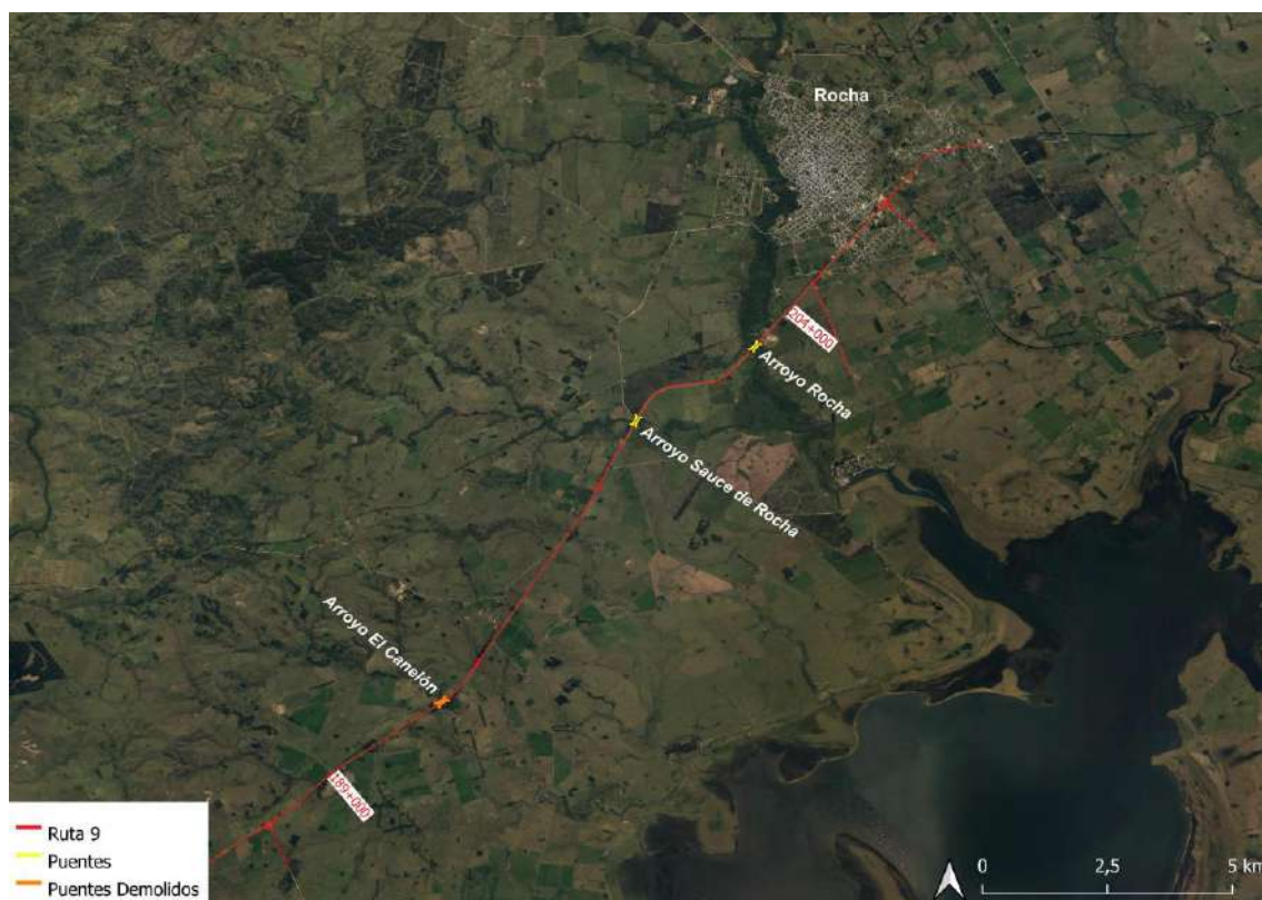
Figura 3-15: Puentes demolidos en tramo progresivas 184+000 a 210+000.
