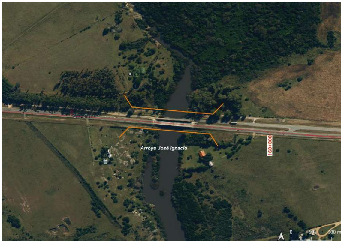
Figura 3-8: Puente arroyo José Ignacio
