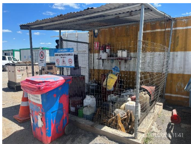
Foto 12.2-11, P03. Obrador. Sector techado y envallado para acopio de lubricantes.
