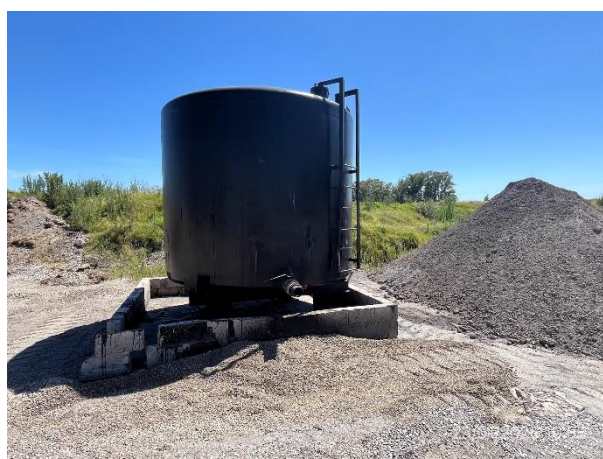
Foto 12.2-6, P03. Tanque de emulsión, el envallado perimetral tiene perforaciones que disminuyen su capacidad.
