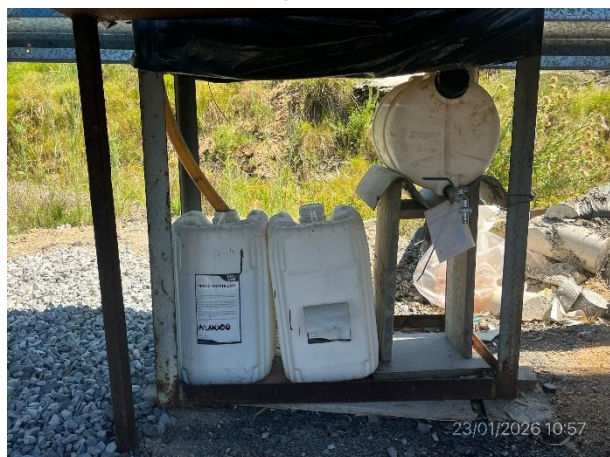
Foto 12.2-9, P03. Laboratorio de asfalto. El percloroetileno usado se almacena en bidones. La bandeja metálica no tiene volumen suficiente.
