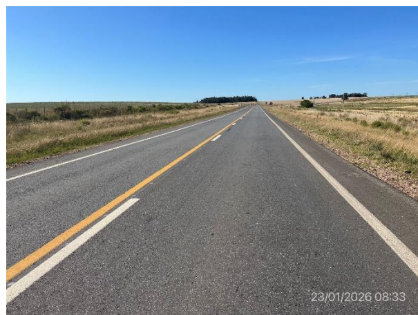
Foto 12.1-2. Tramo de Ruta 6 con calzada ensanchada y nueva carpeta de rodadura en mezcla asfáltica ejecutada.
