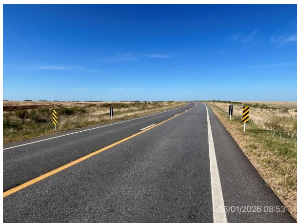
Foto 12.1-5. Tramo de Ruta 6 con obras de señalización horizontal y vertical ejecutadas.
