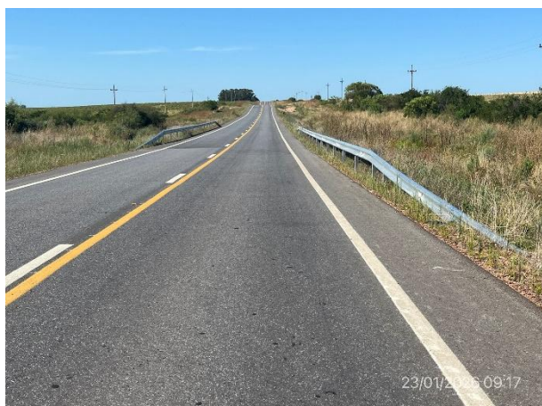
Foto 12.1-1, P01. Inicio de tramo. Ruta 6 Progresiva 129K900.
