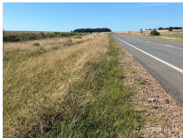
Foto 12.1-4, Faja pública de Ruta 6. Senda a (-) con buena conformación de drenaje y cobertura vegetal abundante.
