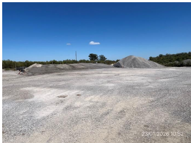
Foto 12.2-7, P03. Explanada de maniobras y para acopio de áridos, limpia y libre de residuos.
