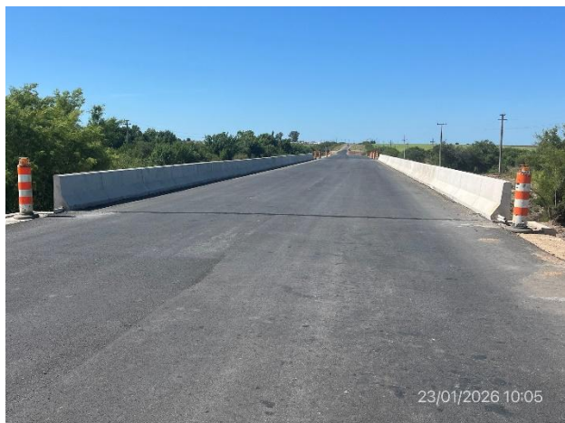
Foto 12.2-7, P02. Puente sobre A° Tornero Grande, Ruta 6 progresiva 122K130. Accesos terminados. Resta ejecutar las obras de señalización y defensas metálicas.
