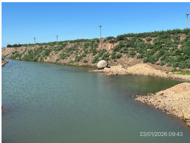
Foto 12.1-15, P06. Se suavizaron los taludes en el frente de explotación.
