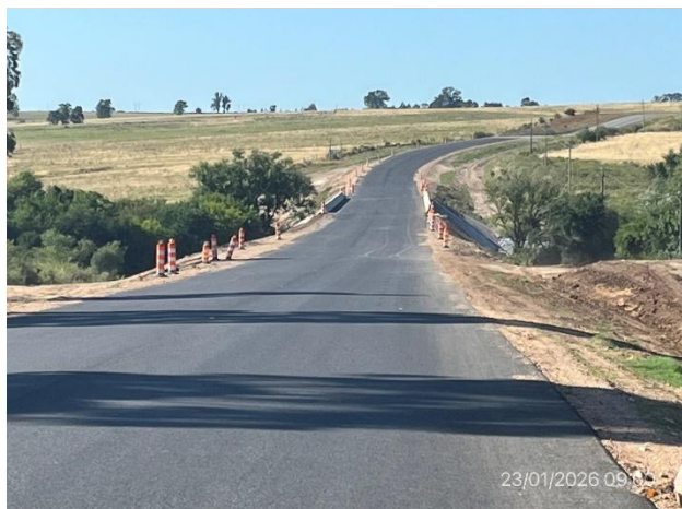
Foto 12.2-19, P04. Nuevo puente sobre A° Talita, Ruta 6 progresiva 136K140. Accesos terminados. Resta ejecutar las obras de señalización y defensas metálicas.
