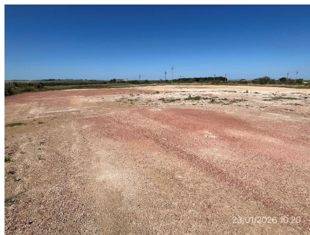
Foto 12.1-10, P05, Planta de hormigón de SACEEM abandonada. Padrón rural N° 8649, 2ª SC. de Florida. Ruta 6 progresiva 120K700 a (+).
