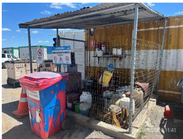
Foto 12.1-9, P07. Obrador. Sector techado y envallado para acopio de lubricantes.
