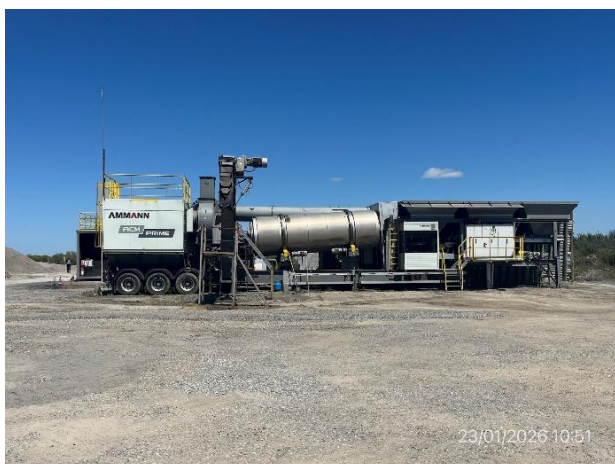
Foto 12.1-1, P07. Planta asfáltica y Obrador de Grinor SA sin actividad.
