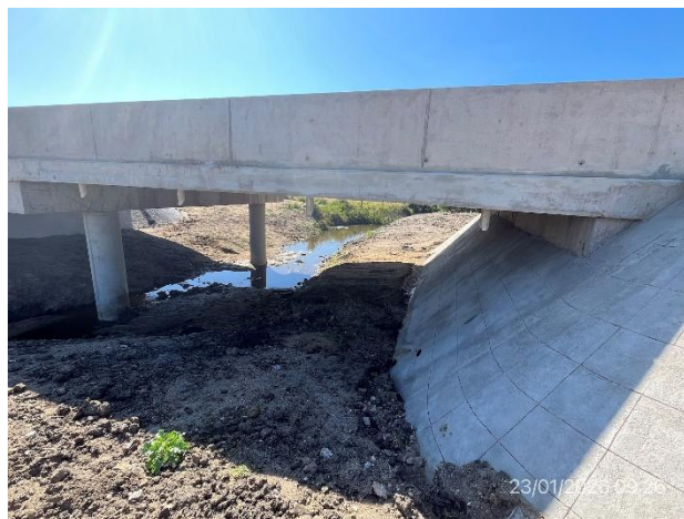
Foto 12.2-14, P03. Obra estructural del puente terminada.
