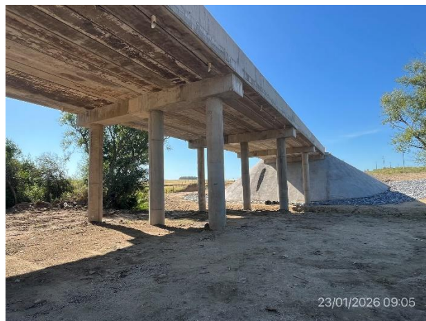
Foto 12.2-20, P04. Obra estructural del puente terminada. Planicie de inundación libre de residuos. Enrocado de protección colocado.
