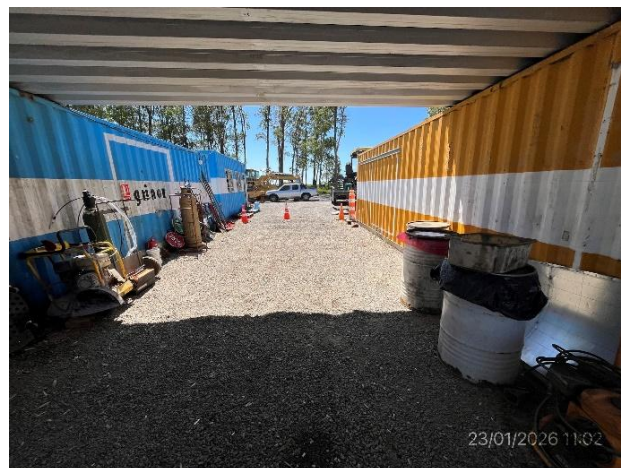
Foto 12.1-8, P07. Obrador. Está presente la infraestructura para acopio temporal de residuos segregados en origen.
