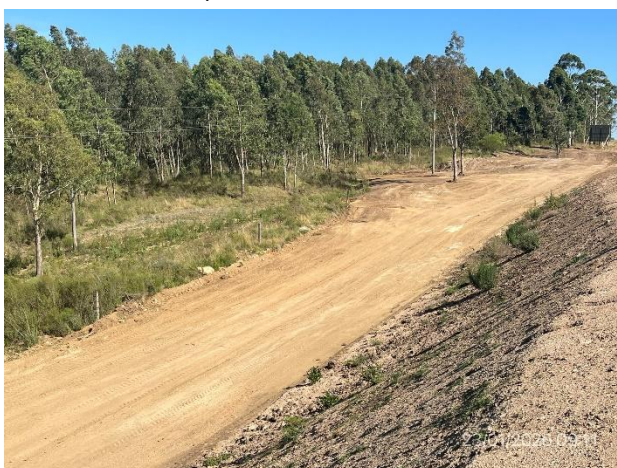
Foto 12.2-22, P04. Campamento provisional desmantelado, zona limpia y libre de ROCs.
