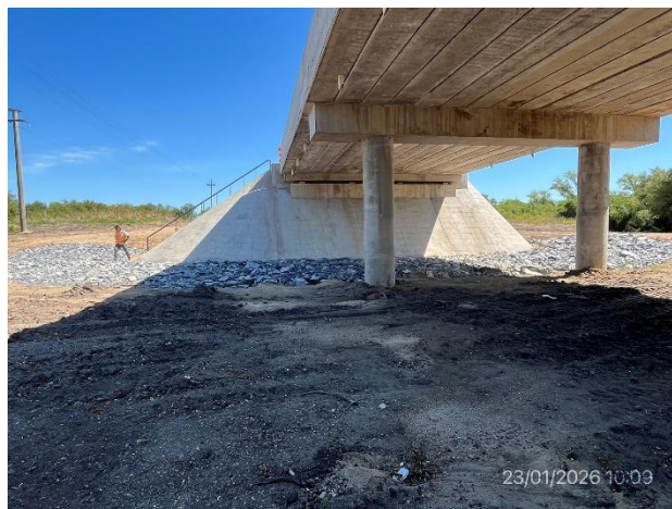
Foto 12.2-8, P02. Obra estructural del puente terminada. Enrocado de protección ejecutado.
