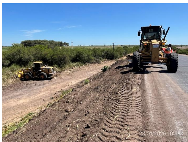
Foto 12.2-5, P01. Frente de obra, talud de acceso Sur. Está en ejecución la conformación del talud de la senda a (-).
