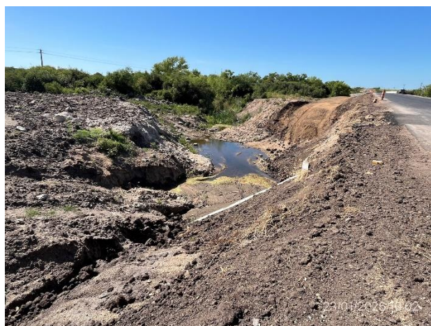
Foto 12.2-10, P02. Alcantarilla lateral sobre A° Tornero Grande. Está pendiente la conformación de cunetas y perfilado de taludes en sendas a (+) y a (-).
