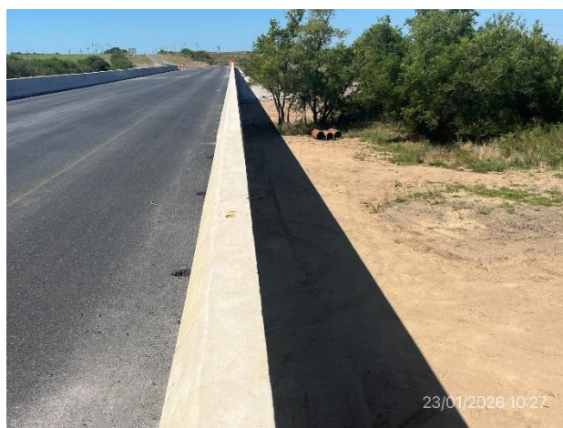
Foto 12.2-4, P01. Campamento provisional desmantelado. Restan caños de entubado provisional por retirar.
