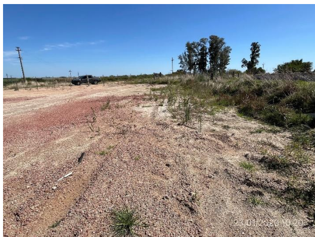
Foto 12.1-11, P05, Plataforma granular compactada, permanece como eventual mejora a beneficio del propietario.
