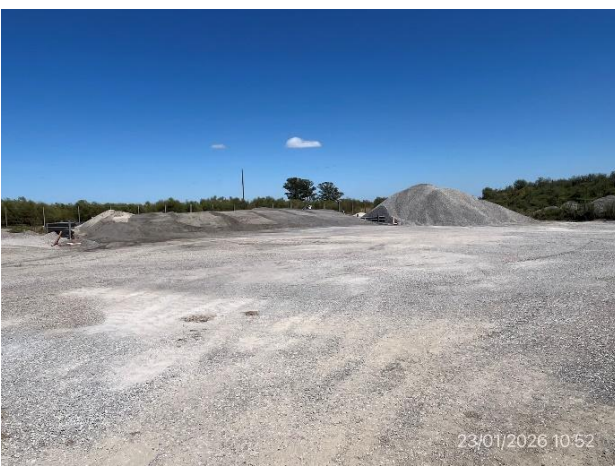
Foto 12.1-5, P07. Explanada de maniobras y para acopio de áridos, limpia y libre de residuos.
