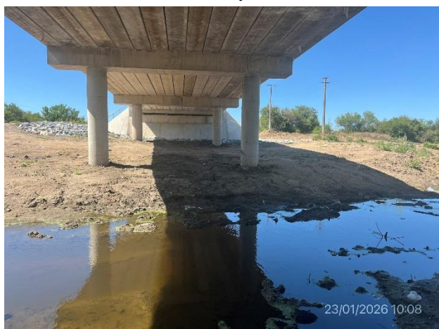
Foto 12.2-9, P02. Curso de agua en condiciones de estiaje. Está pendiente la ejecución de la batimetría ex – post. Planicie de inundación libre de residuos.
