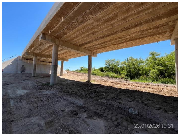
Foto 12.2-2, P01. Obra estructural del puente terminada.
