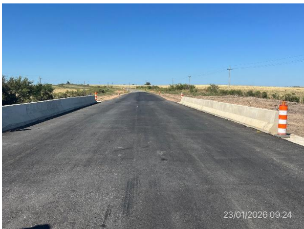
Foto 12.2-13, P03. Puentes sobre A° Tornero Chico, Ruta 6 progresiva 128K810. Accesos terminados. Resta ejecutar las obras de señalización y defensas metálicas.
