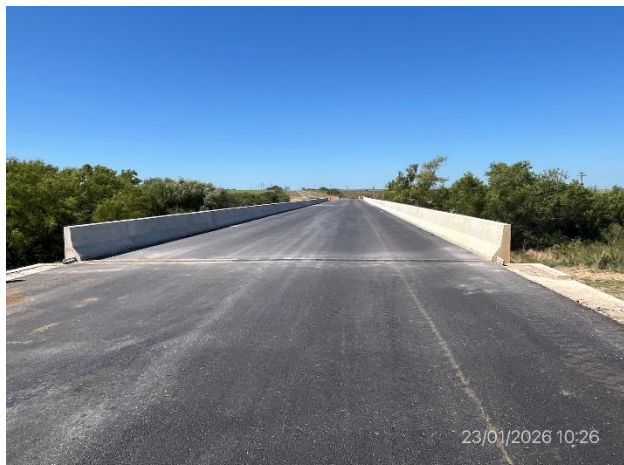
Foto 12.2-1, P01, Puente sobre Río S ta Lucía Chico. Ruta 6 progresiva 119K660. Accesos terminados. Resta ejecutar las obras de señalización y defensas metálicas.
