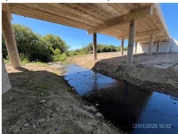
Foto 12.2-3, P01. Curso de agua en condiciones de estiaje. Está pendiente la ejecución de la batimetría ex – post. Planicie de inundación libre de residuos.
