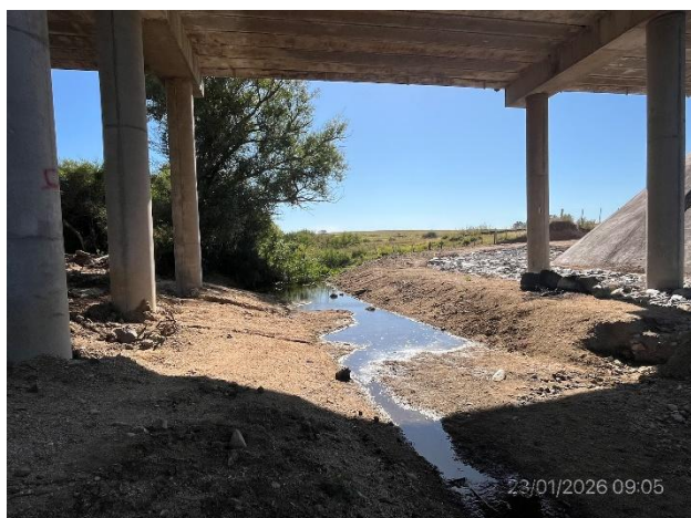
Foto 12.2-21, P04. Curso de agua en condiciones de estiaje. Está pendiente la ejecución de la batimetría ex – post. Planicie de inundación libre de residuos.
