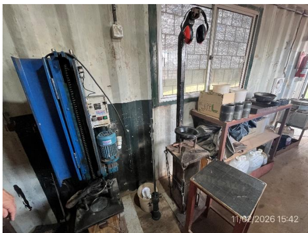
Foto 12.1-4, P03. Laboratorio de asfalto, buenas condiciones de orden y limpieza.
