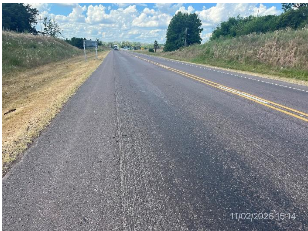
Foto 12.2-1, Ruta 5. Escarificado realizado en senda a (-). Está pendiente la reposición de la señalización horizontal.
