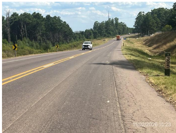
Foto 12.2-2, Ruta 5. Escarificado realizado en senda a (+). Está pendiente la reposición de la señalización horizontal.
