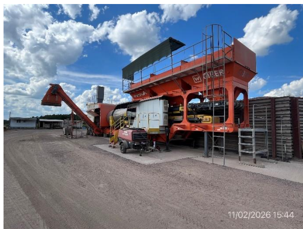
Foto 12.1-2. P03. Planta asfáltica, explanada ordenada y en buenas condiciones de limpieza.
