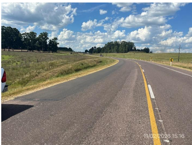
Foto 12.2-3, Ruta 5. Bacheo ejecutado en banquetas de la senda a (-). Está pendiente la reposición de la señalización horizontal
