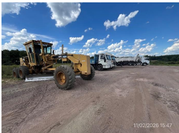
Foto 12.1-11, P03. Obrador, plataforma de estacionamiento y maniobras para maquinaria ordenada y nivelada.
