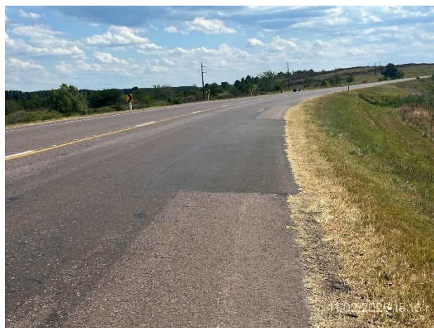
Foto 12.2-4, Ruta 5. Bacheo ejecutado en banquetas de la senda a (+). Está pendiente la reposición de la señalización horizontal
