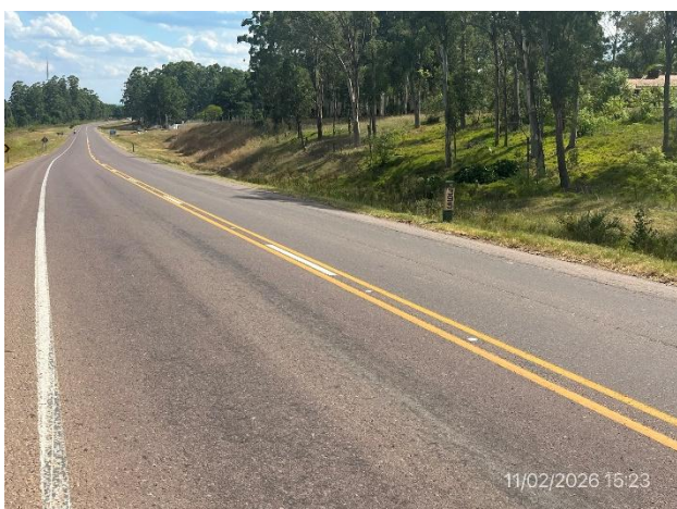
Foto 12.2-5, Ruta 5. Faja pública con buena cobertura vegetal en zona donde se realizó recado de mezcla asfáltica
