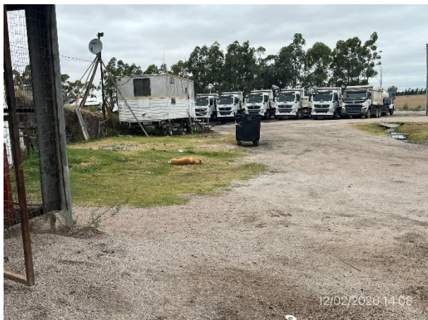
Foto 12.2-1, P03. Obrador, planta asfáltica y cantera de granito de EDASA. Ruta 5 progresiva 178K400 a (+).
