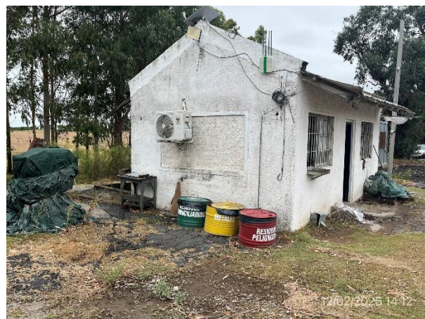
Foto 12.2-6, P03. Obrador, estación correcta para acopio segregado de residuos.
