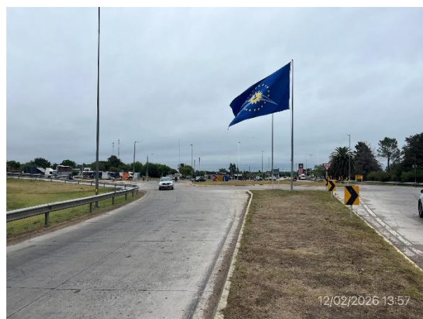
Foto 12.1-6, P01. Inicio del tramo de mantenimiento. Ruta 5 progresiva 182K700, empalme con Ruta 14.
