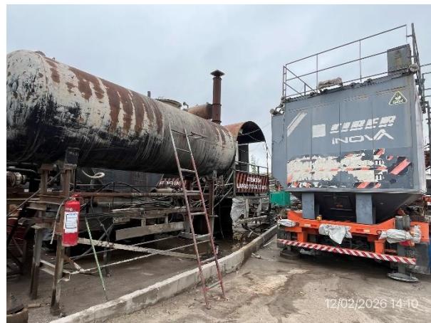
Foto 12.2-2, P03. Planta asfáltica, envallado perimetral correcto, garantiza estanqueidad.
