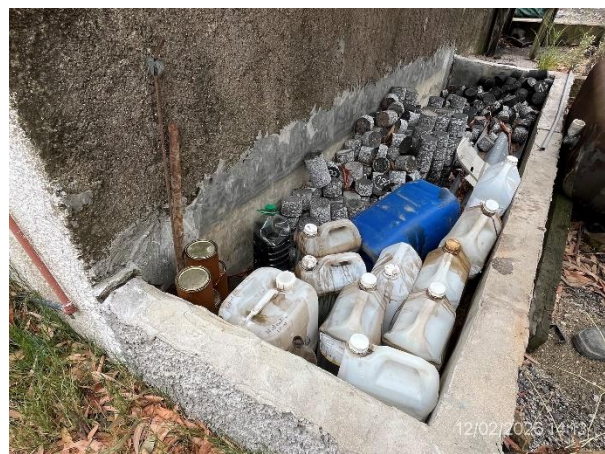
Foto 12.2-4, P03. Laboratorio de asfaltos. Percloroetileno usado acopiado bajo techo en sector envallado.
