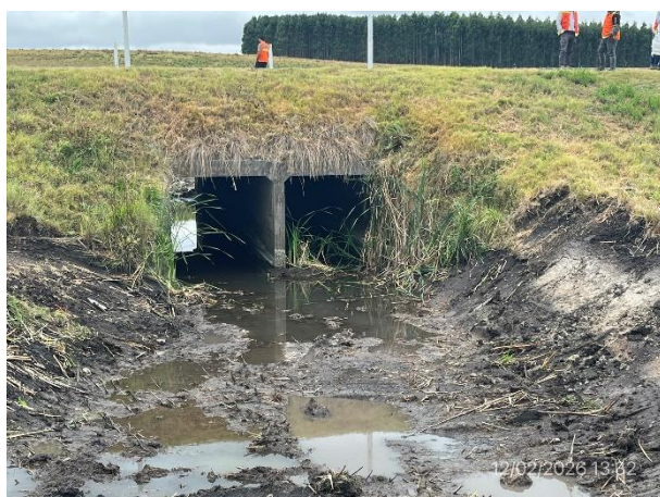
Foto 12.1-5. Tarea de mantenimiento de alcantarilla ejecutada. La cobertura vegetal es correcta.
