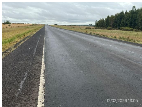
Foto 12.1-2, Ruta 5. Bacheo de calzada ejecutado en calzada completa.
