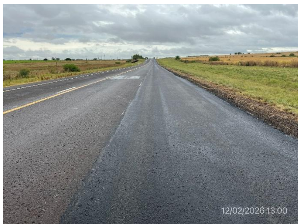
Foto 12.1-1, Ruta 5. Bacheo de calzada ejecutado en tercera senda a (+). Falta ejecutar obra de señalización.
