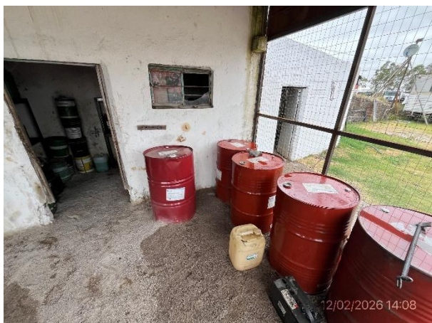
Foto 12.2-5, P03. Obrador, recinto techado y envallado para acopio de lubricantes.
