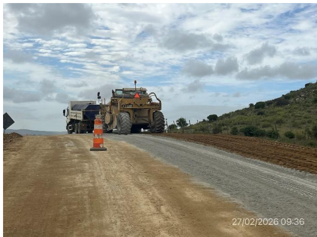
Foto 12.1-11, P09. Frente de obra, cementado de base granular en ejecución.
