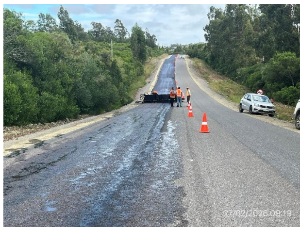
Foto 12.1-8, P09. Frente de obra, Ruta 12 progresiva 362K100.
