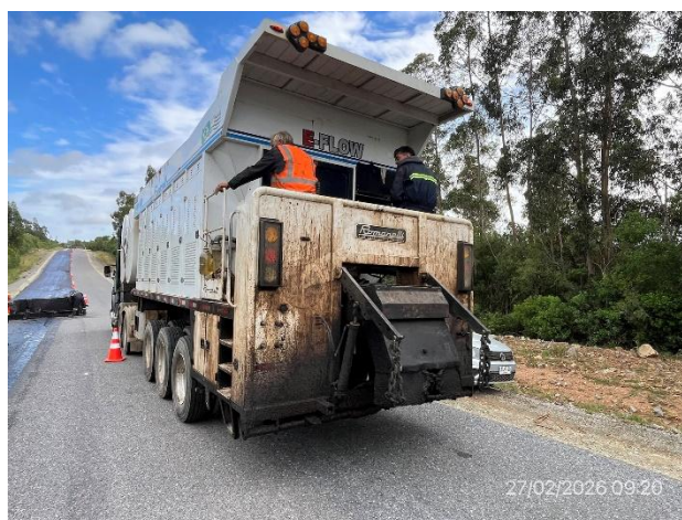
Foto 12.1-10, P09. Tendido de carpeta de rodadura en ejecución.
