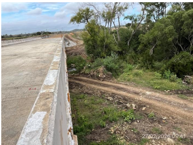
Foto 12.2-3, P05. Superestructura construida. Planicie de inundación limpia y libre de ROCs.
