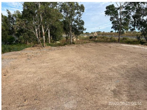
Foto 12.3-11, P06. Se construyó plataforma compactada, falta acordar con DNV las condiciones definitivas de abandono y remediación ambiental del sector.
