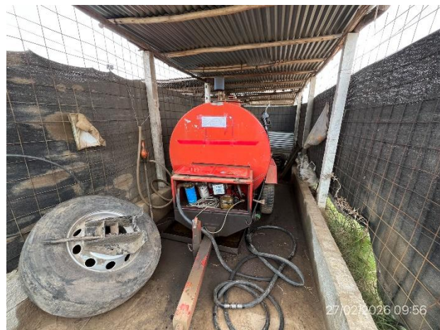
Foto 12.3-2, P03. Obrador, sector techado y con envallado impermeable y bandejas para alojar combustibles.
