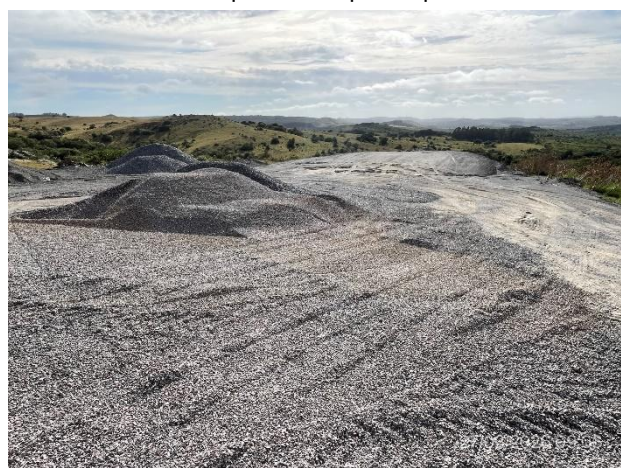
Foto 12.3-18, P08. Campamento provisional y acopio granular. Ruta 12 progresiva 364K800, faja pública a (-).
