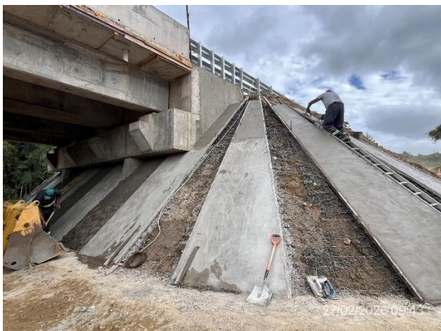
Foto 12.2-5, P05. Cuartos de cono en construcción. Zona de trabajo limpia y ordenada, libre de ROCs.
