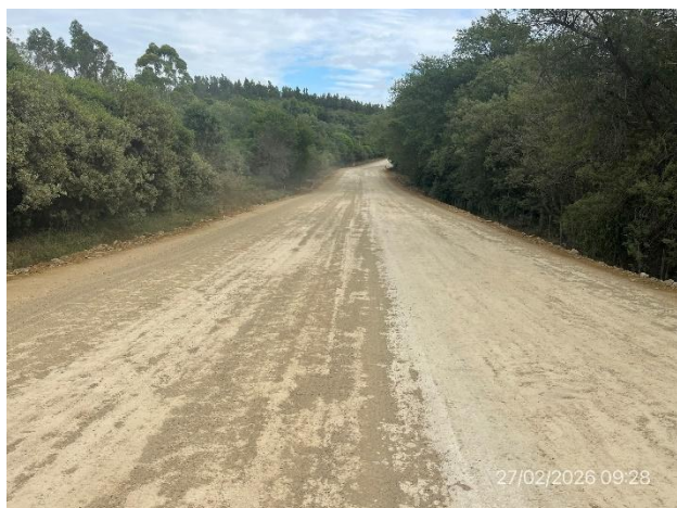
Foto 12.1-7, Ruta 12. Tramo con base granular cementada.
