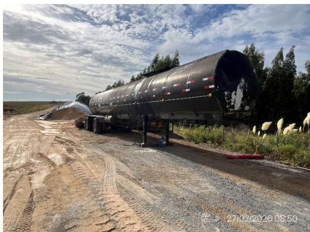
Foto 12.3-15, P07. Campamento provisional y cisterna de emulsión asfáltica. Padrón rural N° 5020, 1ª S.C. de Lavalleja. Ruta 12 progresiva 359K700 a (-).
