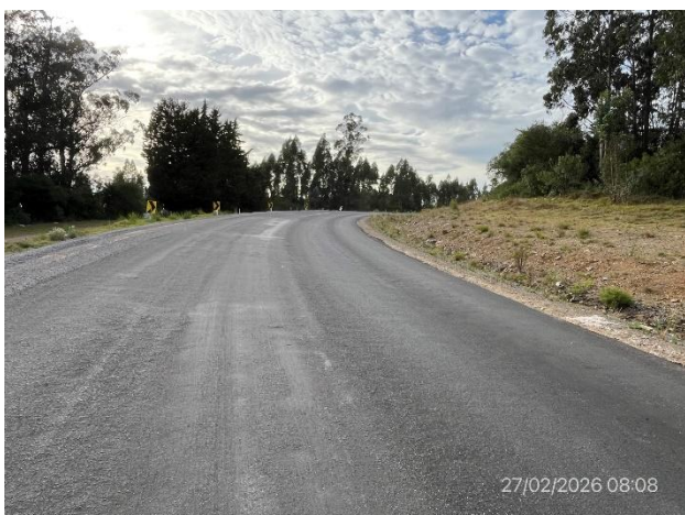
Foto 12.1-3, Ruta 12. Tramo con carpeta en Cape Seal ejecutada.
