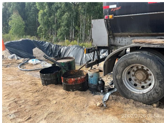
Foto 12.3-16, P07. Hay bidones con combustible apoyados sobre suelo desnudo. No está presente la infraestructura descrita en el PGA para el acopio temporal de residuos.
