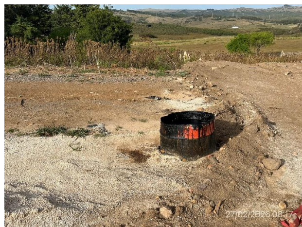
Foto 12.3-10, P06. Hay residuos oleosos pendientes de retiro y disposición final como residuos contaminantes.
