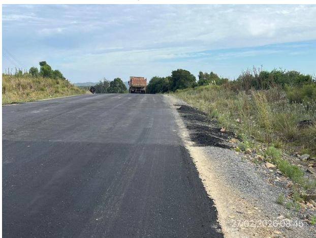
Foto 12.1-5, Ruta 12. Hay derrames repetidos y dispersos de Cape Seal hacia la faja pública de la senda a (+)
