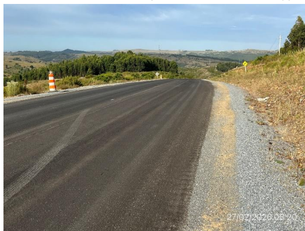
Foto 12.1-6, Ruta 12. Faja pública y cuneta limpia, con buenas condiciones de drenaje
