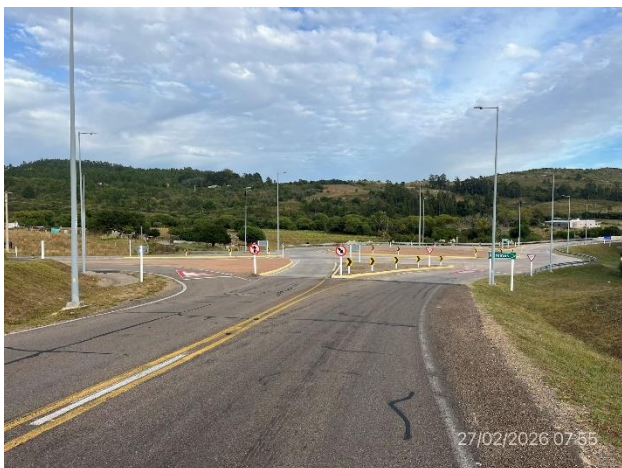
Foto 12.1-1, P02. Fin del tramo, empalme con Ruta 60.
