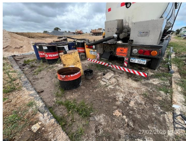
Foto 12.3-6, P03. Obrador, el sector de acopio de tarrinas de emulsión tiene un envallado impermeable correcto, pero hay derrames pendientes de disposición final.
