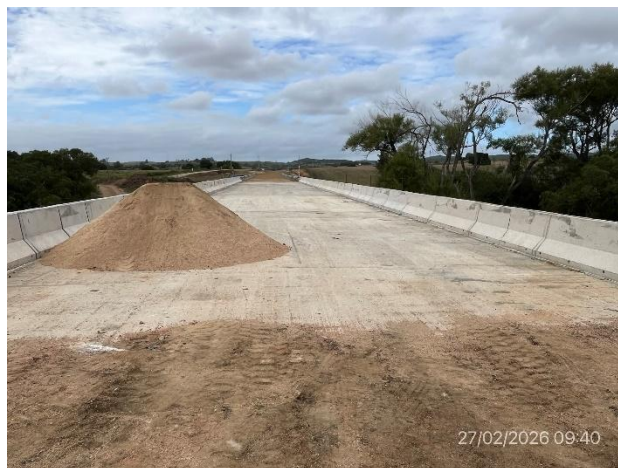
Foto 12.2-2, P05. Tablero en hormigón armado terminado.
