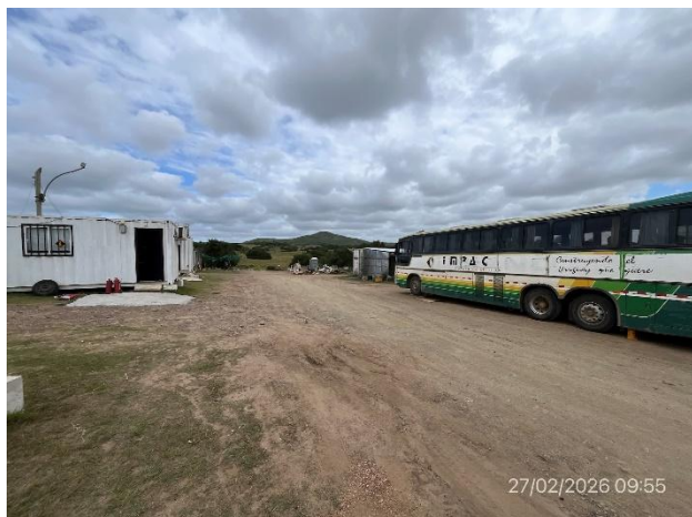
Foto 12.3-1, P03. Obrador. Padrón 3809, 4ª SC de Maldonado. Ruta 12 progresiva 374K800 a (+).
