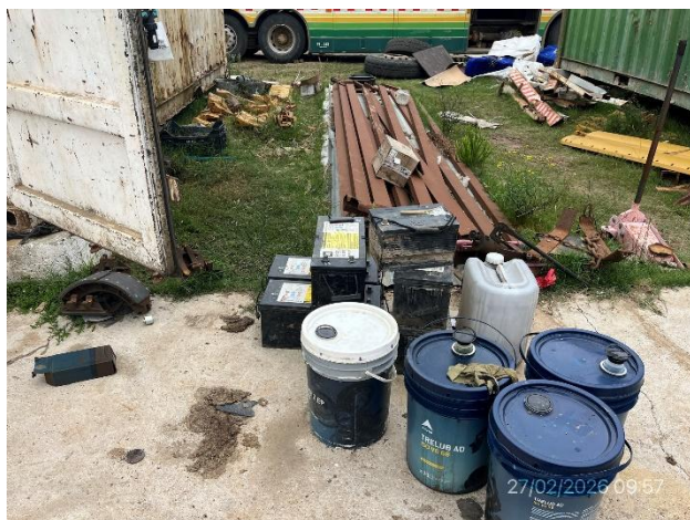
Foto 12.3-3, P03. Obrador, hay baterías y lubricantes estibados sobre suelo desnudo, fuera del sector previsto.
