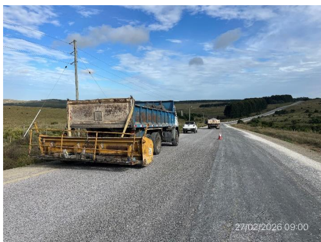
Foto 12.1-9, Ruta 12. Tendido de base de piedra para Cape Seal en ejecución.
