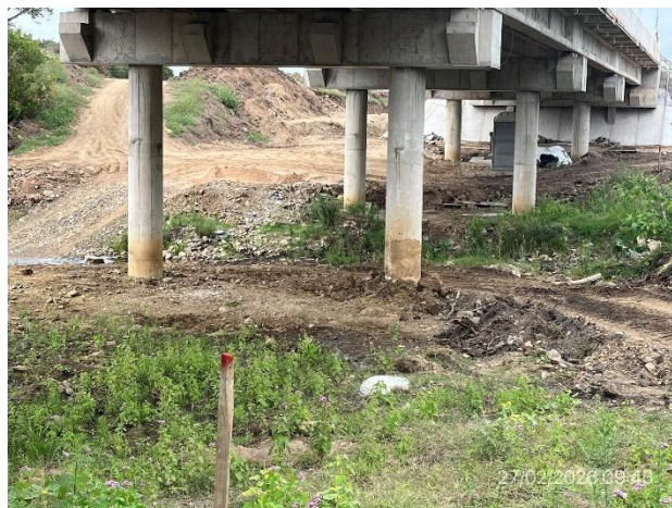
Foto 12.2-4, P05. Superestructura construida. Está correctamente demarcada la cota de máxima inundación.
