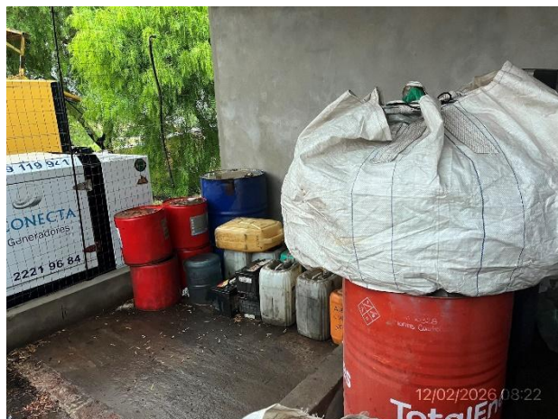
Foto 12.2-4, P05. Acopio de lubricantes. Envallado perimetral techado y con pavimento impermeable.
