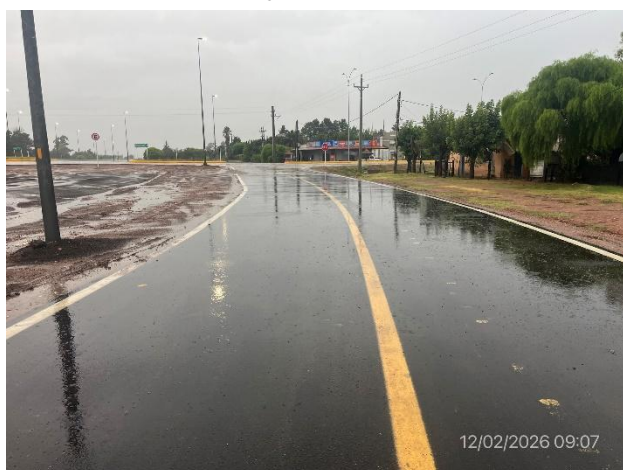
Foto 12.1-5, Av. de las Américas. Tramo de calle lateral con calzada en mezcla asfáltica terminada.
