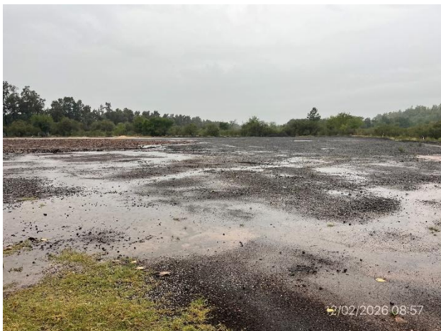
Foto 12.2-1, P03. Planta de hormigón abandonada de Cementos Artigas SA. Padrón urbano N° 4959, LC. Paysandú Chacras.
