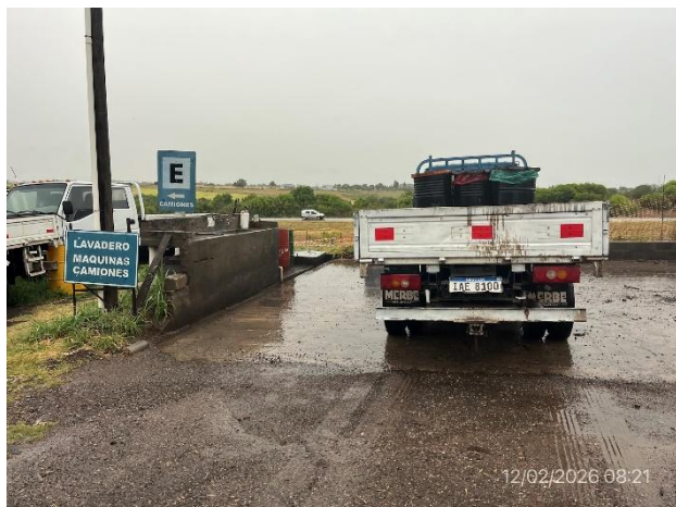
Foto 12.2-7, P05. Obrero, lavadero de camiones sobre pavimento de hormigón, con pendiente hacia cámara de retención de grasas y aceites.
