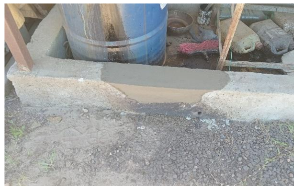
Foto 12.3-2, P04. Se reparó el envallado perimetral del sector destinado al acopio de productos químicos.
