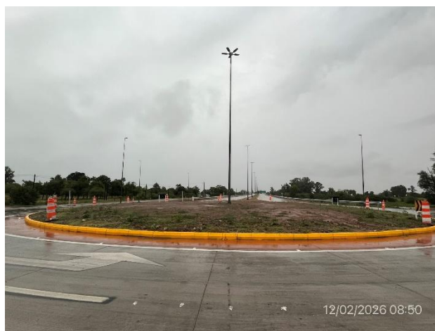
Foto 12.1-2, Av. de las Américas. Rotonda terminada con obras de iluminación terminadas.
