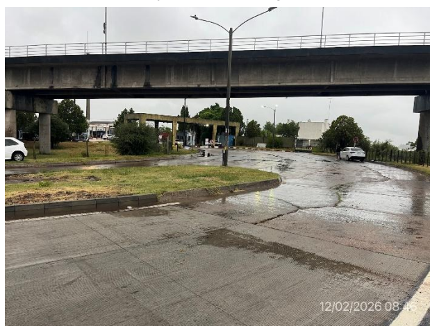
Foto 12.1-6, P02. Fin del tramo, Av. de las Américas, progresiva 380K400, acceso al puente Gral. Artigas.
