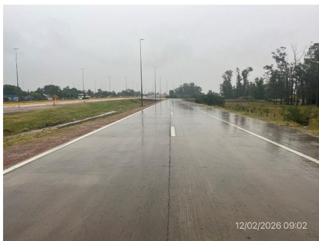
Foto 12.1-1, Av. de las Américas. Obras de señalización y ejecutadas.
