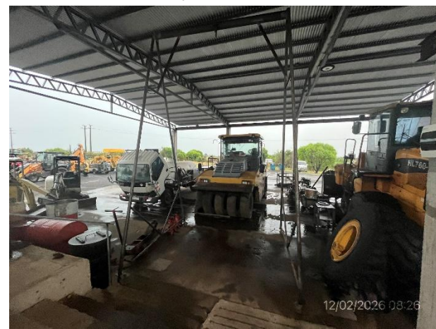
Foto 12.2-6, P05. Taller mecánico, condiciones de orden correctas. Hay ingreso y escurrimiento de aguas pluviales.
