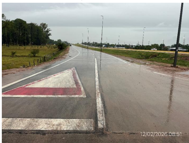
Foto 12.1-3, Av. de las Américas. Obras de señalización y ejecutadas.
