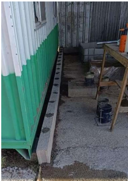
Foto 12.3-1, P03. Se construyó una contención estanca con pendientes para albergar la tarrina que contiene percloroetileno.
