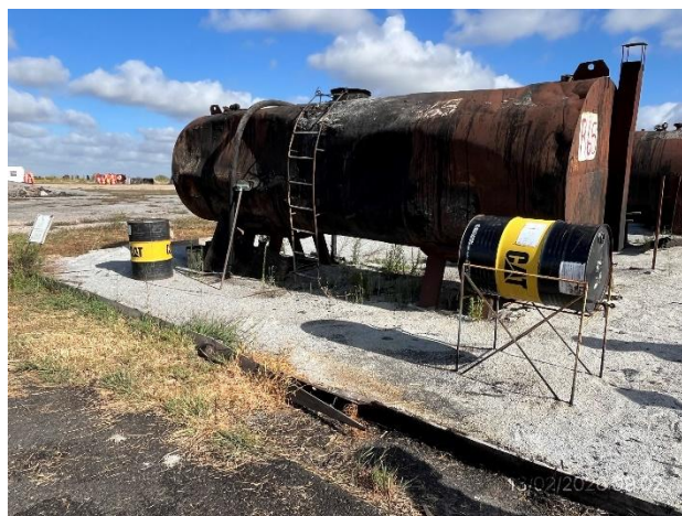
Foto 12.2-2, P03. Planta asfáltica, parque de cisternas vacías de emulsión. El envallado perimetral está deteriorado.
