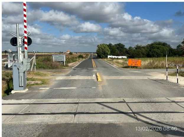
Foto 12.1-1, P02. Fin de tramo, acceso a Veinticinco de Mayo, Florida.
