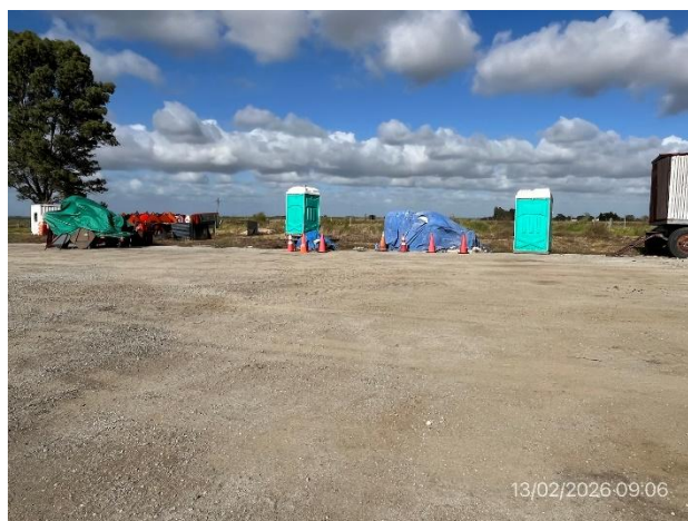
Foto 12.2-4, P03. Obrador, explanada de maniobras limpia, libre de ROCs u otros residuos.
