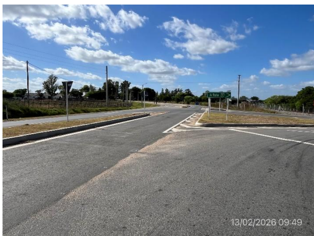
Foto 12.1-11, P01. Inicio de tramo. Ruta 76 progresiva 0K000, Veinticinco de Agosto, Florida.
