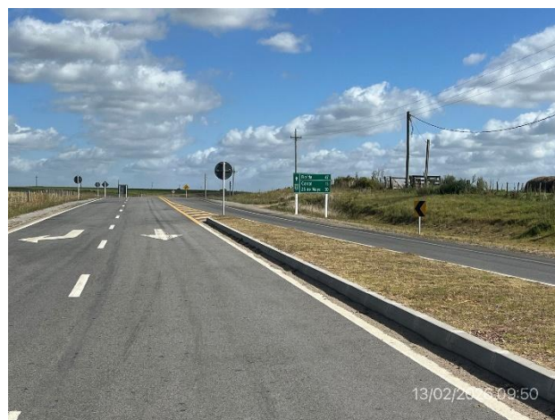
Foto 12.1-10, Ruta 76. Calzada y obras de señalización terminadas.
