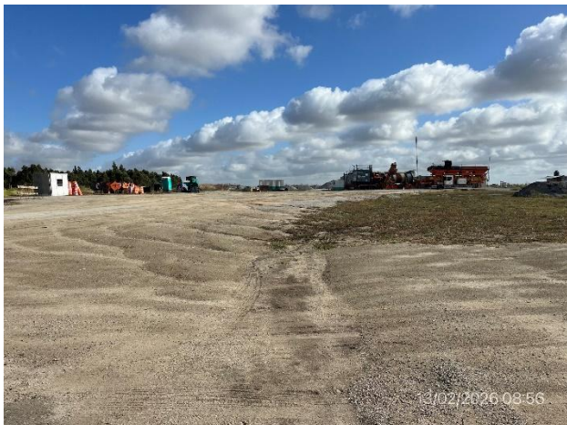
Foto 12.2-1, P03. Obrador y planta asfáltica de Incoci SA sin actividad. Ruta 76 progresiva 4K000 a (+).
