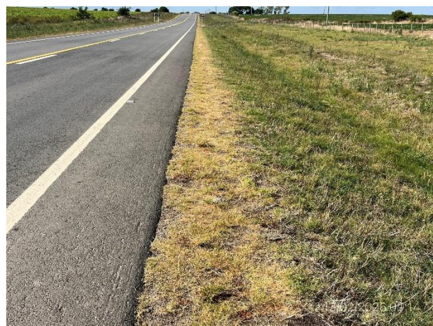
Foto 12.1-4, Ruta 77. Faja pública y banquina de senda a (+) limpia, sin presencia de ROCs.
