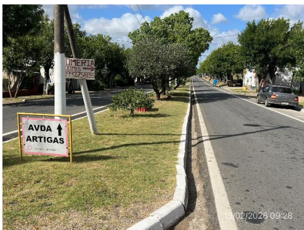
Foto 12.1-9, Ruta 76. Obra urbana ejecutada en Av. Artigas, Pblo Cardal.
