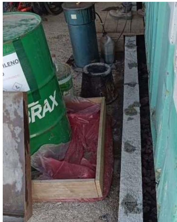
Foto 12.3-2, P03. Se colocó la tarrina con percloroetileno en nuevo sector envallado.
