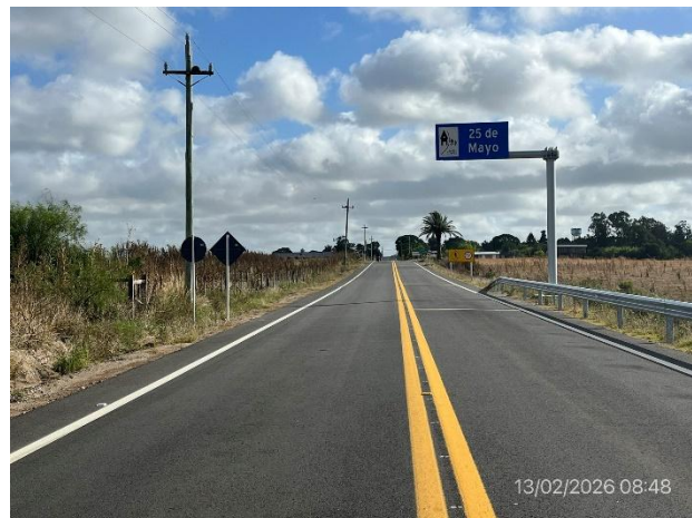
Foto 12.1-2, P02. Fin de tramo, Ruta 77 progresiva 0K200, acceso a Veinticinco de Mayo, Florida.
