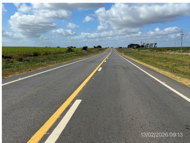
Foto 12.1-3. Ruta 77, obras de ensanche y nueva calzada terminadas.
