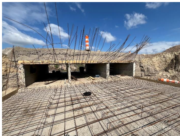
Foto 12.2-8, P06. Alargue de alcantarilla en ejecución, losa de piso ejecutada.
