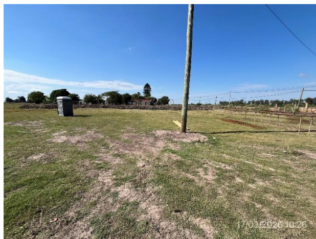
Foto 12.2-4, P07. El frente de obras no cuenta con un campamento provisorio dotado de infraestructura para acopio temporal de residuos segregados en origen.
