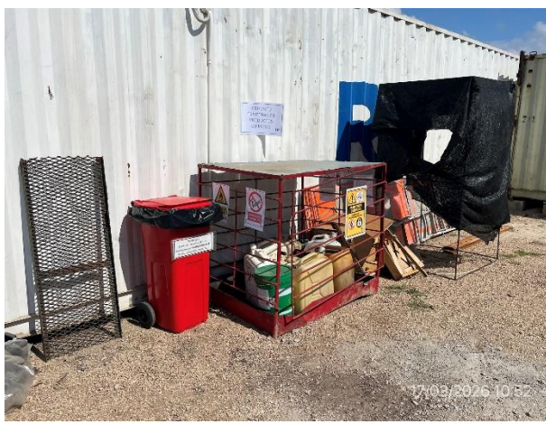
Foto 12.1-4, P03. Obrador, recinto techado y envallado para acopio de lubricantes.
