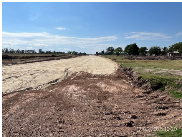
Foto 12.2-2, Ruta 62, recargo de subbase en ejecución.
