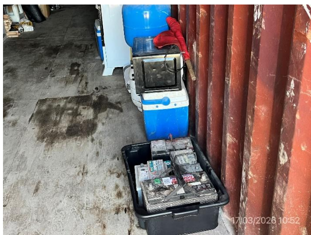
Foto 12.1-3, P03. Pañol, baterías acopiadas correctamente dentro de bandejas estancas.
