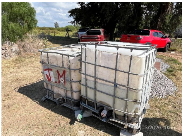
Foto 12.1-7, P03. Obrador, sistema de decantación de aguas de lavado de elementos en contacto con hormigón.
