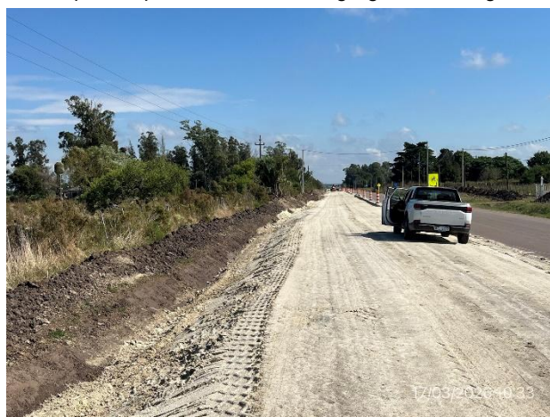
Foto 12.2-6, Ruta 62. Perfilado de cunetas en ejecución.
