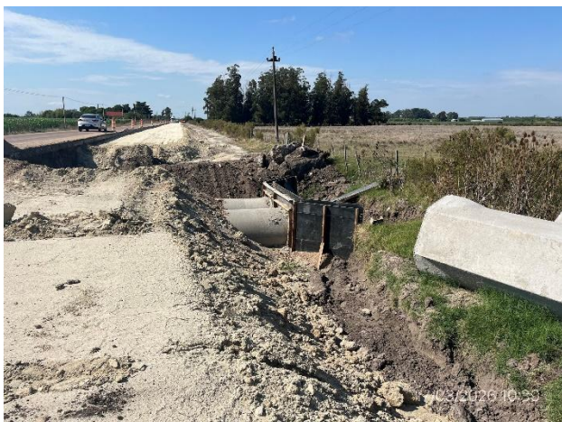
Foto 12.2-7, P06. Frente de obras vial y alcantarilla en construcción. Ruta 62 progresiva 0K600.
