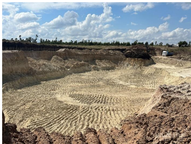
Foto 12.1-8, P04. Cantera de tosca, padrón rural N°4338, 2ª S.C. de Canelones. Ruta 62 progresiva 6K200 a (+).
