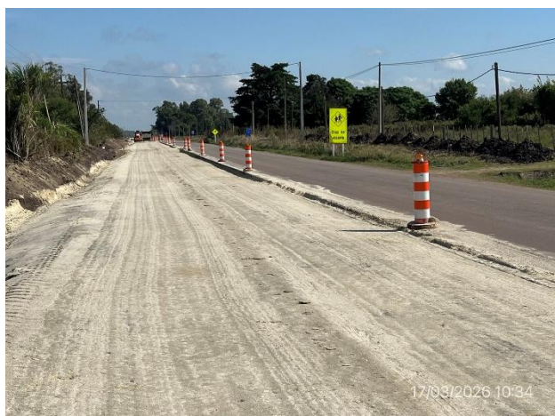
Foto 12.2-5, Ruta 62. Ensanche de plataforma en ejecución.
