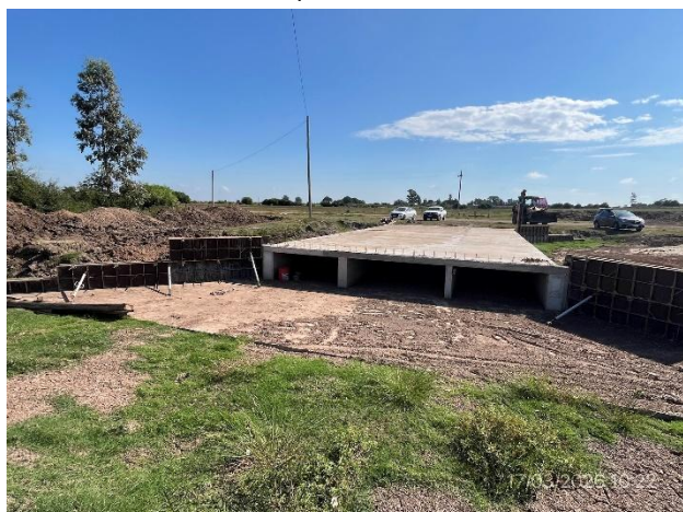
Foto 12.2-3, P07. Frente de obras, alcantarilla en construcción. Ruta 62 progresiva 0K600.
