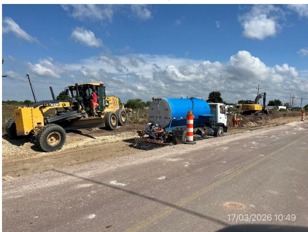
Foto 12.2-11, P06. Frente de obras, movimiento de suelos, perfilado de subbase granular en ejecución.
