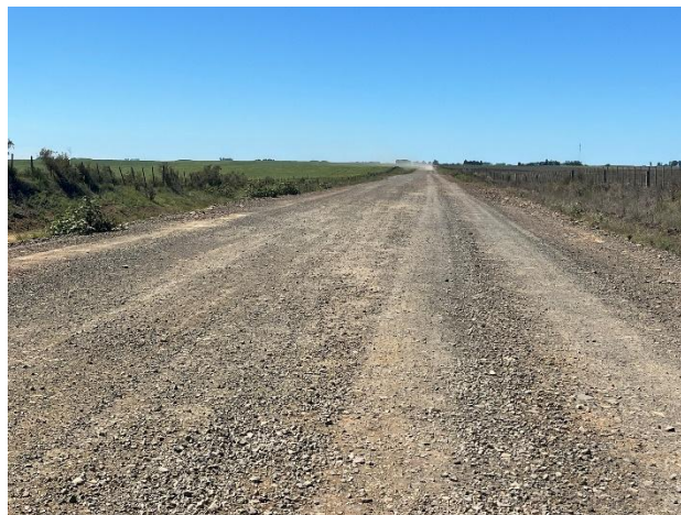
Foto 12.2-2, Nueva traza de Ruta 6. Sector con Sub-base granular perfilada.
