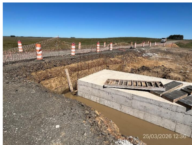
Foto 12.2-8, P04. Frente de obra, alcantarilla en construcción. Ruta 6 progresiva 300K100
