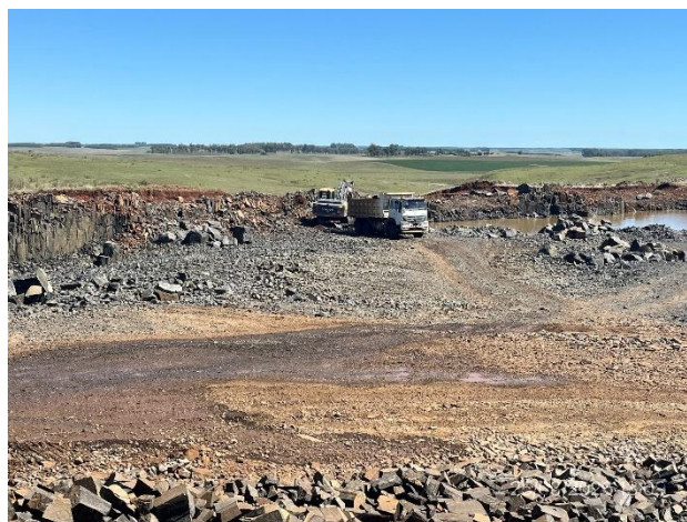
Foto 12.1-16, P03. Cantera de piedra, frente de explotación.
