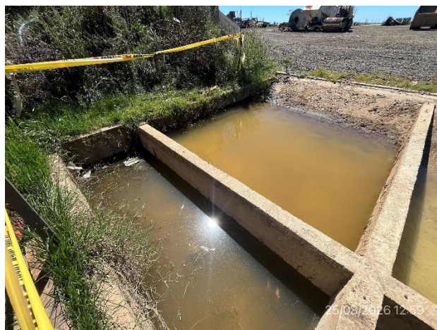
Foto 12.1-12, P03. Pileta de lavado de camiones mixer con sistema de decantación.
