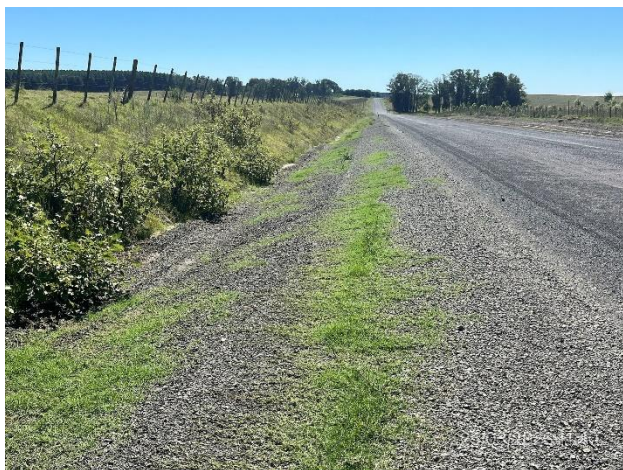
Foto 12.2-3, Ruta 6. Sector con perfil transversal conformado. Cunetas con pendientes suaves y tapiz vegetal en crecimiento.
