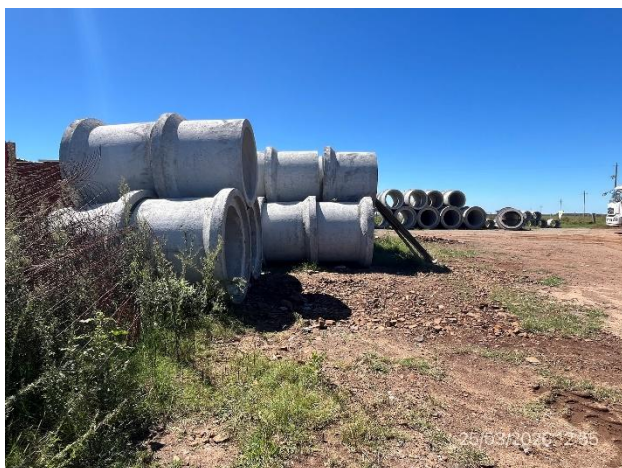
Foto 12.1-9, P03. Obrador, explanada de acopio de tuberías de hormigón fabricadas en sitio. Buenas condiciones de orden y limpieza
