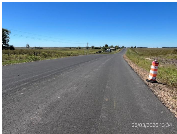
Foto 12.2-4, Ruta 6. Sector con carpeta de rodadura ejecutada en mezcla asfáltica.
