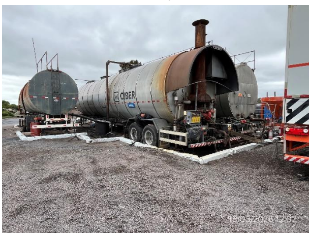
Foto 12.1-3, P06. Planta asfáltica, cisternas de emulsión con envallado perimetral impermeable.
