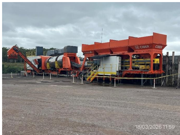
Foto 12.1-2, P06. Planta asfáltica sin actividad, explanada ordenada y en buenas condiciones de limpieza.
