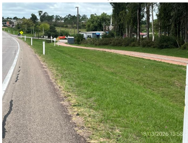
Foto 12.2-4, Ruta 17. Faja pública en buenas condiciones de mantenimiento y limpieza.
