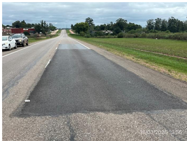
Foto 12.2-2, Ruta 17. Bacheo ejecutado en calzada de senda a (-).
