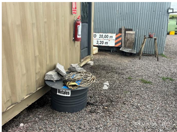
Foto 12.1-7, P06. Obrador, estación de acopio de residuos segregados en origen.
