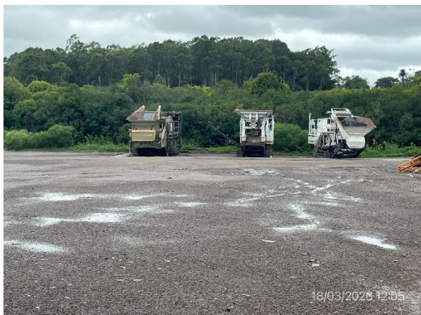
Foto 12.1-1, P06. Obrador y planta asfáltica. Ruta 8 progresiva 237K500 a (+), padrón N° 1.264, 9ª SC de Lavalleja.
