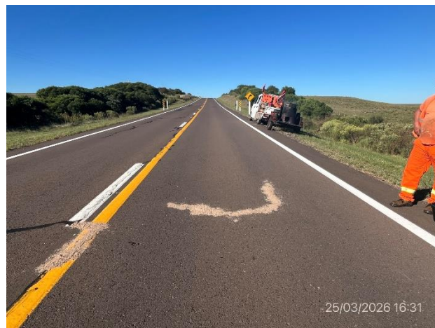
Foto 12.1-6, P03. Sellado de fisuras en ejecución.
