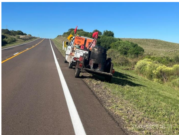
Foto 12.1-5, P03. Frente de obras de Mantenimiento, Ruta 26 progresiva 199K700, senda a (+).
