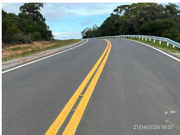
Foto 12.1-5. Ruta 16, obras de defensas metálicas terminadas.
