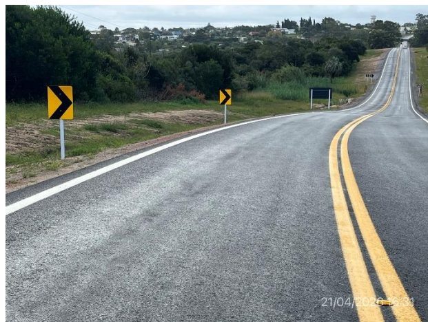
Foto 12.1-4. Ruta 16, obras de señalización horizontal y vertical terminadas.
