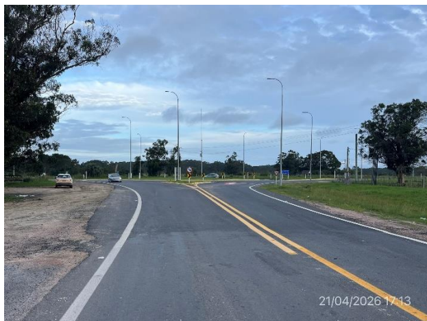
Foto 12.1-1, P01. Inicio de tramo, Ruta 16 progresiva 0K000.
