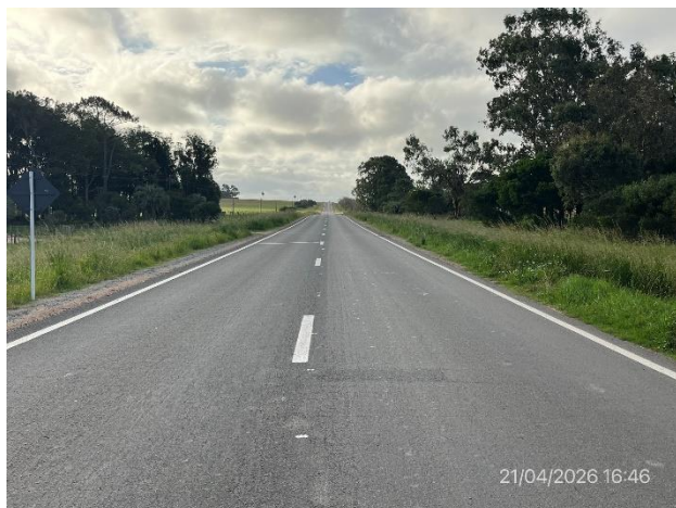
Foto 12.1-3. Ruta 16, calzada terminada con carpeta de rodadura en tratamiento bituminoso.
