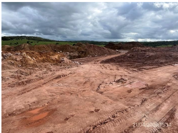
Foto 12.2-13, P05. Cantera de tosca, padrón rural N°55052 de la 4ª SC de Rocha. Ruta 16 progresiva 43K000 a (-).
