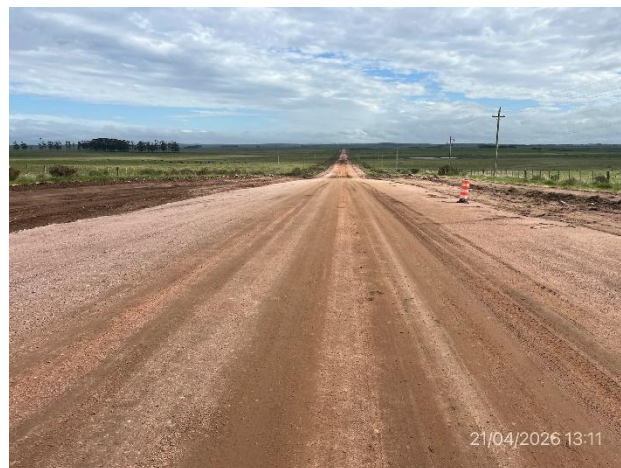
Foto 12.1-2. Ruta 14, tramo parcial con ensanche de plataforma ejecutado en sub-base.
