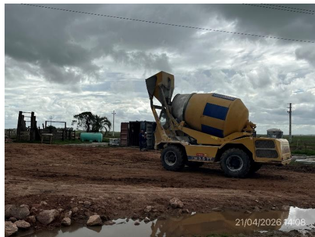
Foto 12.2-8, P04. Obrador de Solstar SA. Padrón rural N°59992, 4ª SC de Rocha. Ruta 14 progresiva 486K400 a (-).
