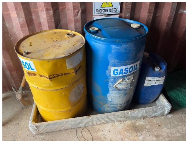
Foto 12.3-4, P04. Obrador Solstar SA, se colocó Bandeja estanca bajo recipientes de productos químicos y combustible.
