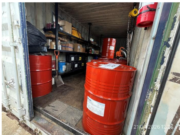
Foto 12.2-3, P03. Recinto cerrado y correctamente envuelto para el acopio de lubricantes.
