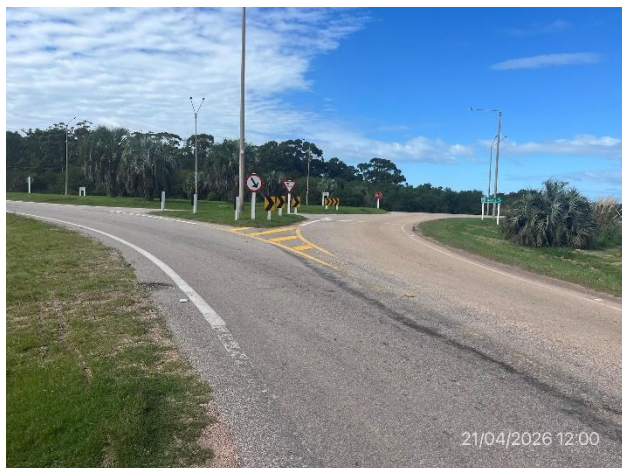
Foto 12.1-1, P02. Fin del tramo, empalme de Ruta 14 con Ruta 9. Ruta 14 progresiva 505K607.
