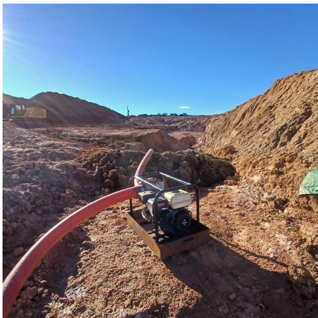
Foto 12.3-3, P05. Se colocó bandeja estanca bajo motobomba en operación.
