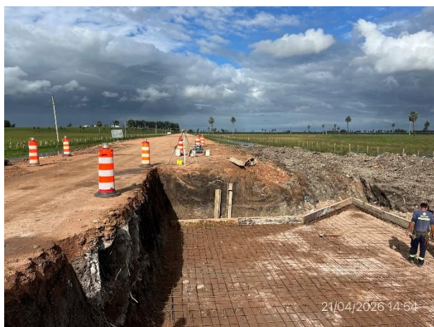
Foto 12.1-9, P07. Frente de obra de Solstar SA, alcantarilla en construcción. Ruta 14 progresiva 483K600.
