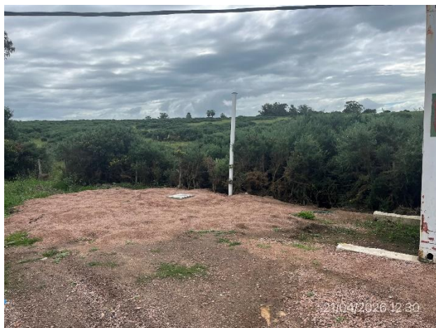
Foto 12.2-7, P03. Depósito impermeable para retención de aguas servidas.
