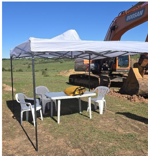
Foto 12.3-2, P05, cantera de tosca. Se colocaron servicios de bienestar para operarios y kit antiderrame.
