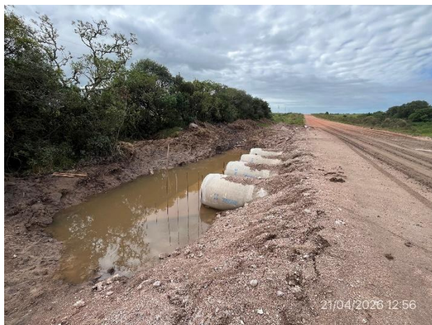
Foto 12.1-3. Ruta 14, alcantarilla de tubos en ejecución
