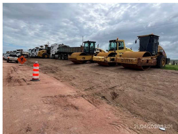
Foto 12.1-6, P06. Frente de obra y campamento provisorio de Traxpalco SA. Ruta 14 progresiva 490K900.
