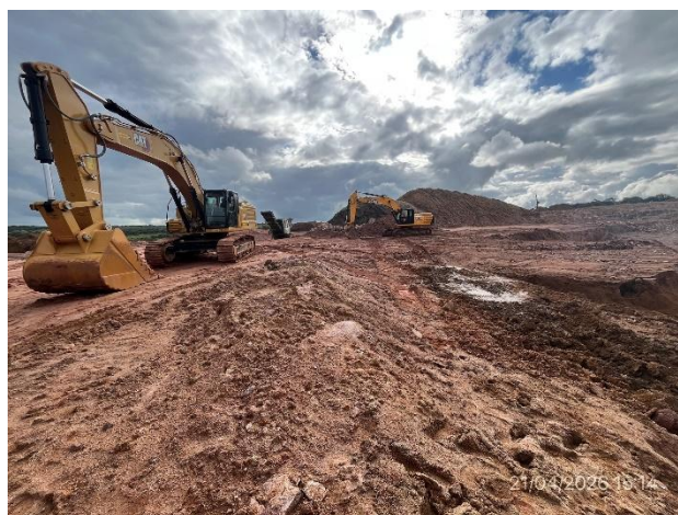
Foto 12.2-16, P05. Frente de explotación.
