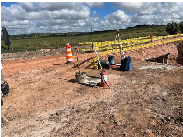
Foto 12.3-7, P07, Alcantarilla en construcción. Se suministró el kit para prevención de derrames.
