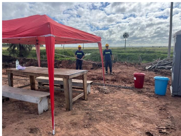
Foto 12.3-6, P07, Alcantarilla en construcción. Se instalaron los servicios de bienestar, recipientes de residuos. Se proporcionaron los EPP a los operarios.
