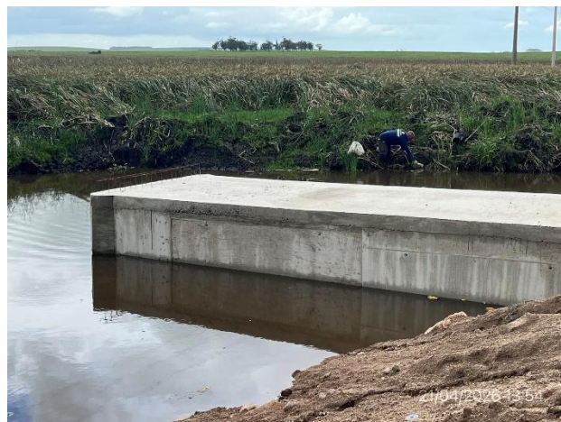
Foto 12.1-4. Ruta 14, alcantarilla H en ejecución.
