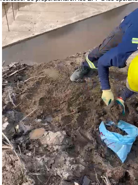
Foto 12.3-8. Alcantarilla en construcción. Se retiró como residuo especial el suelo contaminado por derrame de acelerante para hormigón.
