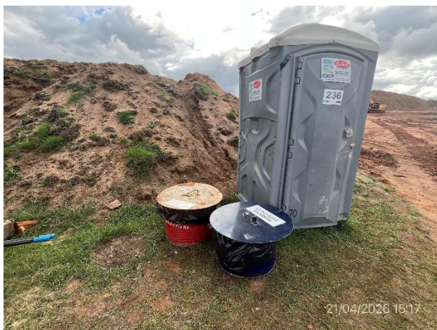
Foto 12.2-17, P05. Cuenta con infraestructura para acopio segregado de residuos desde el origen. No está presente el kit para gestión de derrames u otras contingencias.
