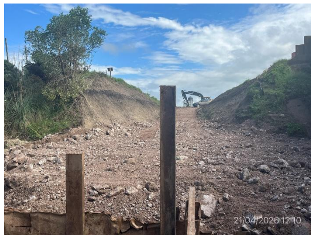
Foto 12.1-4, P03. Cota de máxima inundación correctamente demarcada.
