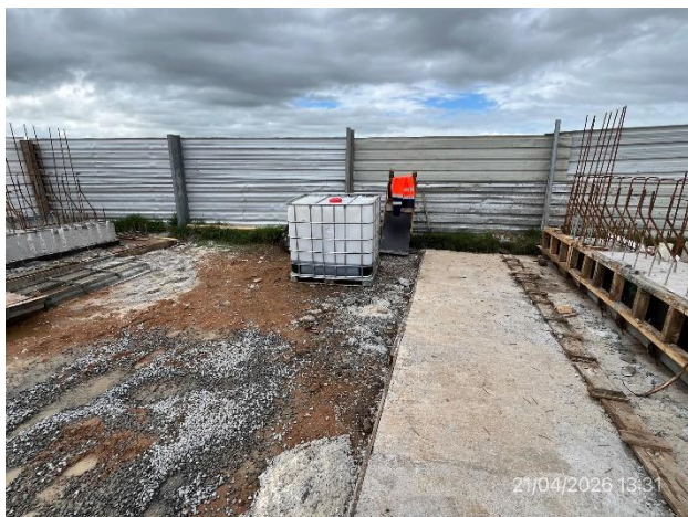
Foto 12.4-9, P04. Planta de hormigón, explanada de acopio de prefabricados
