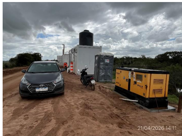
Foto 12.3-2, P01. Obrador provisorio montado fuera de zona de veda, están presentes los servicios de bienestar para los operarios
