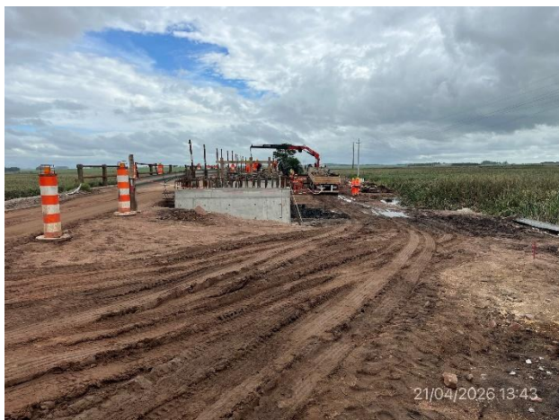
Foto 12.2-1, P02. Puente en obra en 1/2 calzada sobre A° De Los Indios. Ruta 14 progresiva 488K100.
