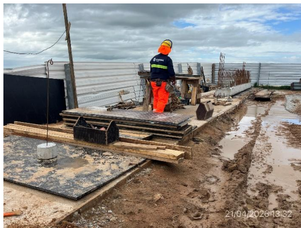
Foto 12.4-10, P04. Planta de hormigón, sector de armaduras. Buenas condiciones de orden y limpieza.
