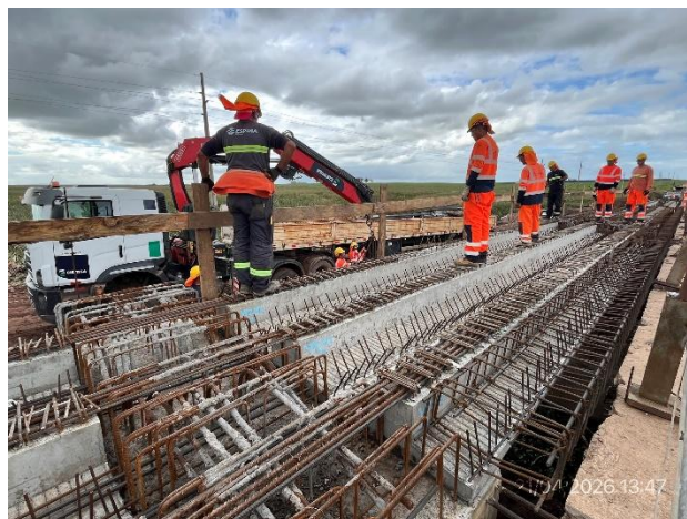
Foto 12.2-2, P02. Posicionado de elementos prefabricados en ejecución. Falta infraestructura para acopio de residuos a pie de obra.
