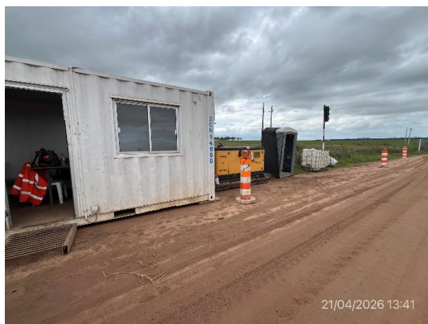
Foto 12.2-6, P02. Obrador provisorio montado fuera de zona de veda, están presentes los servicios de bienestar para los operarios.
