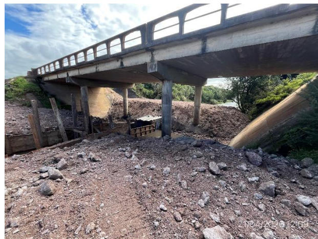
Foto 12.1-2, P03. Se construyó la ataguía granular.
