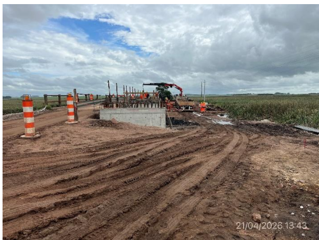
Foto 12.2-3, P02. Cota de máxima inundación correctamente demarcada.
