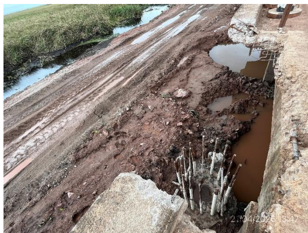
Foto 12.2-4, P02. Pilotaje ejecutado en sector de próxima intervención.
