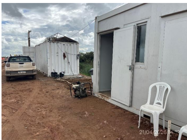
Foto 12.3-3, P01. Obrador provisorio, faltan bandejas estancas para albergar generadores y motobombas, infraestructura para acopio de residuos y kit antiderrames.
