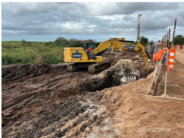
Foto 12.3-1, P01. Obras en ejecución en puente sobre A° Tranqueras.
