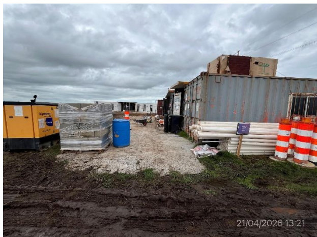
Foto 12.4-1, P04. Obrador principal Espina – Ciemsa. Ruta 14 progresiva 489K100 a (-).
