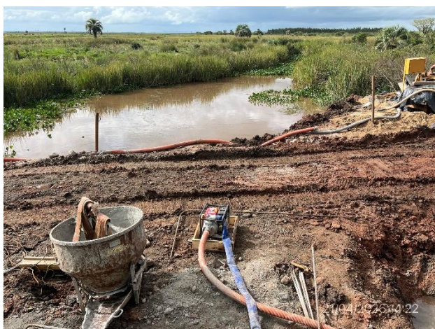
Foto 12.3-9, P01. Ataguía granular construida, motobomba en operación correctamente alojada en bandeja impermeable
