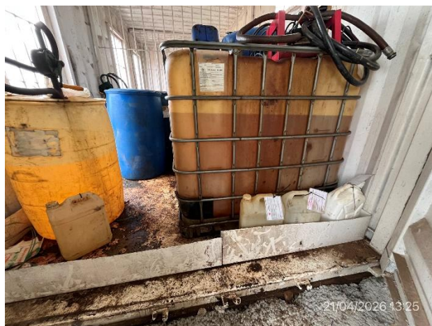
Foto 12.4-6, P04. Obrador, sector envallado para acopio de tarrinas con lubricantes y combustible. El envallado está dañado.
