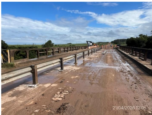
Foto 12.1-1, P03. Puente en obra sobre Canal Andreoni N°2. Ruta 14 progresiva 504K400.
