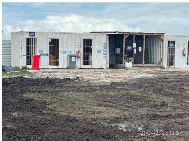
Foto 12.4-3, P04. Obrador, estación de acopio transitorio de residuos segregados por corriente de generación.
