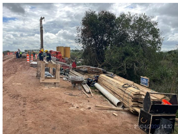
Foto 12.3-4, P01. Explanada de trabajo con insumos correctamente acopiados y buenas condiciones generales de orden.
