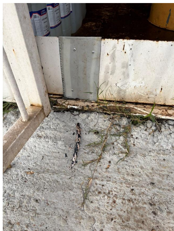
Foto 12.5-8, P04. Se reparó el envallado perimetral en el sector de acopio de lubricantes
