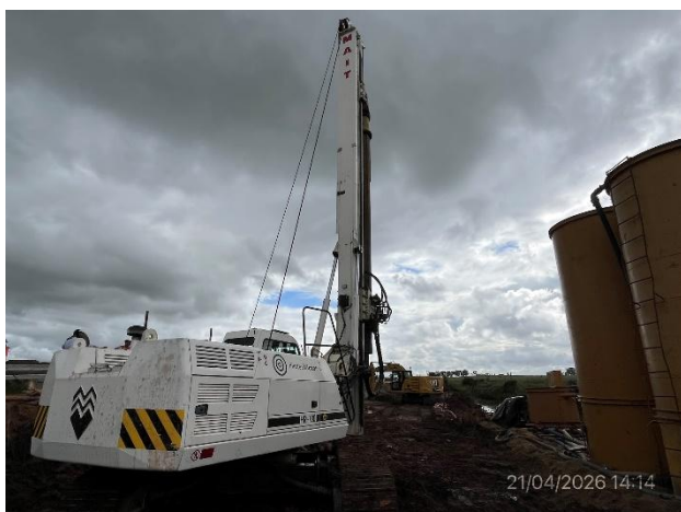
Foto 12.3-5, P01. Obras de pilotaje en ejecución, subcontrato Pilotes Víctor SA.
