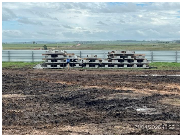
Foto 12.4-2, P04. Obrador, explanada de acopio de piezas prefabricadas.
