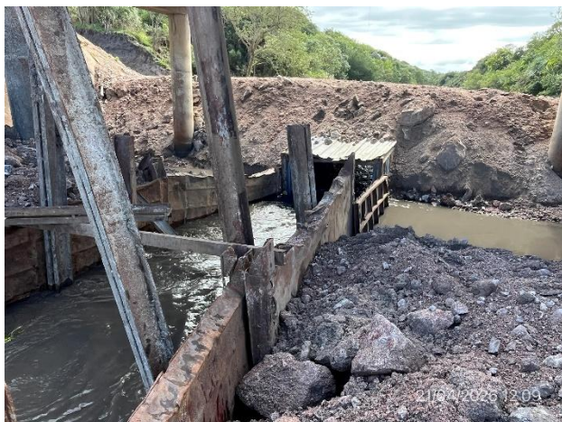
Foto 12.1-3, P03. Se entubó el flujo del canal, con buenas condiciones de escurrimiento
