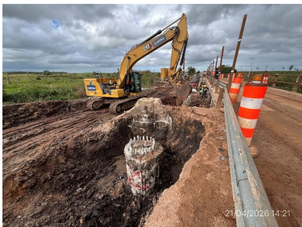
Foto 12.3-11, P01. Pilotes parcialmente ejecutados.
