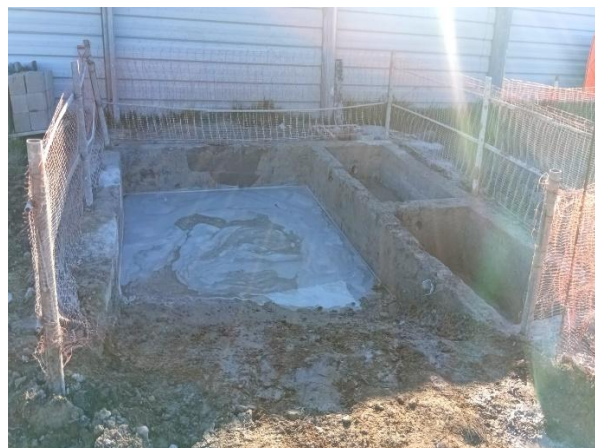
Foto 12.5-6, P04. Se limpió y drenó la cuba de lavado de aguas con hormigón.||
