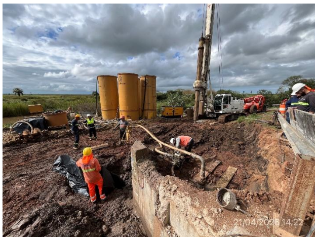
Foto 12.3-7, P01. Tarea de extracción y recirculación de lodos bentoníticos en ejecución.
