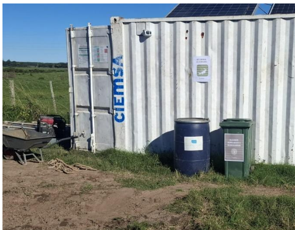
Foto 12.5-5, P03. Puente sobre Canal Andreoni N°2, se dotó al campamento provisorio de infraestructura para el acopio temporal de residuos segregados en origen.
