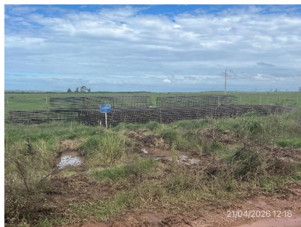
Foto 12.1-6, P03. Obrador provisorio, zona de acopio de armaduras, limpia y ordenada.
