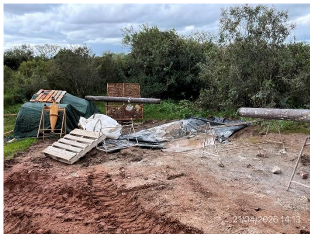
Foto 12.3-8, P01. Batea excavada impermeable para secado de lodos a desechar.
