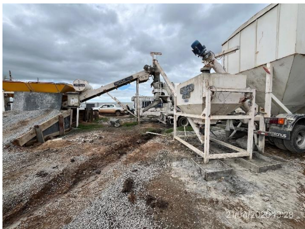
Foto 12.4-7, P04. Obrador, planta de hormigón en funcionamiento.
