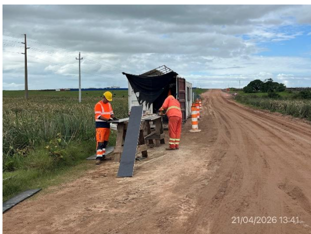
Foto 12.2-5, P02. Obrador provisorio instalado fuera de la zona de veda.
