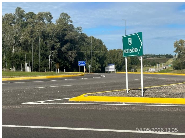
Foto 12.1-7, P03, Inicio del tramo, empalme con Ruta 12. Ruta 9 progresiva 126K500.
