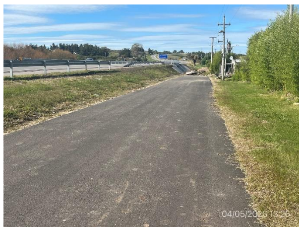
Foto 12.1-6. P02. Fin de tramo urbano, Pan de Azúcar. Calzada de servicio de Ruta 9 senda a (+), progresiva 109K400.
