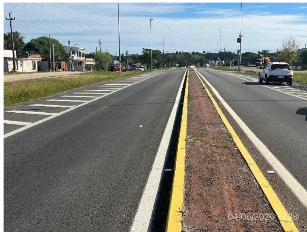
Foto 12.1-2. Tramo urbano en doble vía en Pan de Azúcar, obras terminadas con señalización ejecutada.
