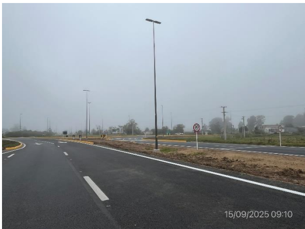
Foto 12.1-3. Ruta 9. Iluminación y obras de señalización terminadas.
