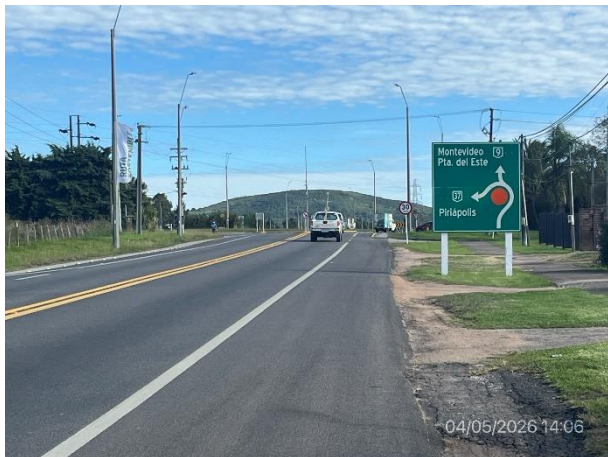
Foto 12.1-1. P01. Inicio de tramo urbano, Pan de Azúcar. Calzada en doble vía de Ruta 9 progresiva 105K650.
