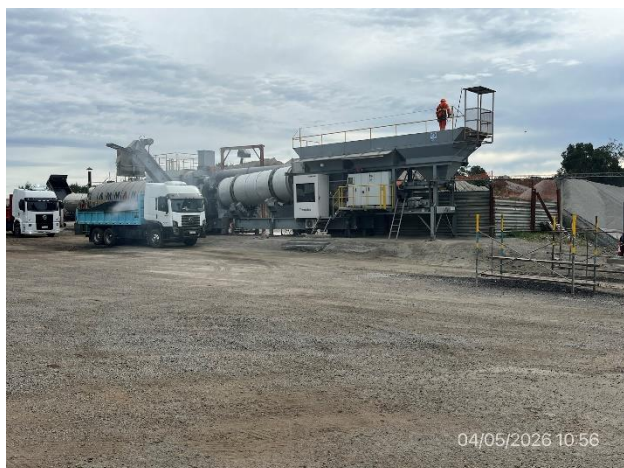
Foto 12.2-1, P05. Obrador central Planta asfáltica y cantera de piedra. Padrón rural N°8241 de la 1ª SC de Maldonado, localidad de Cerro Pelado.
