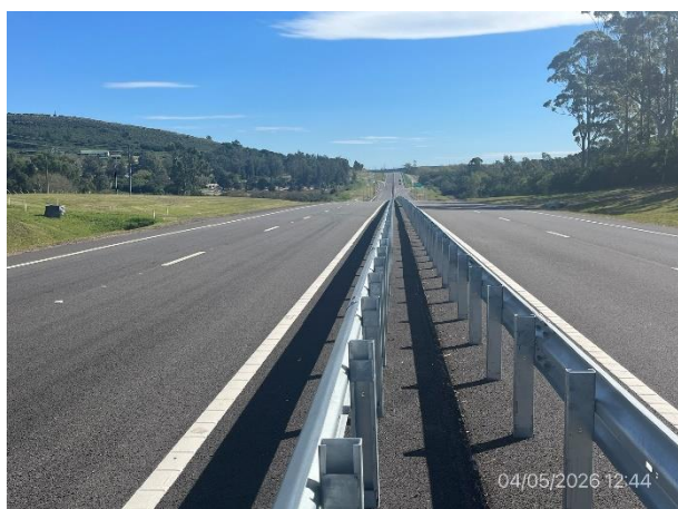
Foto 12.1-11, Tramo de Ruta 9 duplicado, obras de defensas metálicas terminadas.
