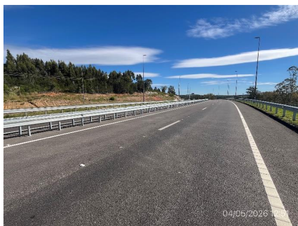
Foto 12.1-12, P04, Fin del tramo, acceso Este al intercambiador en Abra de Perdomo. Ruta 9 progresiva 131K800.
