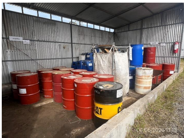
Foto 12.2-5, P05. Depósito de lubricantes envallado y techado y en buenas condiciones de limpieza.
