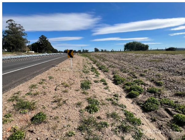
Foto 12.1-10, Ruta 9, duplicada. Sector de faja pública con pendientes suaves y empastado vegetal en crecimiento.
