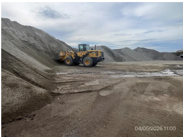
Foto 12.2-13, P05. Obrero, explanada de acopio de áridos.
