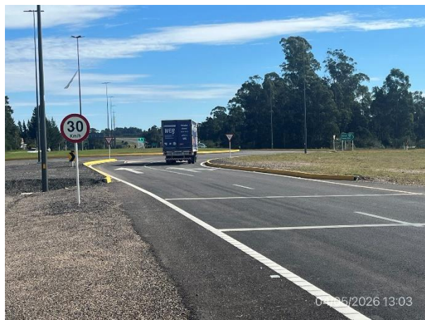
Foto 12.1-8, P03, obras de iluminación terminadas en rotonda de Ruta 9 y Ruta 12.
