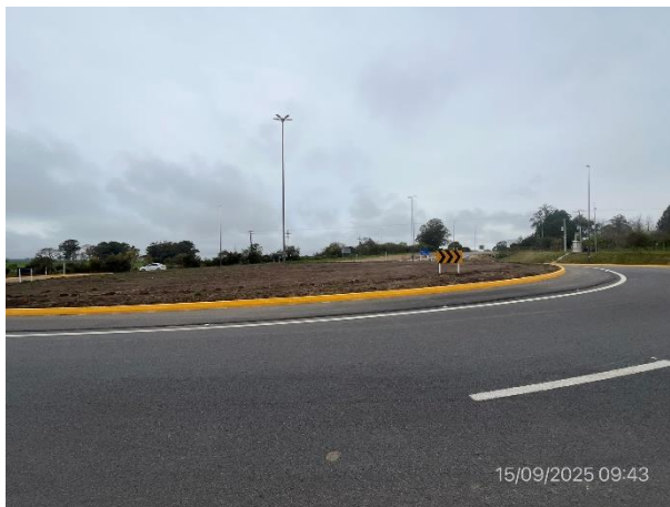
Foto 12.1-4. Ruta 9, obras de rotondas terminadas.
