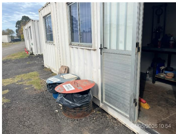
Foto 12.2-12, P05. Obrador, hay estaciones de acopio de residuos con buena redundancia en varios sectores del predio.
