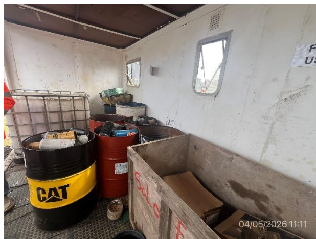
Foto 12.2-10, P05. Obrador, acopio de lubricantes usados y residuos contaminantes en local con techado y envallado correctos.
