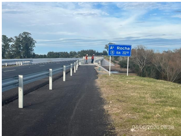
Foto 12.5-1, P05. Puente terminado en senda a (-) sobre A° Rocha. Ruta 9 progresiva 202K800.
