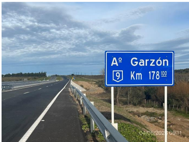
Foto 12.4-1, P04. Puentes en senda a (-) sobre A° Garzón. Ruta 9 progresiva 178K080.
