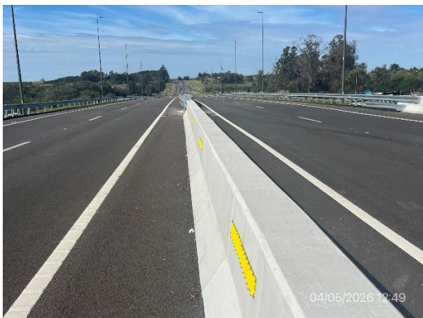
Foto 12.1-3, P01. Carpeta de rodadura, señales y barreras New Jersey terminadas.
