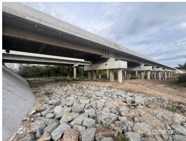
Foto 12.3-2, P03. Estructuras terminadas. Se desmontó el campamento provisorio. Planicie de inundación despejada y enrocado de protección colocado.
