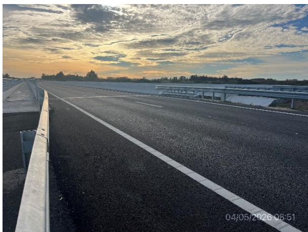
Foto 12.5-3, P05. Carpeta de rodadura, señales y barreras New Jersey terminadas.
