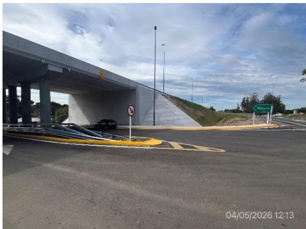
Foto 12.1-1, P01. Puente en doble vía terminado, Abra de Perdomo. Ruta 9 progresiva 130K200.
