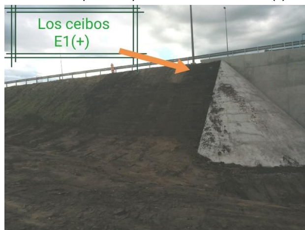
Foto 12.7-4. P01. Acciones correctivas de erosiones realizadas por la empresa, ¼ cono oeste senda (+).
