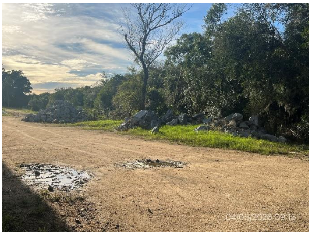
Foto 12.4-3, P04. Hay acopios de piedra bruta en la planicie de inundación, presumiblemente con destino al enrocado de protección.
