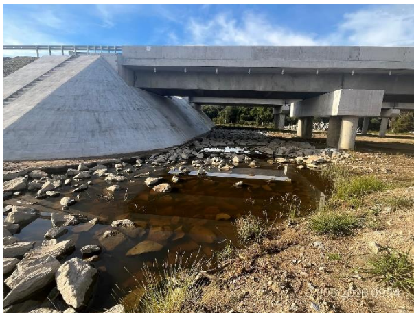
Foto 12.4-2, P04. Estructuras terminadas. El enrocado de protección no fue completado.
