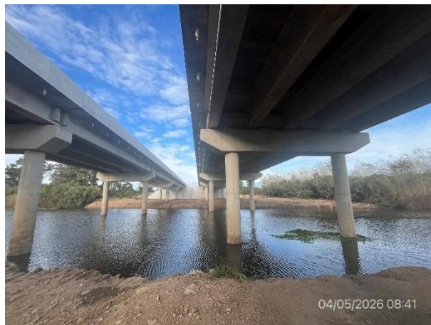
Foto 12.5-2, P05. Estructura de puente terminada. Curso de agua limpio.
