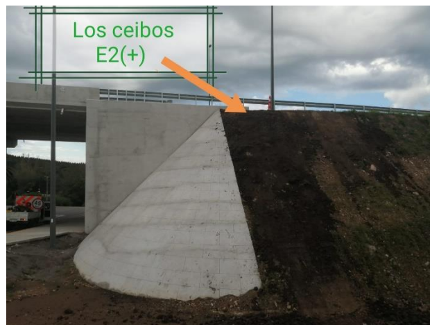
Foto 12.7-2. P01. Acciones correctivas de erosiones realizadas por la empresa, ¼ cono este senda (+).
