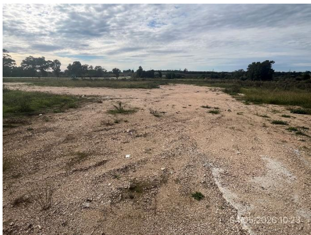
Foto 12.6-4, P06. Mejoras a conservar, plataforma granular compactada.
