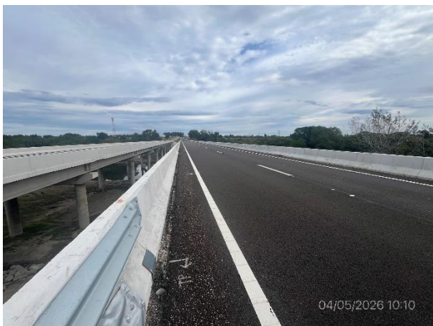
Foto 12.3-3, P03. Carpeta de rodadura, señales y barreras New Jersey terminadas.
