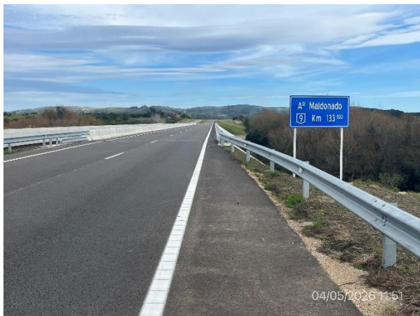
Foto 12.2-1, P02. Puente en senda a (-) abierto al tránsito sobre A° Maldonado. Ruta 9 progresiva 133K700.
