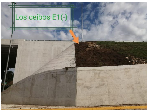
Foto 12.7-1. P01. Acciones correctivas de erosiones realizadas por la empresa, ¼ cono oeste senda (-).
