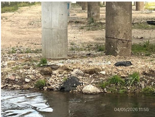
Foto 12.2-3, P02. Hay restos de mezcla asfáltica en la planicie de inundación del curso.
