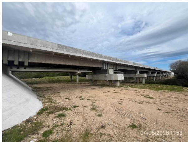
Foto 12.2-2, P02. Estructuras terminadas. Se desmontó el campamento provisorio. Planicie de inundación despejada.
