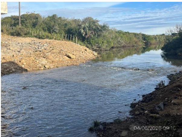
Foto 12.4-4, P04. Hay un terraplén granular permanente en torno al ¼ de cono oeste que invadió y modificó el curso de agua.
