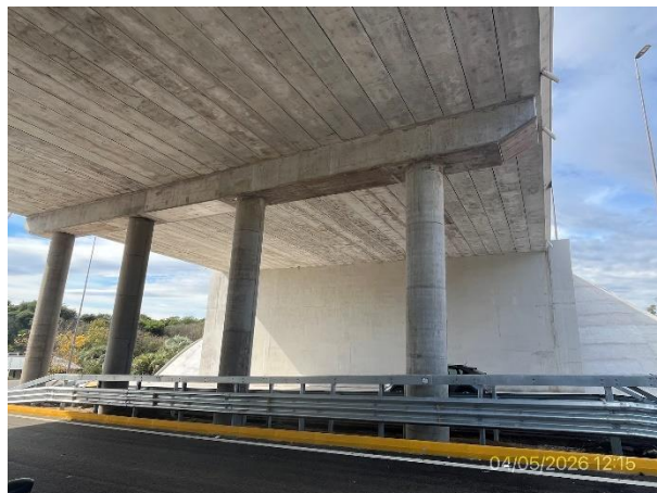
Foto 12.1-2, P01. Estructuras de puentes en doble vía terminadas.
