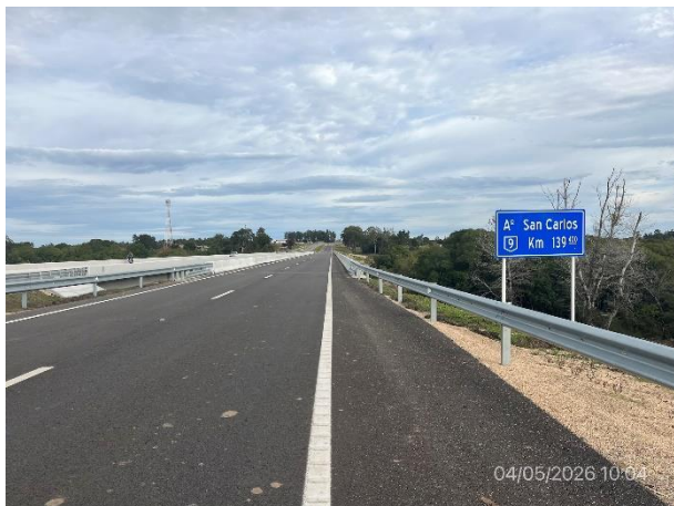
Foto 12.3-1, P03. Puente en senda a (-) abierto al tránsito sobre A° San Carlos. Ruta 9 progresiva 139K300.
