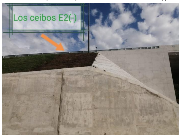
Foto 12.7-3. P01. Acciones correctivas de erosiones realizadas por la empresa, ¼ cono este senda (-).
