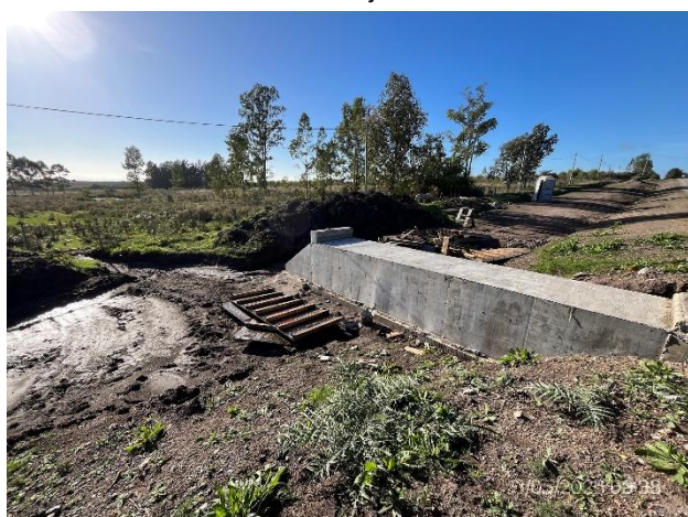
Foto 12.1-9, P05. Alcantarilla en construcción. Ruta 80 progresiva 77K600
