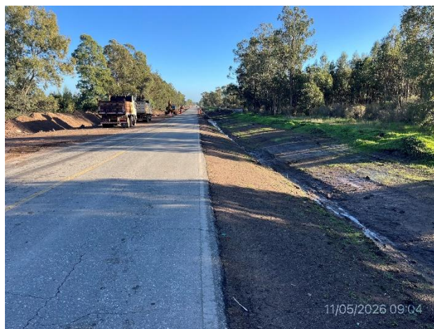
Foto 12.1-8, P04. Frente de obra, drenaje en faja pública correctamente ejecutado, con pendientes suaves.
