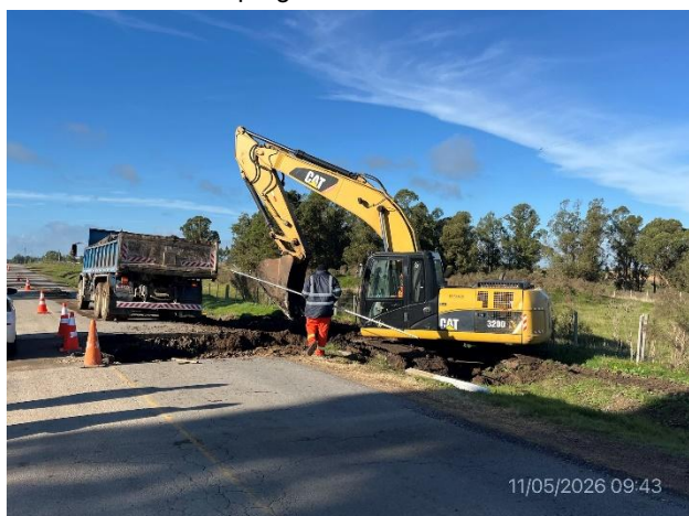
Foto 12.1-11, P06. Alcantarilla en construcción. Ruta 80 progresiva 78K200.
