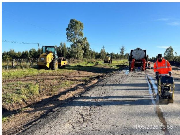
Foto 12.1-7, P04. Frente de obra, corte de calzada para bacheo en ejecución.
