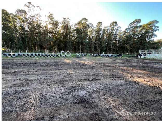
Foto 12.2-7, P03. Obrador, explanada de acopio de caños de hormigón.
