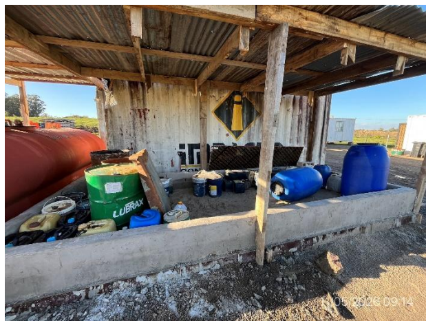
Foto 12.2-2, P03. Obrador, recinto techado y envallado para el acopio de tarrinas de lubricantes.
