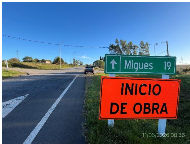
Foto 12.1-2, P01. Inicio de obra, Ruta 80 progresiva 71K350.
