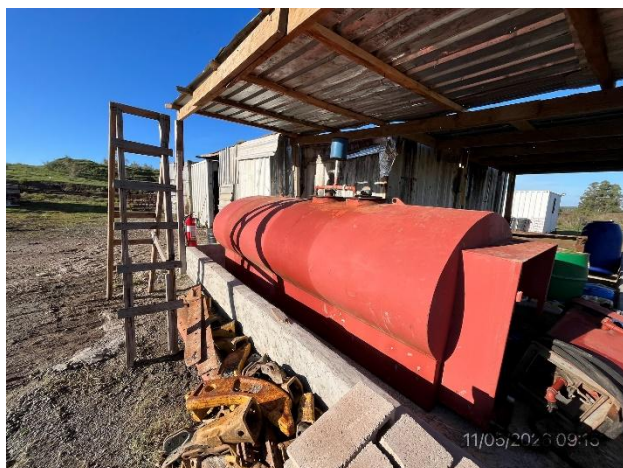
Foto 12.2-3, P03. Obrador, recinto techado y envallado para alojar el tanque de combustible.
