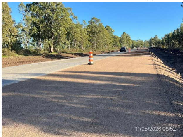
Foto 12.1-5, Ruta 80. Tramo con subbase granular ejecutada en senda a (+).
