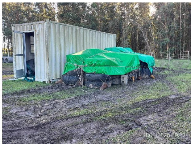
Foto 12.2-4, P03. Obrador, el sector de acopio de neumáticos, correctamente tapado
