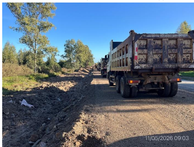
Foto 12.1-6, P04. Frente de obra, Ruta 80 progresiva 74K000. Recargo granular en ejecución.
