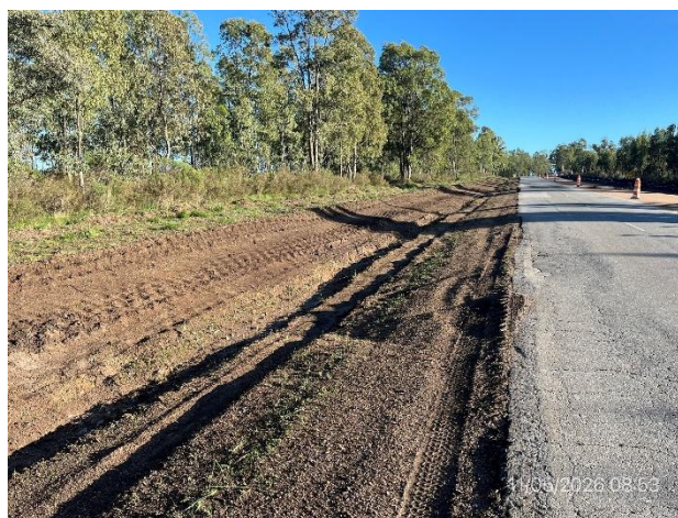
Foto 12.1-4, Ruta 80. Tramo con ensanche de plataforma en subrasante ejecutado en senda a (-).
