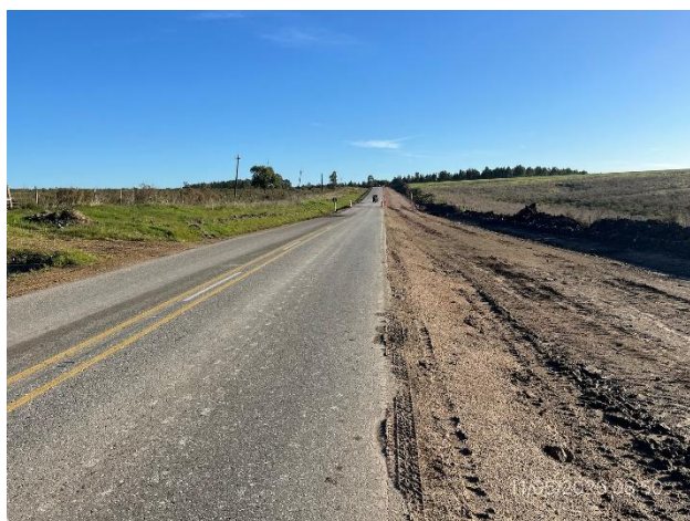
Foto 12.1-3, Ruta 80. Tramo con ensanche de plataforma en subrasante ejecutado en senda a (+).
