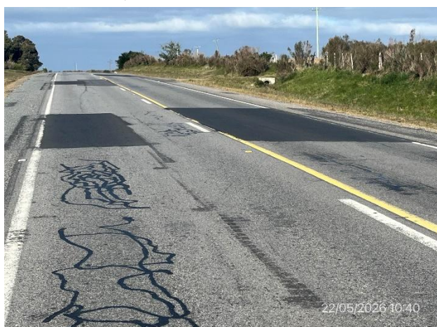
Foto 12.1-3, Ruta 2. Sellados de fisuras ejecutados.
