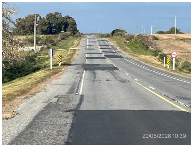
Foto 12.1-2, Ruta 2. Obras de bacheo ejecutadas, sendas a (+) y a (-). Faja pública en buenas condiciones.
