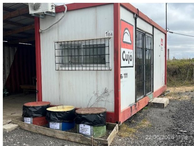
Foto 12.2-2, P05. Obrador, estación de acopio transitorio de residuos segregados por corriente de generación.
