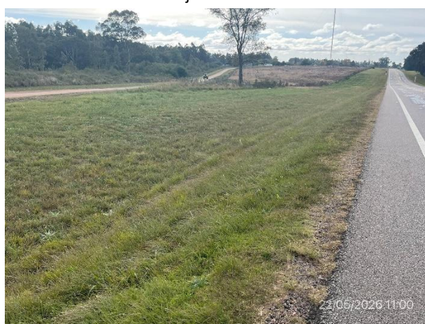
Foto 12.1-6, Ruta 12. Faja pública en buenas condiciones de cobertura vegetal y drenaje.
