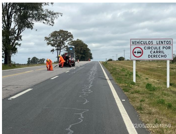
Foto 12.1-10, P07. Frente de obras, Ruta 23 progresiva 146K800.
