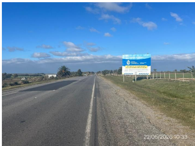
Foto 12.1-1, P03. Fin de obras en Ruta 2, progresiva 182K400, acceso sur a Florencio Sánchez.
