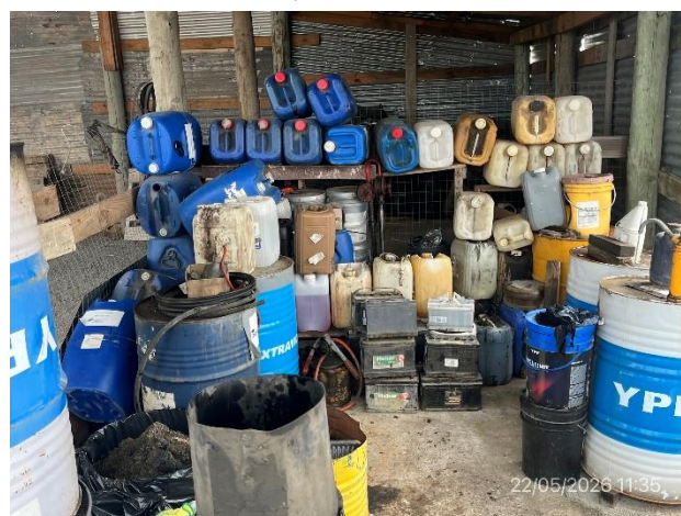
Foto 12.2-6, P05. Obrador, sector envallado para acopio de aceites usados y residuos contaminados con hidrocarburos.
