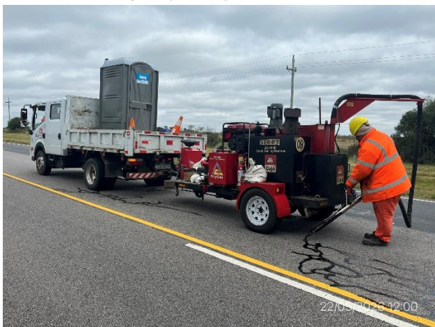
Foto 12.1-11, P07. Sellado de fisuras por puenteo en ejecución.
