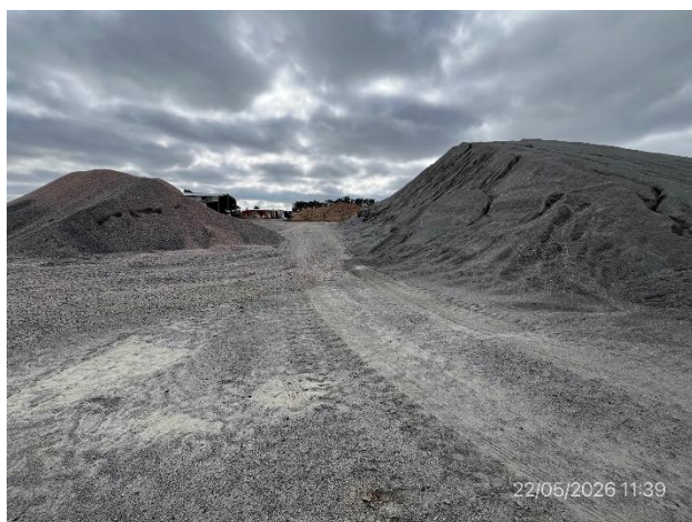
Foto 12.2-9, P05. Explanada para acopio de áridos, buenas condiciones de limpieza.
