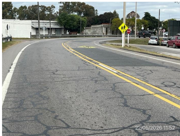
Foto 12.1-8, Ruta 23. Sellados de fisuras y bacheo en mezcla asfáltica en calzada, planta urbana de Ismael Cortinas.
