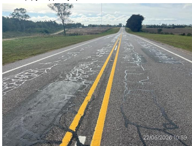
Foto 12.1-4, Ruta 12. Sellados de fisuras en calzada ejecutados.
