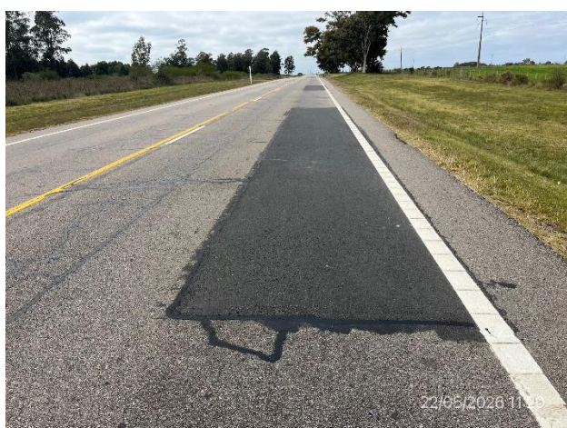
Foto 12.1-5, Ruta 12. Bacheo en mezcla asfáltica en calzada ejecutados.
