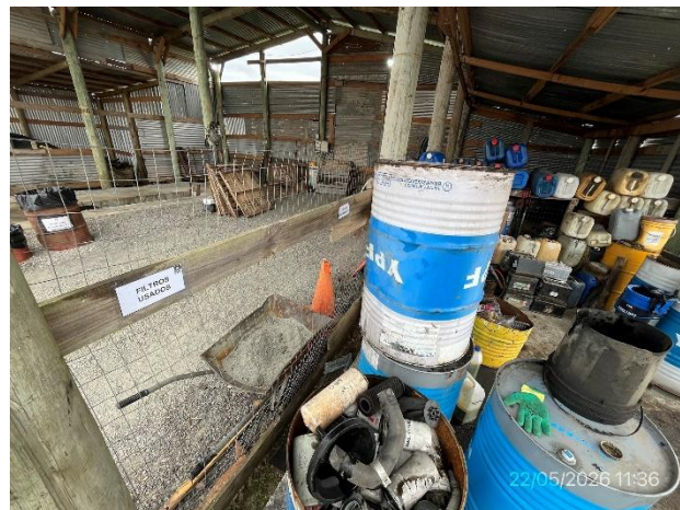
Foto 12.2-8, P05. Obrador, residuos contaminados con hidrocarburos alojados en sector envallado.
