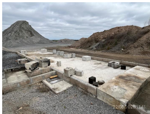
Foto 12.2-10, P05. Sector de planta asfáltica desmantelada, permanecen las plataformas y los envallados perimetrales para su eventual reinstalación a futuro.
