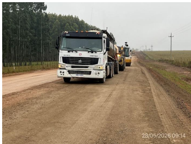
Foto 12.3-8, P07. Frente de obra, Ruta 19 progresiva 62K000.
