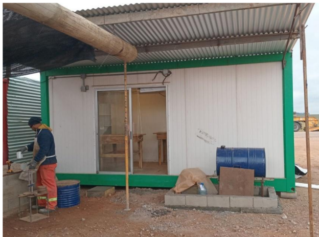
Foto 12.4-1, P03. Laboratorio de asfalto, se techó la zona donde se ubica el sector envallado para el acopio de percloroetileno usado
