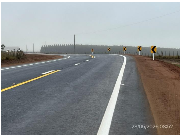
Foto 12.3-3. Ruta 19, Tramo con obras de señalización vertical y horizontal ejecutadas
