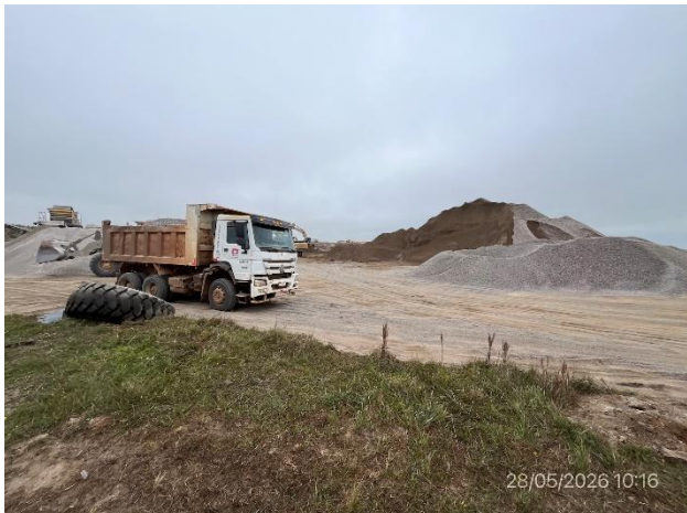
Foto 12.2-1, P05. Cantera de piedra y tren de trituración. Padrón rural N° 12532, 8ª SC de Durazno. Ruta 19 progresiva 83K400 a (-).
