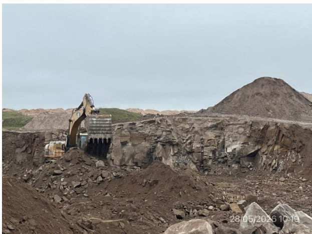
Foto 12.2-5, P05. Frente excavación y voladura del yacimiento de piedra. Buenas condiciones de operación.
