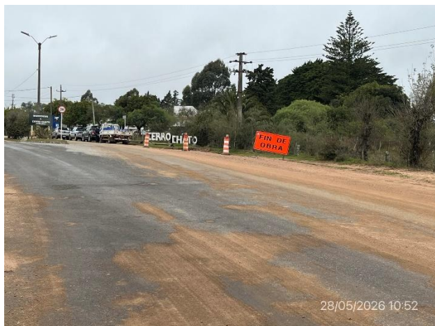
Foto 12.3-17, P02. Fin de tramo, Ruta 19 progresiva 89K220. Acceso Oeste a Cerro Chato.
