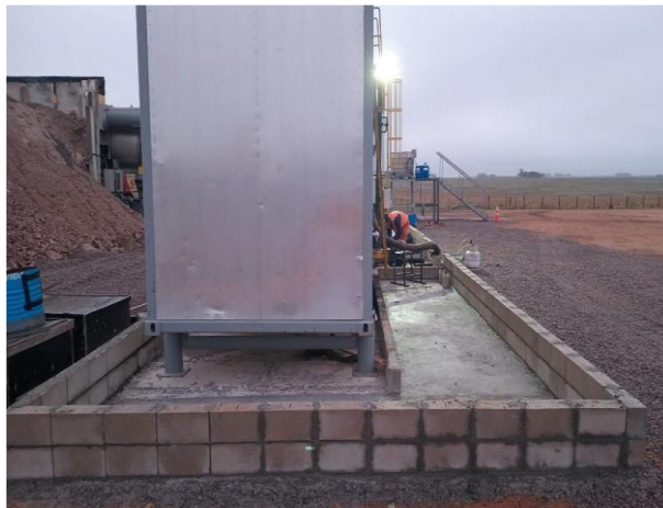
Foto 12.4-2. P03. Planta asfáltica. Se aumentó el volumen del envallado perimetral para la cisterna.
