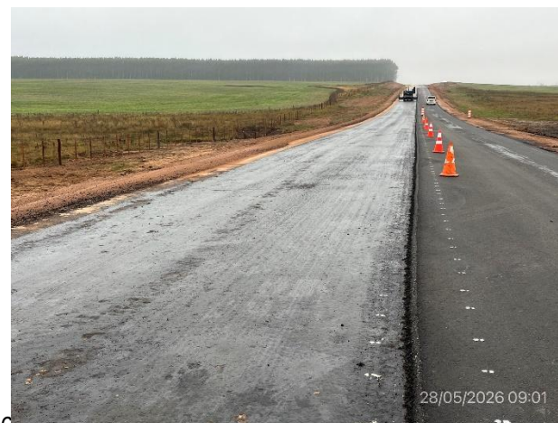
Foto 12.3-6, P06. Tendido de mezcla asfáltica en ejecución y tránsito circulando en media calzada.
