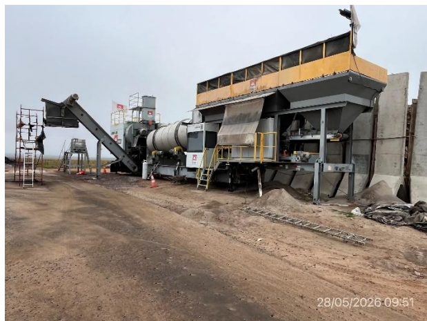
Foto 12.1-8, P03. Planta asfáltica, en proceso de calentamiento.
