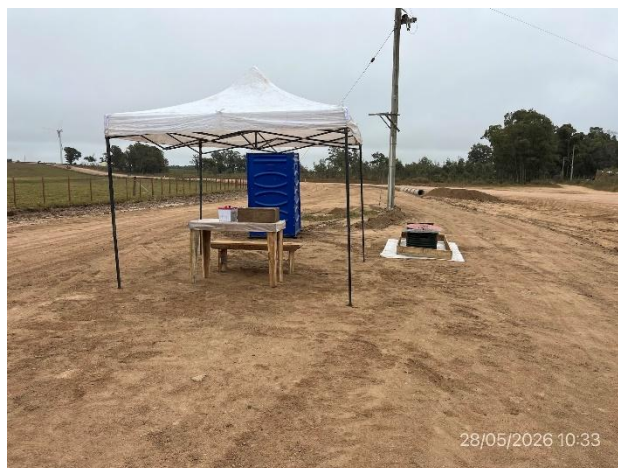
Foto 12.3-16, P09. Campamento provisorio, dotado de tarrinas para el acopio de residuos segregados y servicios de bienestar para los operarios.
