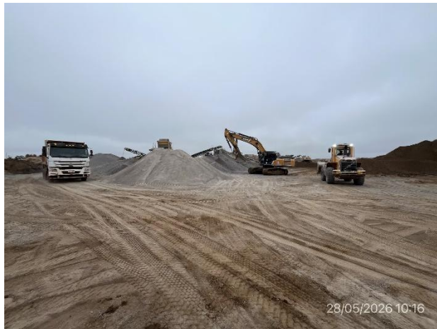
Foto 12.2-2, P05. Explanada de maniobras despejada y en buenas condiciones.
