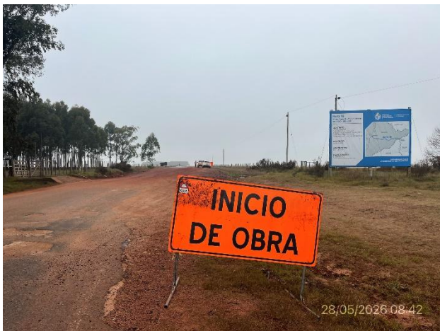
Foto 12.3-1, P01. Inicio de tramo. Ruta 19 progresiva 56K300, empalme con Ruta 6.
