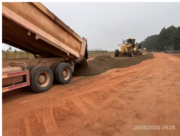
Foto 12.3-12, P08. Tareas de recargo de base granular en ejecución.
