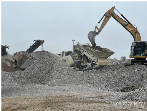
Foto 12.2-4, P05. Tren de tituración en operación. Buenas condiciones de trabajo apegadas al PGA.
