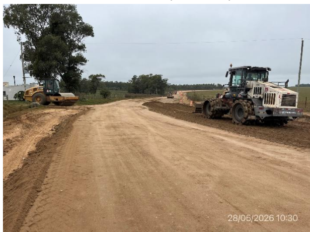
Foto 12.3-15, P09. Trabajos de recargo, compactación y perfilado de base granular en ejecución.
