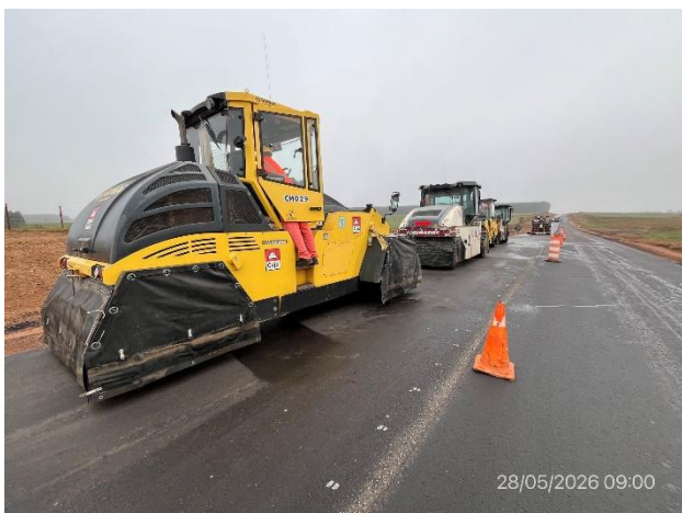
Foto 12.3-5, P06. Frente de obra, Ruta 19 progresiva 60K300.
