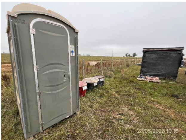
Foto 12.2-3, P05. Están presentes los servicios de bienestar reglamentarios para los operarios y la infraestructura para el acopio segregado de residuos en origen.
