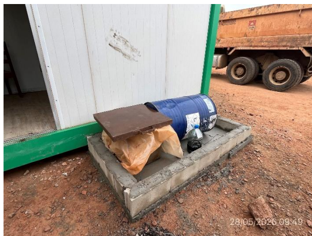
Foto 12.1-12, P03. Laboratorio de asfalto, el percloroetileno usado se acopia a la intemperie, con envallado perimetral sin techo.
