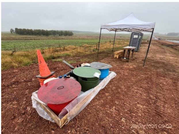
Foto 12.3-7, P06. Campamento provisorio, dotado de tarrinas para el acopio de residuos segregados y servicios de bienestar para los operarios.
