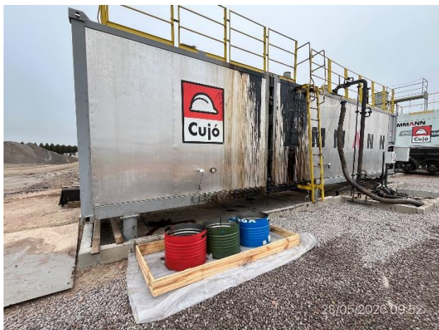
Foto 12.1-9, P03. Planta asfáltica, estación de acopio de residuos segregados en origen
