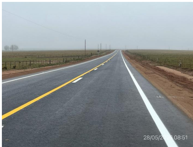
Foto 12.3-2. Ruta 19, tramo con calzada en mezcla asfáltica ejecutada.
