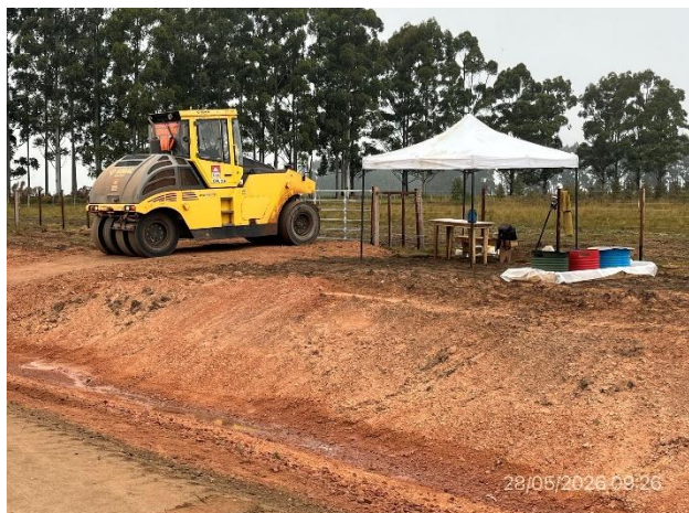
Foto 12.3-13, P08. Campamento provisorio, dotado de tarrinas para el acopio de residuos segregados y servicios de bienestar para los operarios
