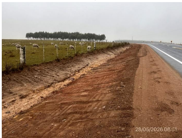
Foto 12.3-4. Ruta 19, tramo con cuneta correctamente conformada, pendientes suaves para contribuir al correcto escurrimiento pluvial.
