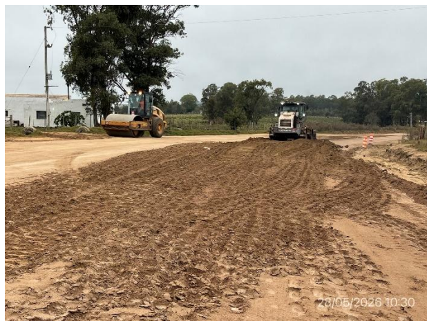
Foto 12.3-14, P09. Frente de obra, Ruta 19 progresiva 88K300.
