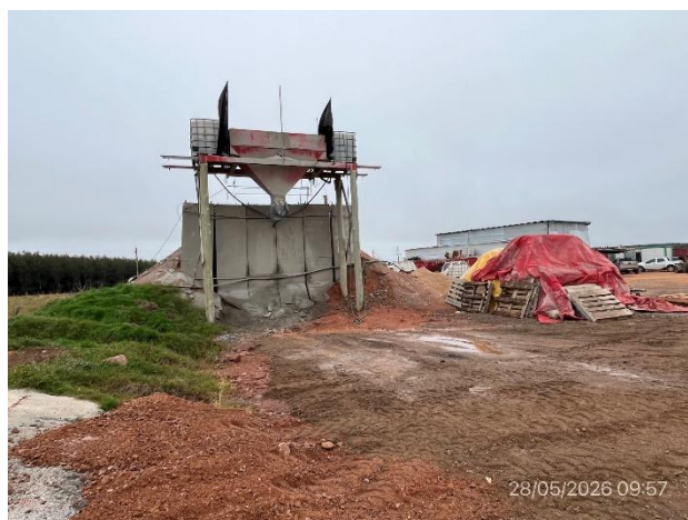
Foto 12.1-6, P03. Planta de hormigón. Buenas condiciones de orden y limpieza.
