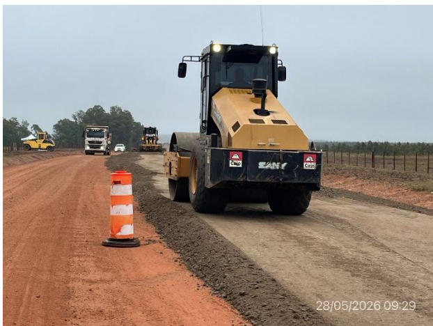
Foto 12.3-11, P08. Frente de obra, Ruta 19 progresiva 65K400.
