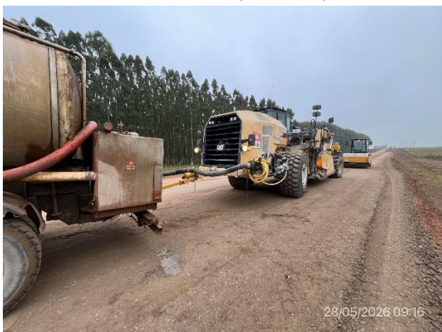
Foto 12.3-9, P07. Reciclado con cemento de base granular en ejecución.
