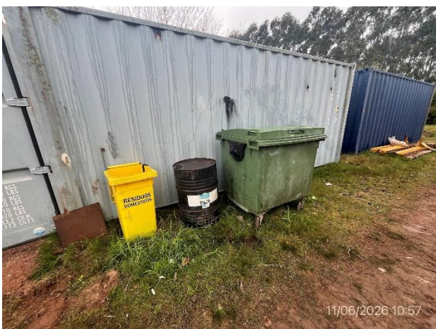
Foto 12.1-5, P03. Obrador, estación de acopio de residuos segregados en origen, tiene cartelera parcial.
