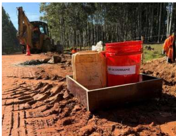
Foto 12.3-5, P06. Frente de obra, se incorporó kit para gestión de derrames y bandeja para alojar recipientes con combustibles.
