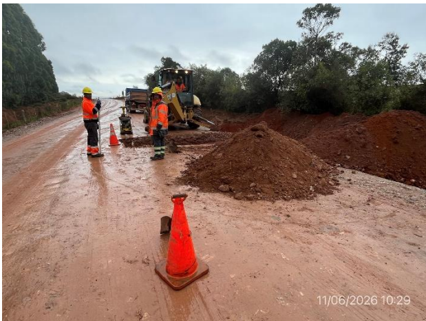
Foto 12.2-7, P06. Frente de obras, ejecución de alcantarilla. Corredor Forestal, progresiva 6K400.
