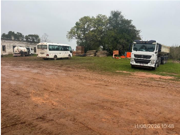
Foto 12.1-1, P03. Obrador de CVC SA. Padrón rural N°15648, 9ª SC de Cerro Largo.
