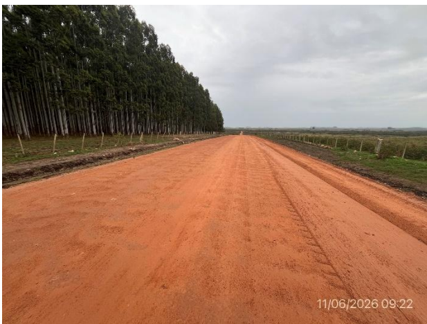
Foto 12.2-3, Corredor Forestal. Tramo con base granular ejecutada.
