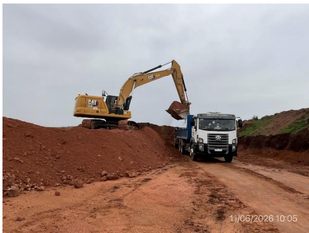
Foto 12.1-9, P04. Cantera de tosca, Padrón rural N°9869, 9ª SC de Cerro Largo. Proceso de carga en ejecución.
