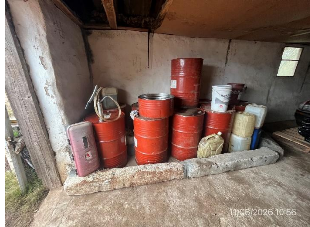
Foto 12.1-2, P03. Obrador, recinto techado y cerrado para acopio de lubricantes y productos químicos.
