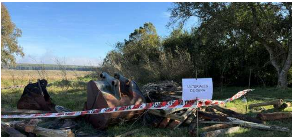
Foto 12.3-1, P03. Obrador de CVC SA. Se delimitaron las zonas de acopio de insumos y productos.
