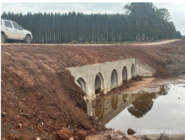
Foto 12.2-5, Corredor Forestal. Alcantarilla de 5 bocas ejecutada.
