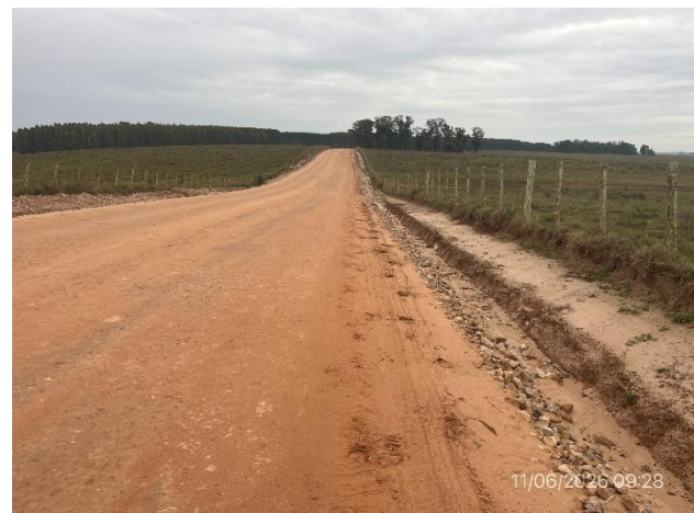
Foto 12.2-4, Corredor Forestal. Tramo con sub-base granular ejecutada. Cunetas perfiladas, contribuyen a correcto drenaje en etapa de obra.
