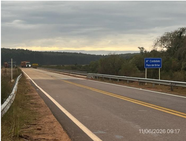
Foto 12.2-1, P01. Inicio del tramo en Corredor Forestal. Paso del Billar, puente sobre A° Cordobés.
