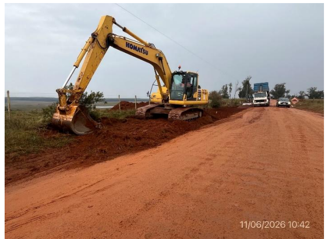
Foto 12.2-10, P07. Frente de obras, ejecución de ensanche de plataforma y recargo granular. Corredor Forestal, progresiva 13K200.
