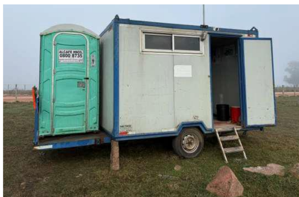
Foto 12.3-3, P07. Frente de obra, se incorporó un campamento móvil con servicios de bienestar y dotado de recipientes de residuos.
