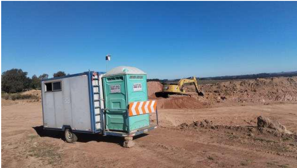
Foto 12.3-6, P04. Cantera de tosca, se incorporó un campamento móvil con servicios de bienestar y dotado de recipientes de residuos.
