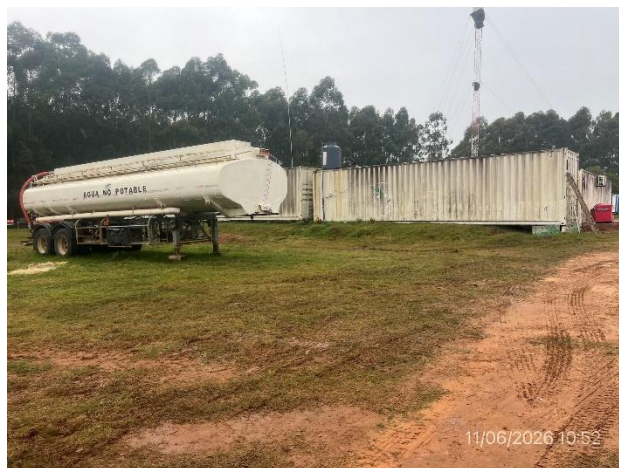
Foto 12.1-8, P03. Obrador, cisterna móvil y tanque fijo para acopio de agua no potable.
