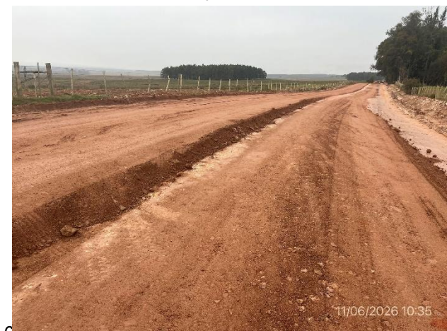
Foto 12.2-6, Corredor Forestal. Tramo con recargo de sub-base y base granular realizado en media calzada.
