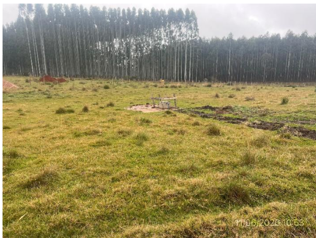
Foto 12.1-7, P03. Obrador, perforación para abastecimiento de agua no potable al obrador.
