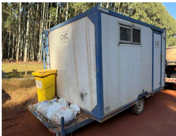
Foto 12.3-4, P06. Frente de obra, se incorporó un campamento móvil con servicios de bienestar y dotado de recipientes de residuos.
