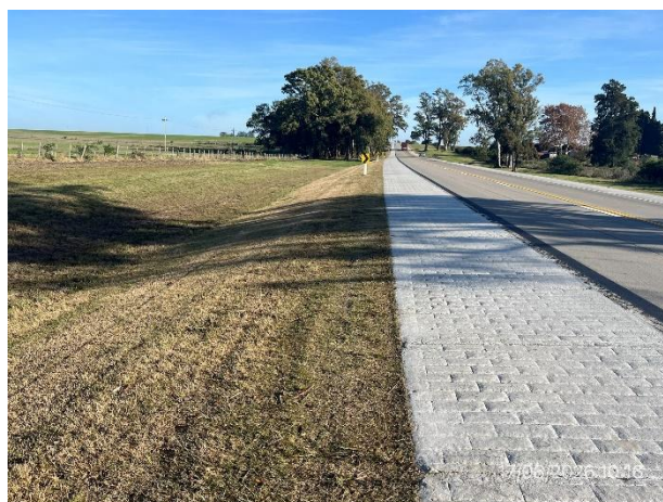
Foto 12.1-4. Banquina ejecutada, Ruta 3 senda a (-). Faja pública en buenas condiciones de empastado vegetal, con pendientes suaves y libre de residuos.
