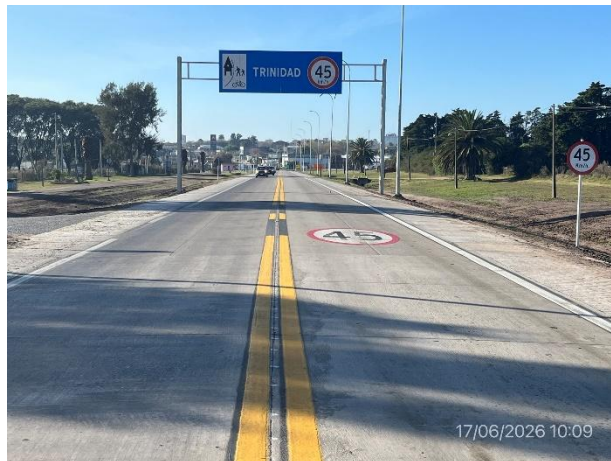
Foto 12.1-2, P01. Inicio del tramo, banquetas en hormigón construidas en sendas a (+) y a (-) de Ruta 3.
