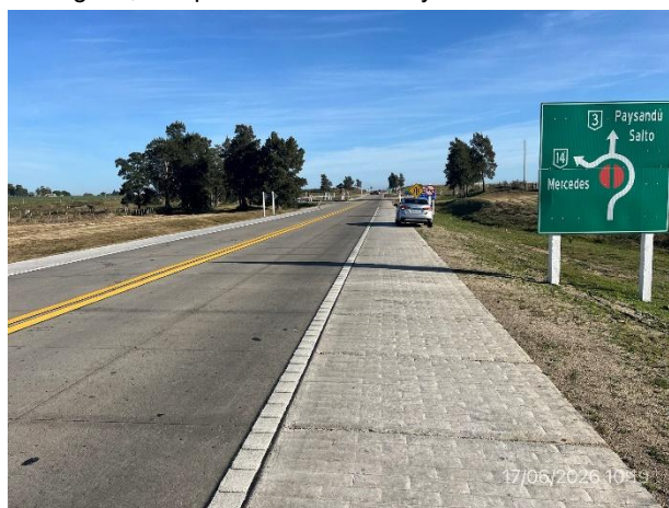
Foto 12.1-6, P02. Fin del tramo, Ruta 3 progresiva 198K000. Empalme con Ruta 14.
