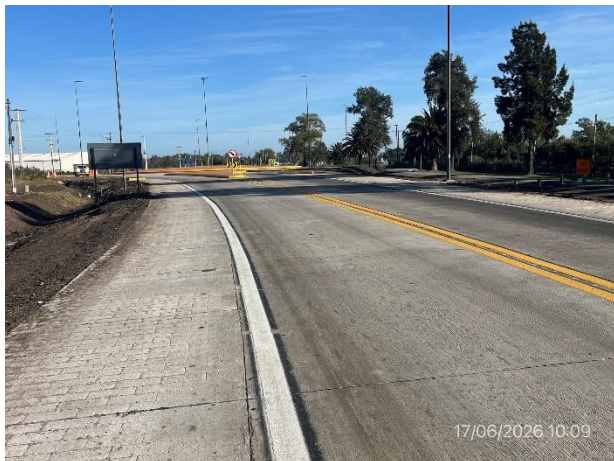
Foto 12.1-1, P01. Inicio del tramo, Ruta 3 progresiva 191K100, acceso Oeste a Trinidad.
