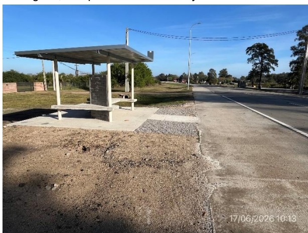
Foto 12.1-5. Refugio peatonal y dársena para buses ejecutados.
