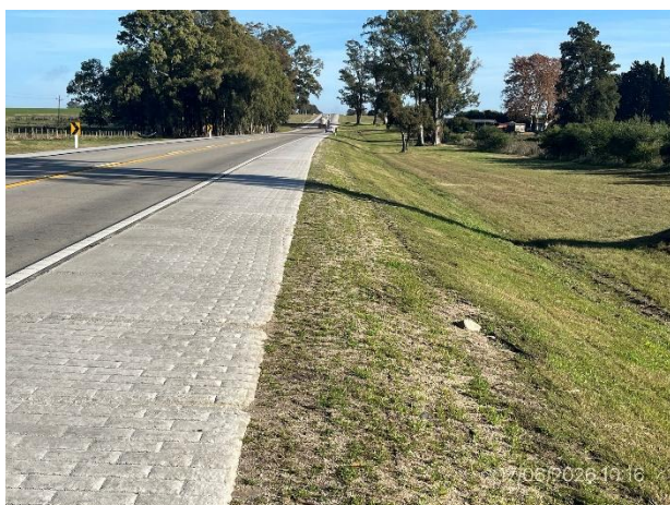
Foto 12.1-3. Banquina ejecutada, Ruta 3 senda a (+). Faja pública en buenas condiciones de empastado vegetal, con pendientes suaves y libre de residuos.
