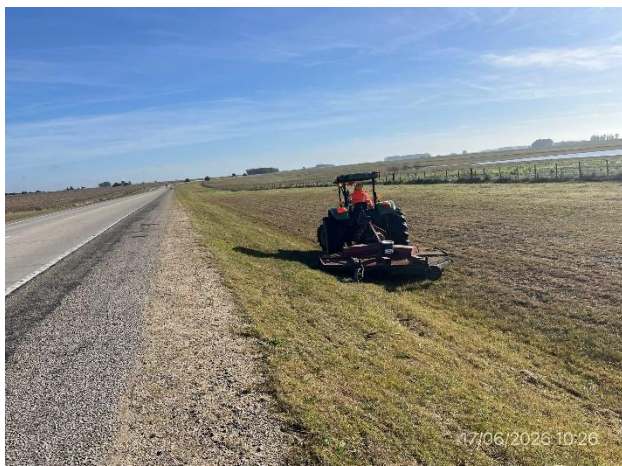
Foto 12.1-13, P07. Frente de obras de mantenimiento rutinario. Ruta 3, progresiva 200K900. Faja pública con pendientes suaves y en buenas condiciones de limpieza.
