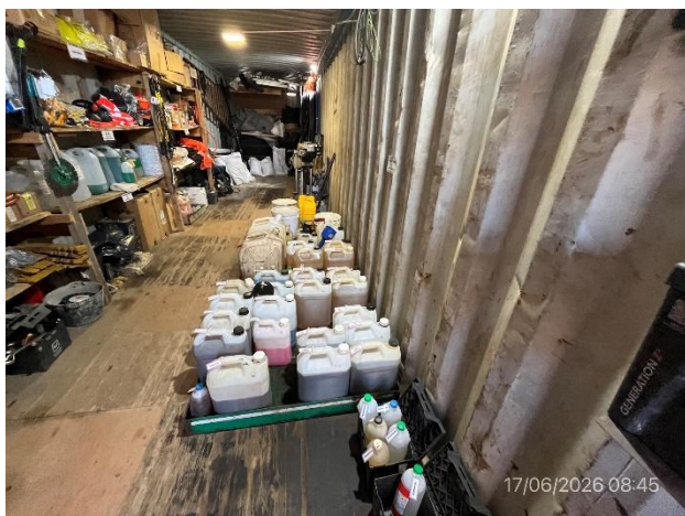
Foto 12.1-9. P06, Los lubricantes y combustibles están acopiados en bidones sobre bandejas estancas.
