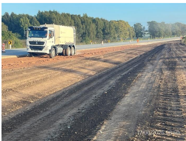
Foto 12.1-3, P06. Tendido de base granular ejecutado.
