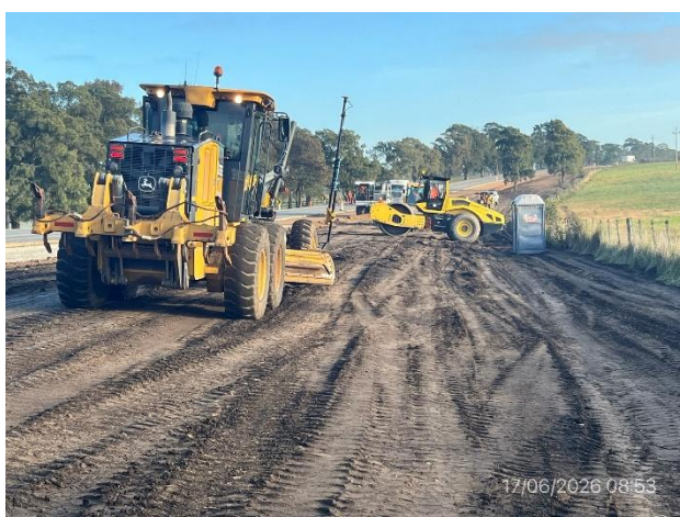
Foto 12.1-5, P06. Perfilado de sub-base en ejecución.
