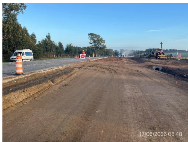
Foto 12.1-2, P06, Frente de obras, ejecución de 3eros carriles. Ruta 3, progresiva 133K500 a (+).
