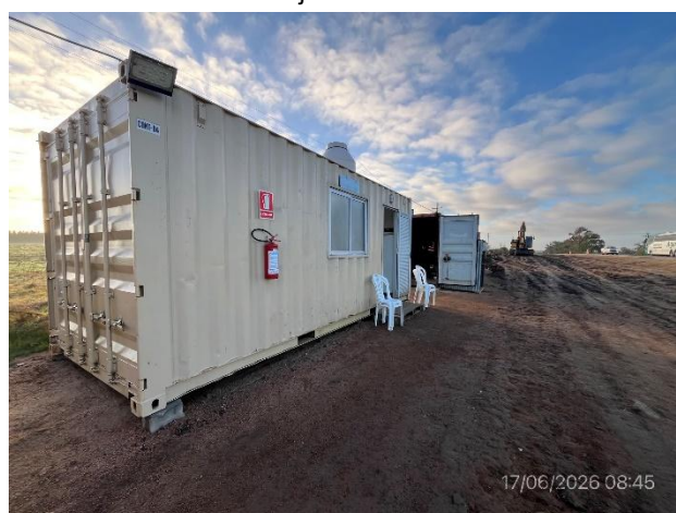
Foto 12.1-6, P06. Campamento provisorio de ejecución de 3eros carriles. Ruta 3, progresiva 133K500 a (+).
