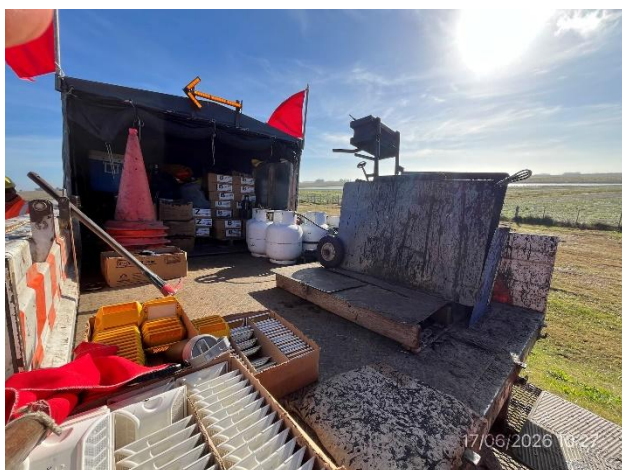
Foto 12.1-15, P07. Cuadrilla de mantenimiento de señalización horizontal.
