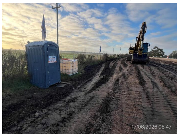
Foto 12.1-12. P06, La plataforma de maniobras del campamento provisional está en buenas condiciones, libre de residuos.
