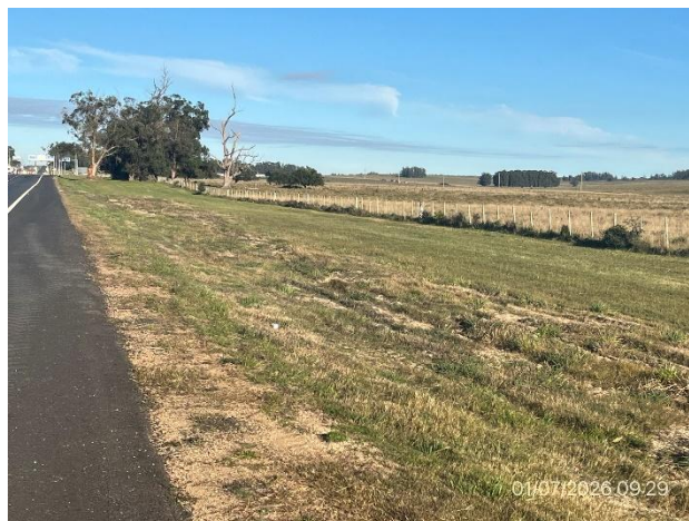
Foto 12.1-8, P02. Faja pública en buenas condiciones de abandono con pendientes suaves que favorecen condiciones adecuadas de drenaje.
