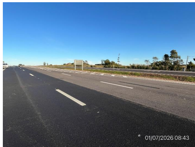
Foto 12.1-2, P01. Carpeta asfáltica y obras de señalización terminadas.
