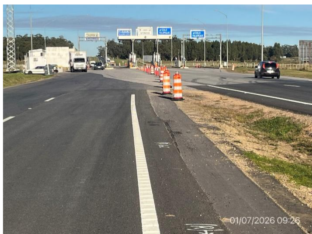
Foto 12.1-5, P02. Obra terminada, accesos a Peaje Garzón. Ruta 9, tramo 190K500 - 191K900.
