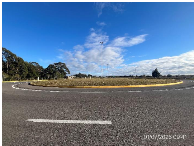
Foto 12.1-13, P04. Obra terminada, rotonda en intersección con C° Sauce de Rocha. Ruta 9, tramo 199K700 – 200K200.
