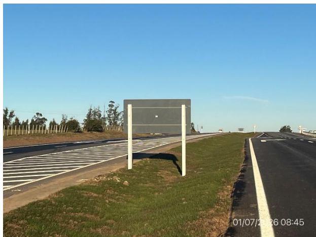
Foto 12.1-3, P01. Obras de señalización vertical terminadas, canchero central con pendientes suaves.
