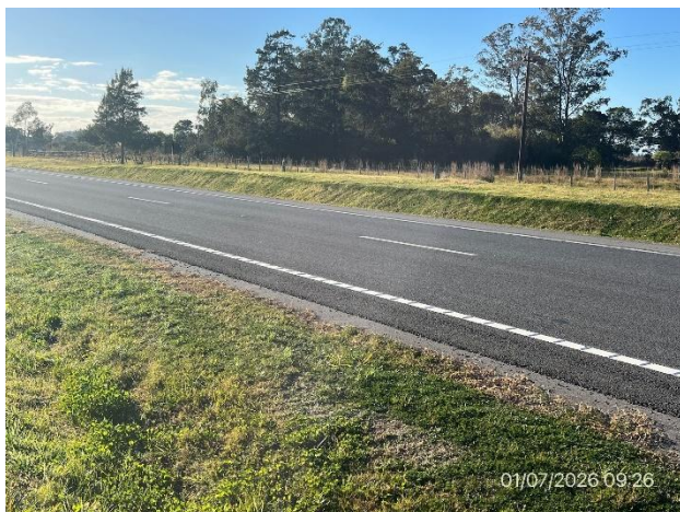
Foto 12.1-7, P02. Calzada en mezcla asfáltica y obras de señalización horizontal terminadas.
