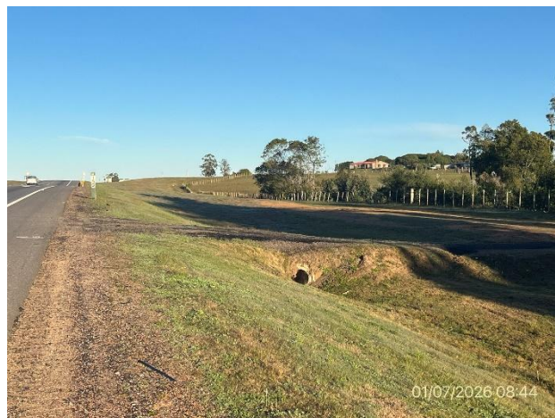
Foto 12.1-4, P01. Faja pública en buenas condiciones de abandono con drenajes adecuados.
