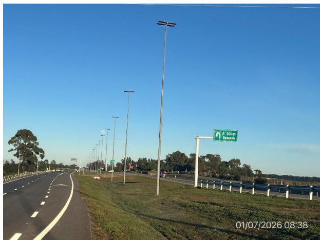
Foto 12.1-1, P01. Obra terminada, medio retorno. Ruta 9, tramo 151K800 – 152K400.
