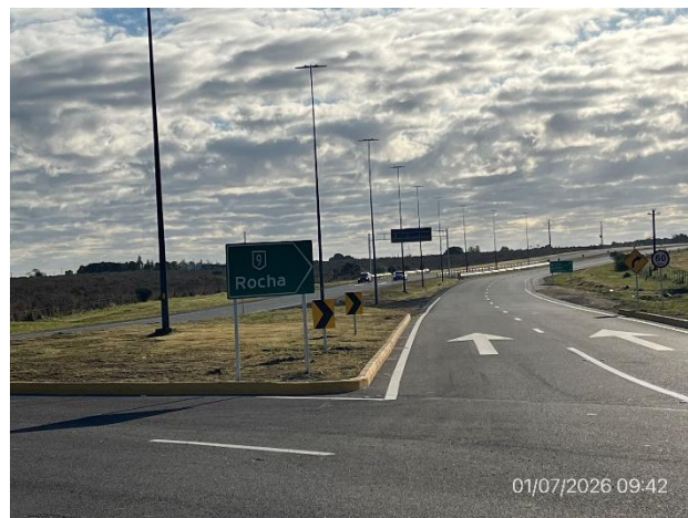
Foto 12.1-14, P04. Carpeta asfáltica y obras de iluminación terminadas.
