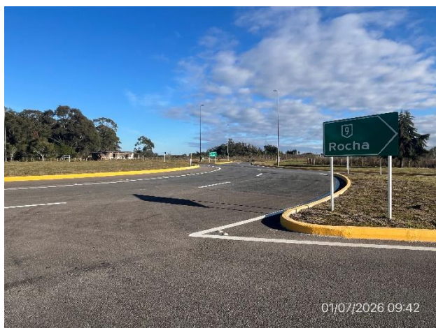
Foto 12.1-15, P04. Obras de señalización vertical y horizontal terminadas.
