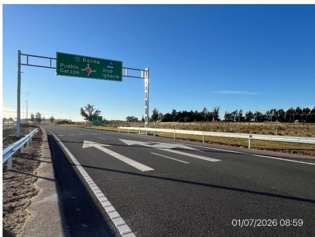
Foto 12.1-11. P03, obras de señalización vertical terminadas.
