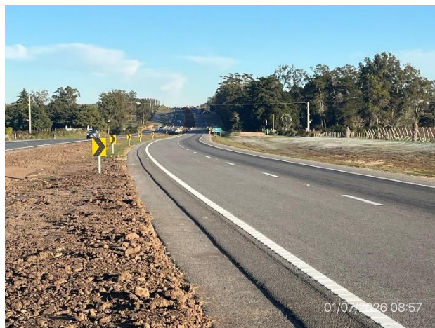
Foto 12.1-10. P03, carpeta asfáltica y obras de señalización terminadas.
