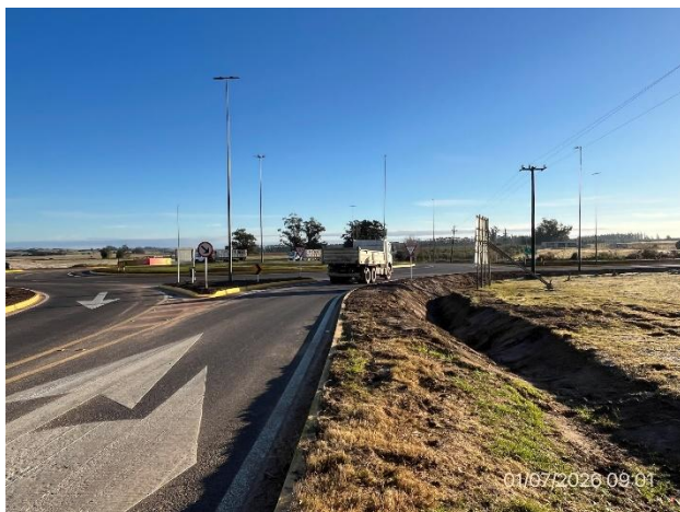
Foto 12.1-9, P03. Obra terminada, rotonda en intersección con Cº Eugenio Sainz. Ruta 9, tramo 160K600 – 161K000. Obras de iluminación terminadas.
