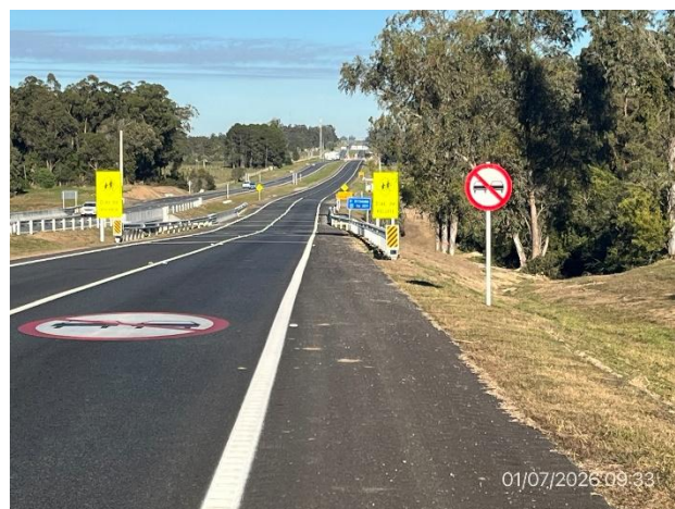
Foto 12.1-6, P02. Obra terminada, accesos al A° Canelón. Ruta 9, tramo 190K500 - 191K900.
