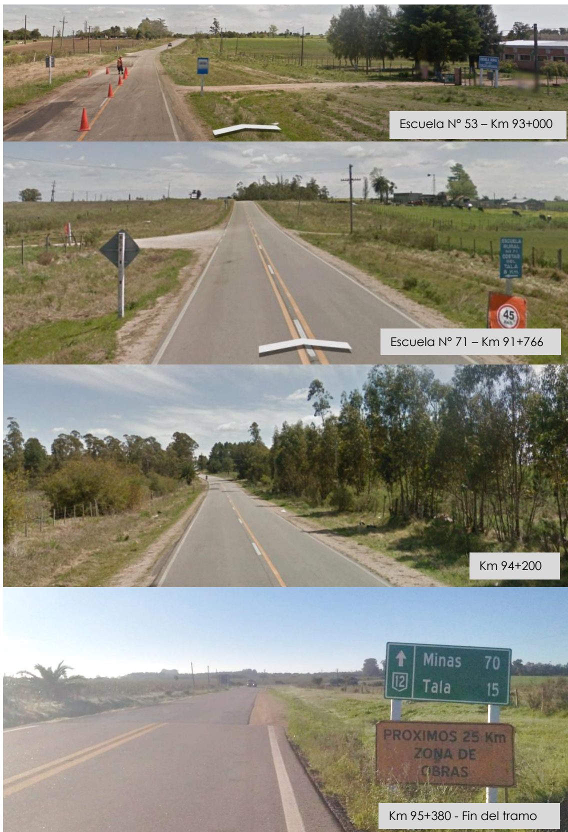
Figura 7 Situación preoperacional de algunos sectores de la faja pública (Google Earth, Street View, 2015)
