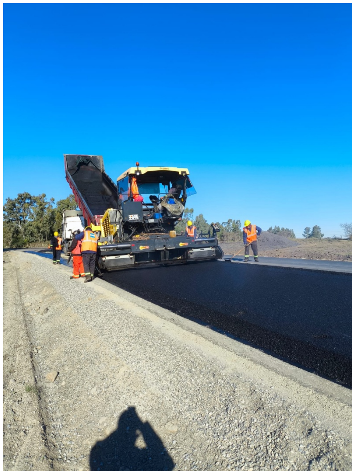
Imagen 3: tendido de base negra
