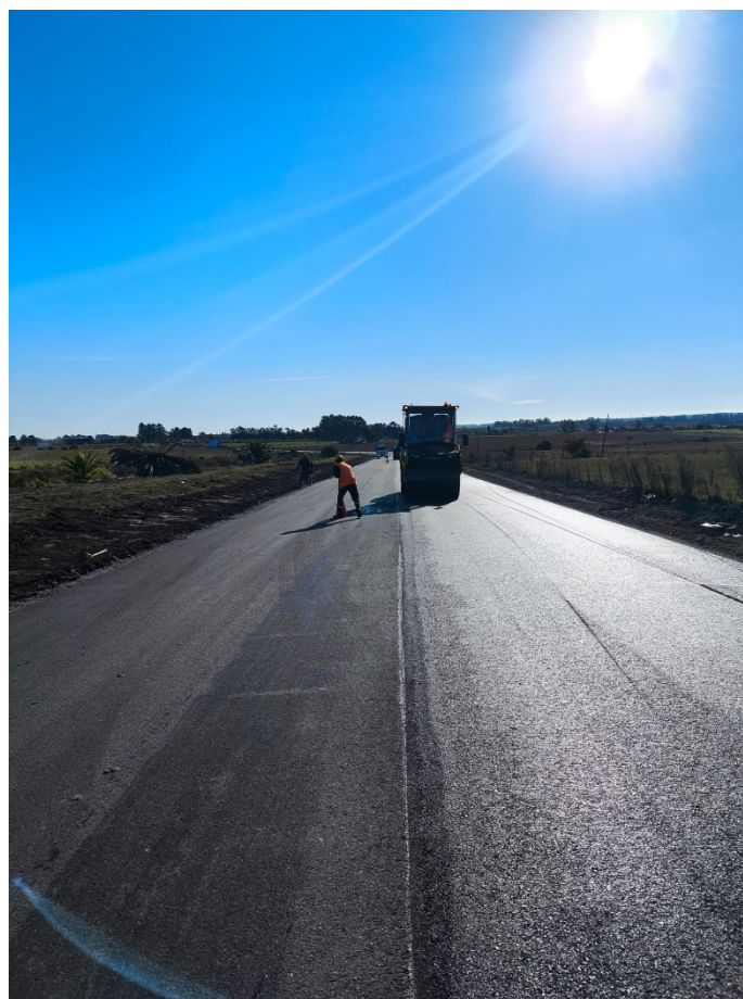
Imagen 2: Tendido de base negra
