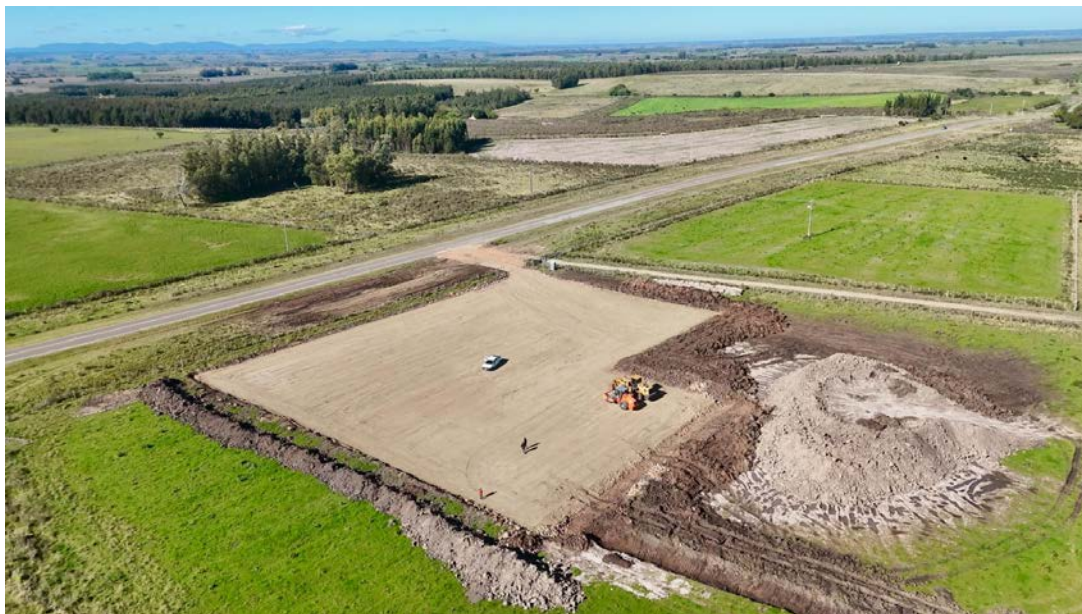
Imagen 1: Instalación planta de asfalto
