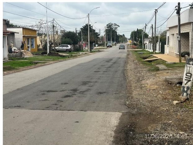
Foto 12.1-2, Ruta 12. Bacheos en mezcla asfáltica ejecutados en planta urbana de San Ramón.
