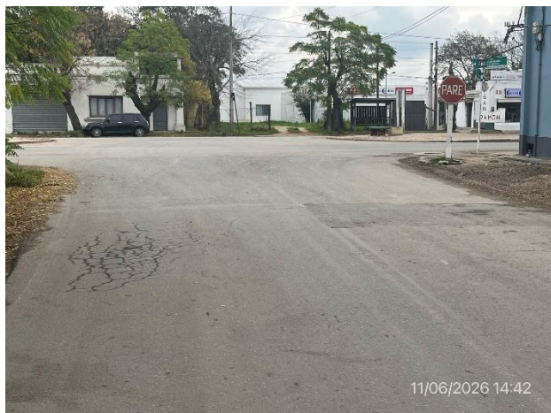
Foto 12.1-1, P02. Empalme de Ruta 12 progresiva 97K100 con Ruta 6. Planta urbana de San Ramón.
