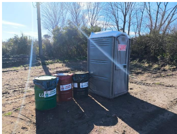
Foto 12.3-2, P07. Frente de obras, ejecución de veredas peatonales. Se incorporó baño químico e infraestructura para acopio de residuos en la zona de trabajo.
