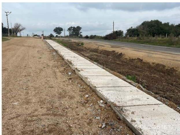
Foto 12.1-11, P07. Frente de obra, ejecución de veredas peatonales, Tala. Ruta 12 progresiva 85K400.
