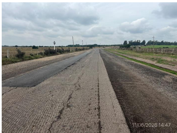
Foto 12.1-3, Ruta 12, tramo con calzada fresada y ensanche granular cementado ejecutado.
