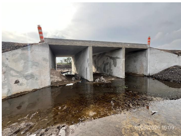
Foto 12.1-9, Ruta 12. Alcantarilla H terminada, subcontratista SACEEM.
