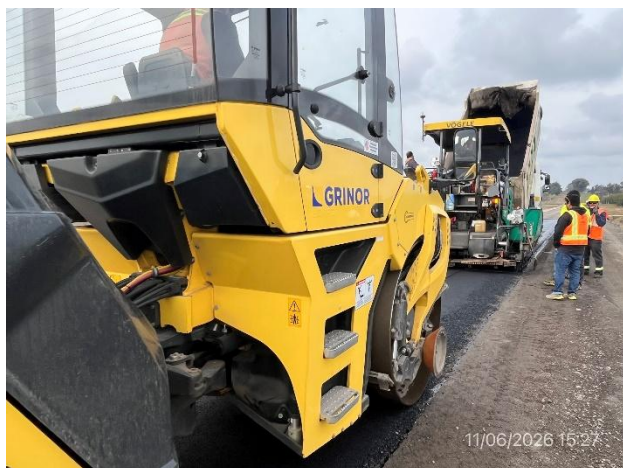
Foto 12.1-7, P06. Tendido y compactación de mezcla asfáltica en ejecución.
