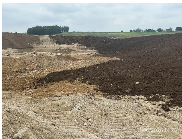
Foto 12.2-2, P04. No hay actividades extractivas. Se realizaron tareas de remediación ambiental por medio suavizado de pendientes en taludes.
