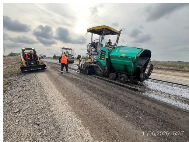
Foto 12.1-6, P06. Frente de obra, bacheo en mezcla asfáltica en ejecución. Ruta 12 progresiva 85K400.
