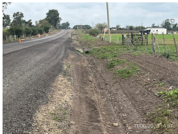
Foto 12.1-4, Ruta 12. Tramo con ensanche ejecutado y cunetas perfiladas.
