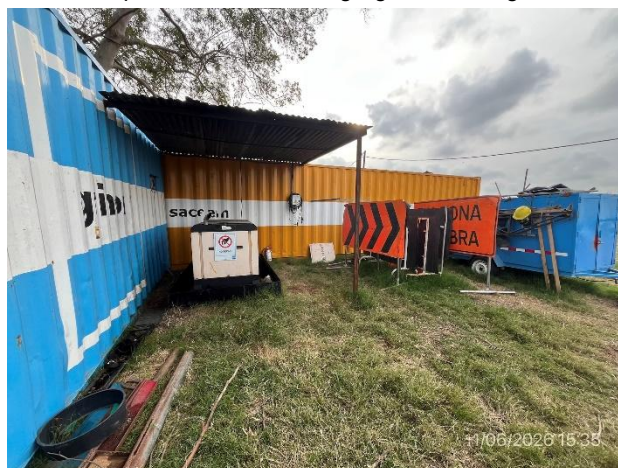
Foto 12.2-6, P05. Zona techada y con bandeja estanca para alojar generador eléctrico.
