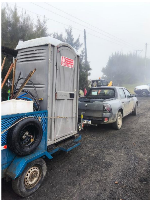
Foto 12.3-1, P06. Frente de obras, bacheo en mezcla asfáltica. Se incorporó baño químico en la zona de trabajo.
