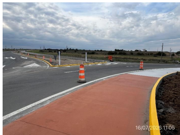
Foto 12.1-16, P02. Fin del tramo. Obras de señalización horizontal y vertical en ejecución.
