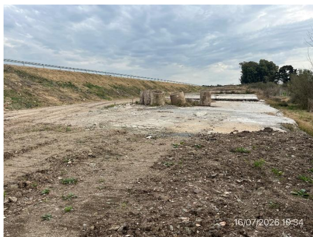
Foto 12.1-8, P06. Campamento provisorio, está pendiente de ejecutar la remediación ambiental en la zona del campamento provisorio abandonado.
