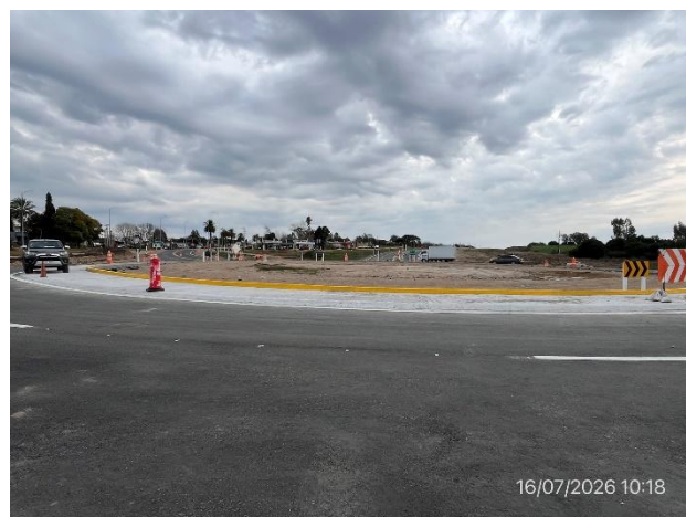
Foto 12.1-2, P01. Bypass Ruta 1 progresiva 119K800. Rotonda de empalme con Ruta 1 en construcción.
