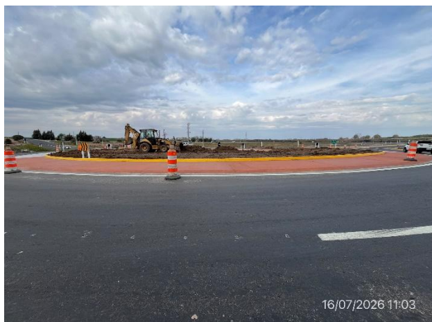
Foto 12.1-15, P02. Fin del tramo. Bypass Ruta 1 progresiva 126K700, empalme Oeste con Ruta 1, Colonia Valdense.
