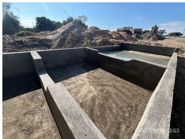
Foto 12.2-8, P03. Obrador. Planta de hormigón. Pileta de sedimentación de aguas de lavado.
