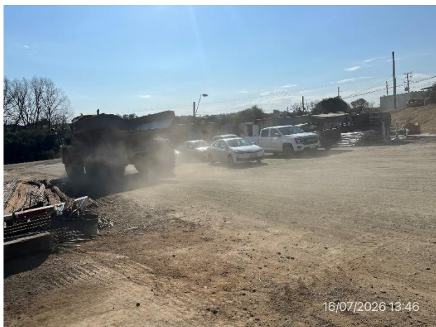
Foto 12.22-1, P03. Obrador principal y planta asfáltica. Padrón rural N° 18.160, 12ª SC. de Colonia.
