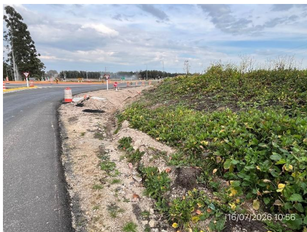
Foto 12.1-11, P07. Hay un acopio de suelo vegetal en la faja pública, pendiente de ser distribuido para la cobertura de taludes y cunetas de la rotonda en construcción.
