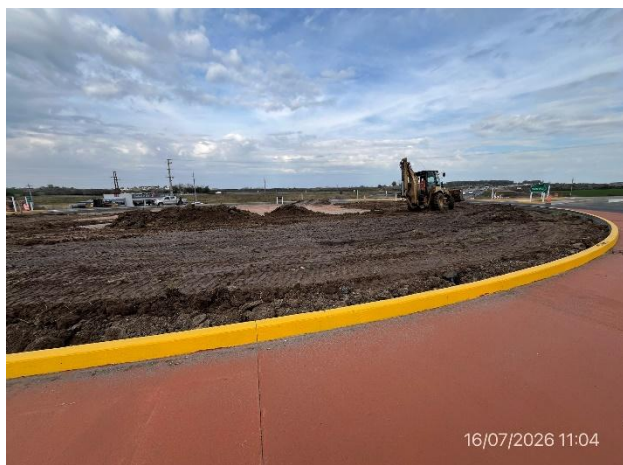
Foto 12.1-17, P02. Obras de remediación ambiental y perfilado de desagües en rotonda en ejecución.
