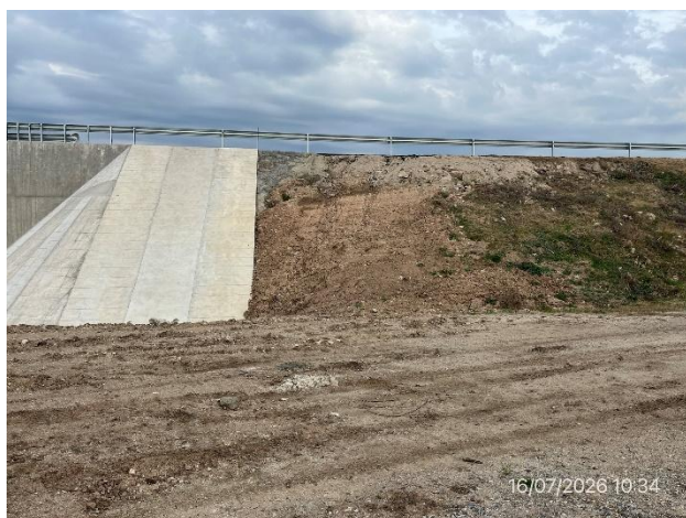
Foto 12.1-7, P06. Obras en puente sin actividad. Está pendiente de ejecutar la cobertura vegetal de los taludes de acceso
