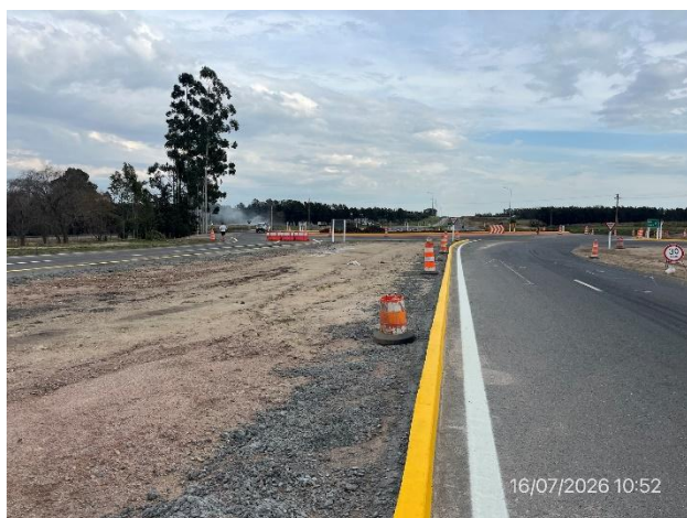
Foto 12.1-9, P07. Bypass Ruta 1 progresiva 123K100. Rotonda de empalme con Ruta 61 en ejecución.
