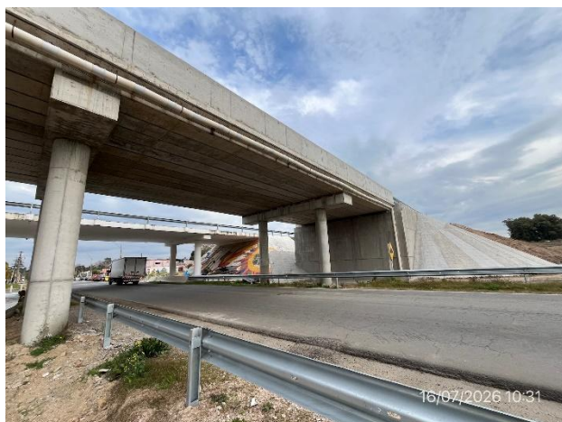
Foto 12.1-5, P06. Bypass Ruta 1 progresiva 120K700. Intercambiador con Ruta 52.
