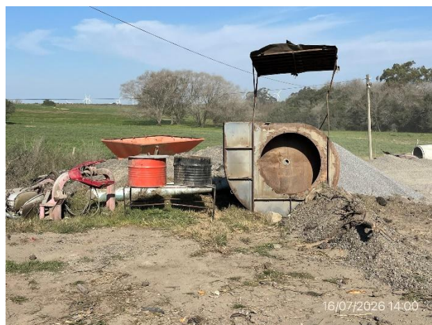
Foto 12.2-12, P03. Obrador. Estación de acopio de residuos segregados en origen. Hay chatarra dispersa.
