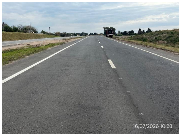
Foto 12.1-13, Bypass Ruta 1. Tramo con carpeta asfáltica en calzada y señalización horizontal ejecutada.
