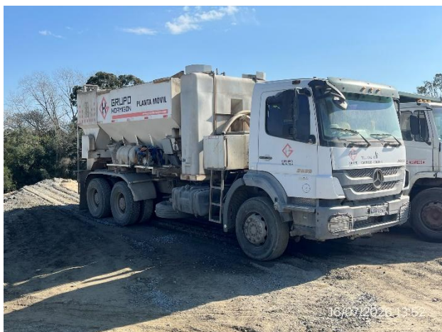
Foto 12.2-7, P03. Planta de hormigón, zona de maniobras y estacionamiento de maquinarias.
