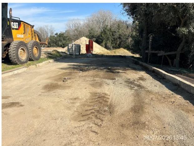
Foto 12.2-3, P03. Obrador, zona de lavado de camiones con cordoneta perimetral y pendientes hacia pileta de decantación de hidrocarburos.
