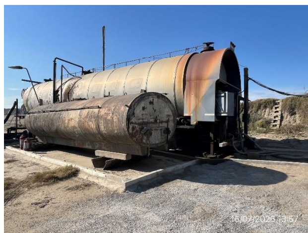
Foto 12.2-10, P03. Planta asfáltica. Tanques de asfalto y de emulsión en recinto con pavimento impermeable y envallado perimetral estanco.
