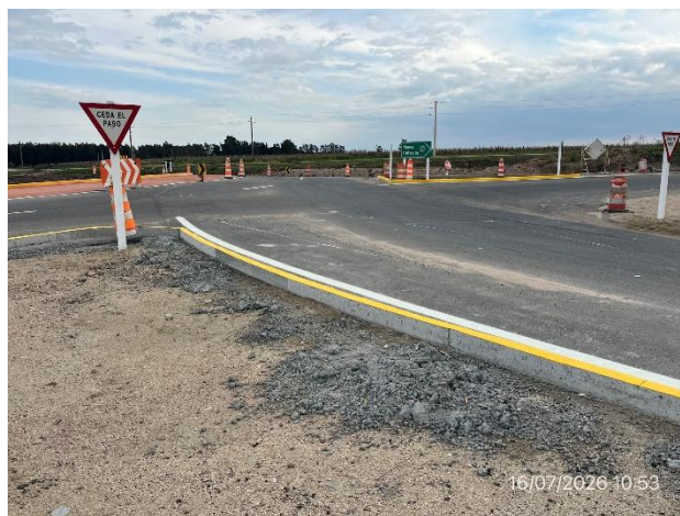
Foto 12.1-12, P07. Carpeta de rodadura en mezcla asfáltica ejecutada en tramo y empalmes. Obras de señalización parcialmente ejecutadas.
